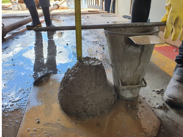
Figura 3.12 – Teste de consistência do concreto ( slump test )
