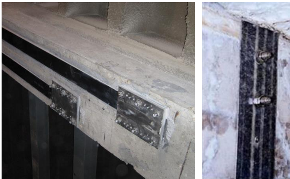
Figura 2.3 – Exemplos de ancoragem em reforço por tiras de FRP. Fonte: fib Bulletin 90 (2019).
