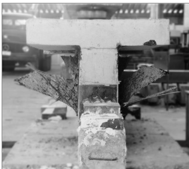
Figura 2.2 – Exemplo de descolamento em viga reforçada ao cisalhamento com mantas de CFRP. Fonte: Salles Neto (2000).
