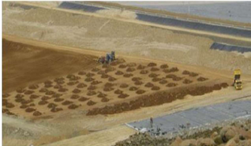
Figura 2-1 – Empilhamento de rejeito. Fonte: (Santos, 2022)
