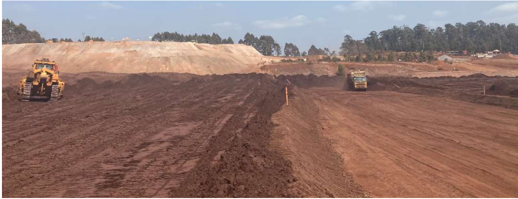
Figura 3-6 Equipamentos de espalhamento do rejeito ( trator Bulldozer) e caminhão rodoviário para transporte do material. Fonte : o autor
