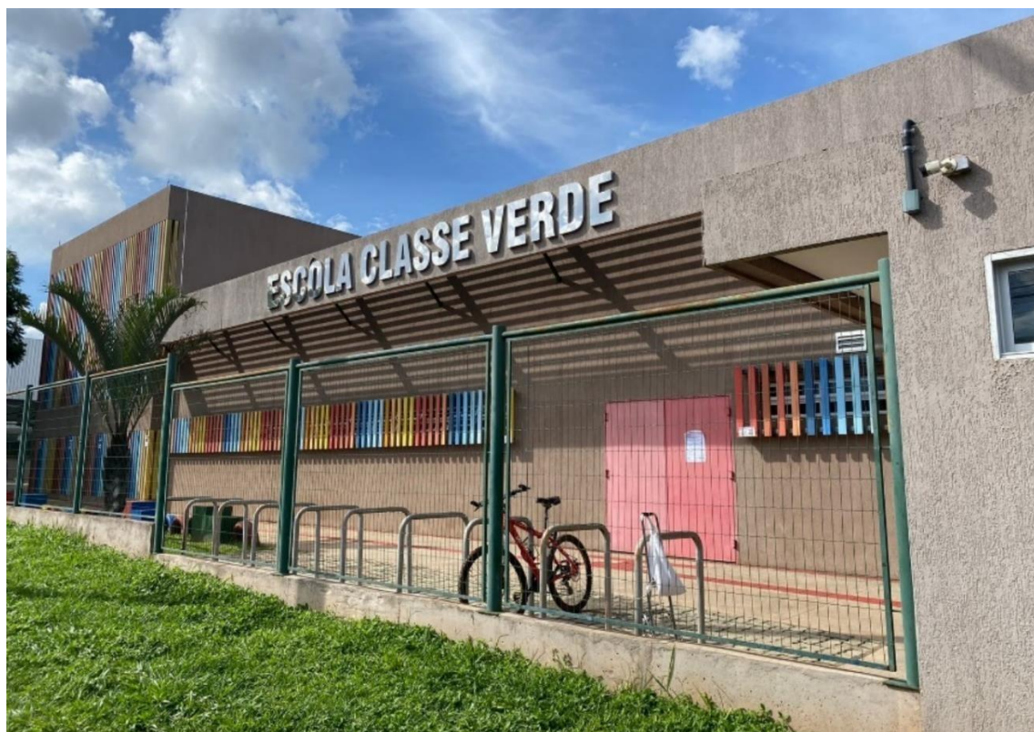
Figura 12 - Fachada frontal- Autoral.
