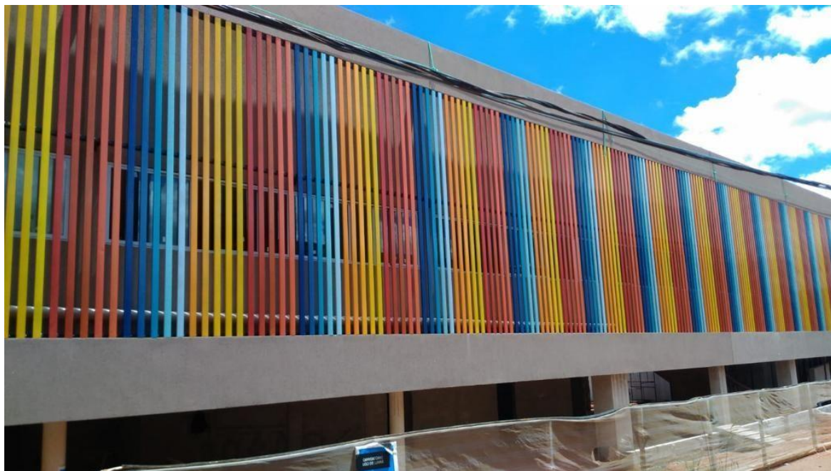
Figura 14 - Fachada lateral esquerda - Rodolpho Pontes.
