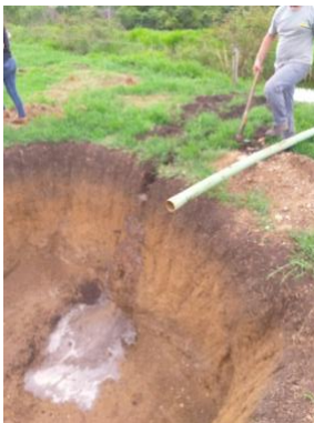
Instalação do tubo de captação da Ac
