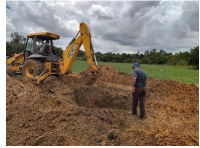
Escavação dos tanques
