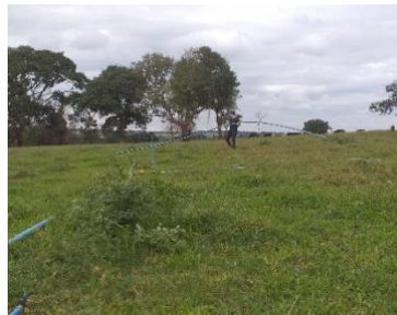
Montagem do sistema de irrigação
