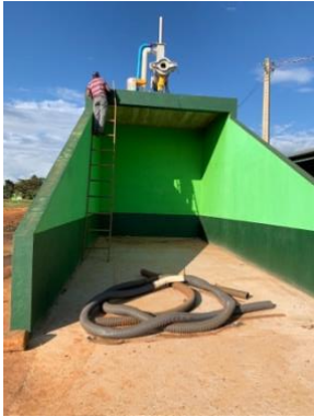
Pátio de resíduos sólidos da ARB
