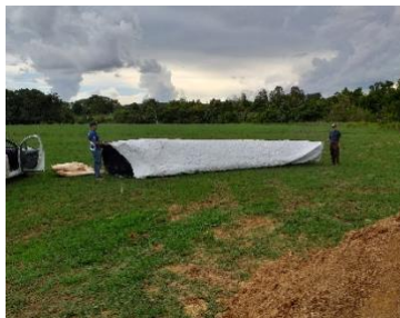
Lona para silagem utilizada no revestimento do tanque de ARB
