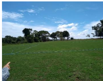
Montagem do sistema de irrigação
