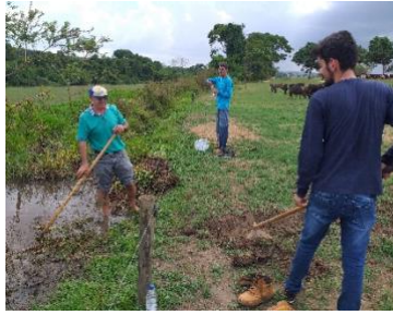
Limpeza do canal de derivação de Ac
