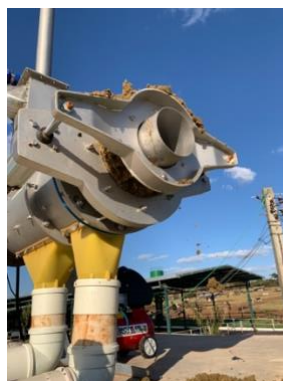
Bomba pneumática de separação de sólidos da ARB
