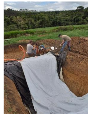
Revestimento do tanque de ARB e montagem da bomba
