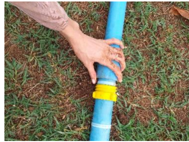
Montagem do sistema de irrigação
