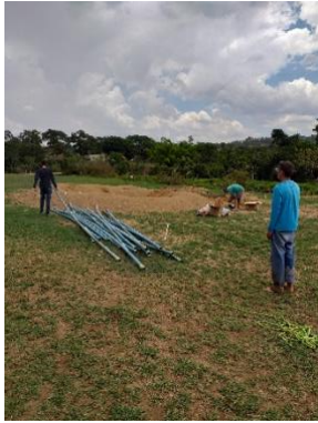
Montagem do sistema de irrigação
