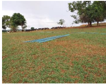
Montagem do sistema de irrigação
