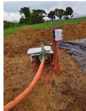
Bomba centrífuga de 3 cv Schneider
