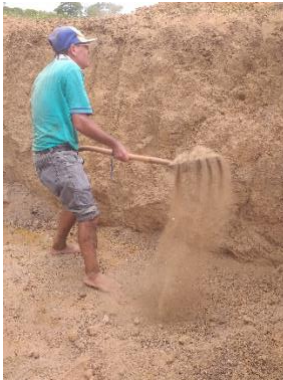
Acabamento dos tanques escavados
