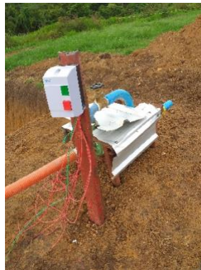
Bomba centrífuga de 3 cv Schneider
