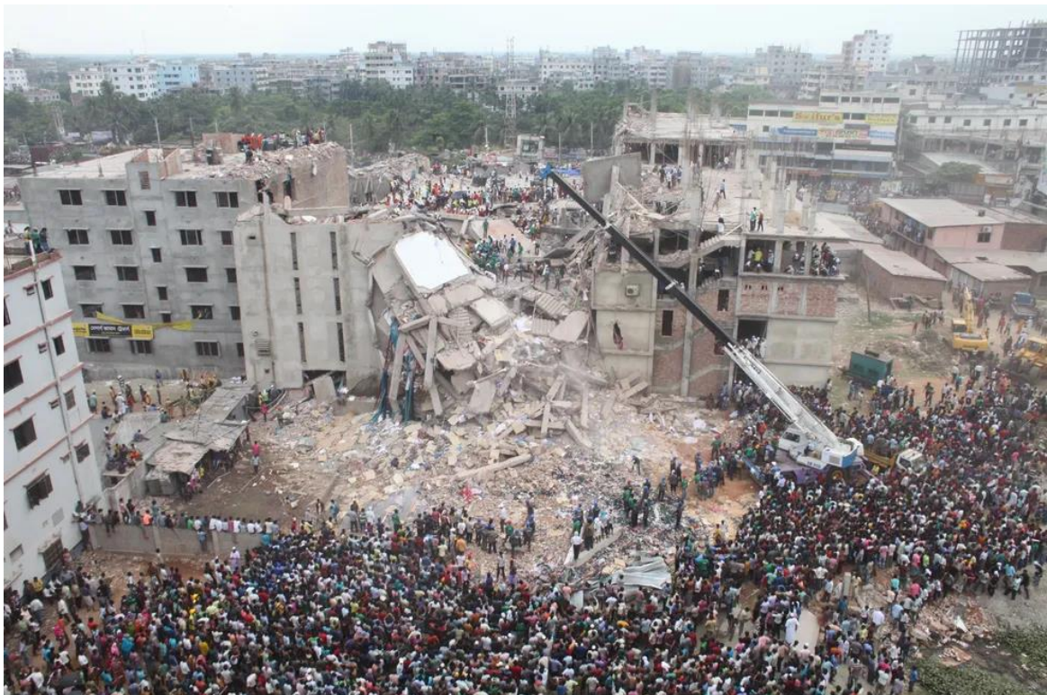
Figura 3.5 - Colapso do Rana Plaza em 2013. Fonte: Getty Images 74
