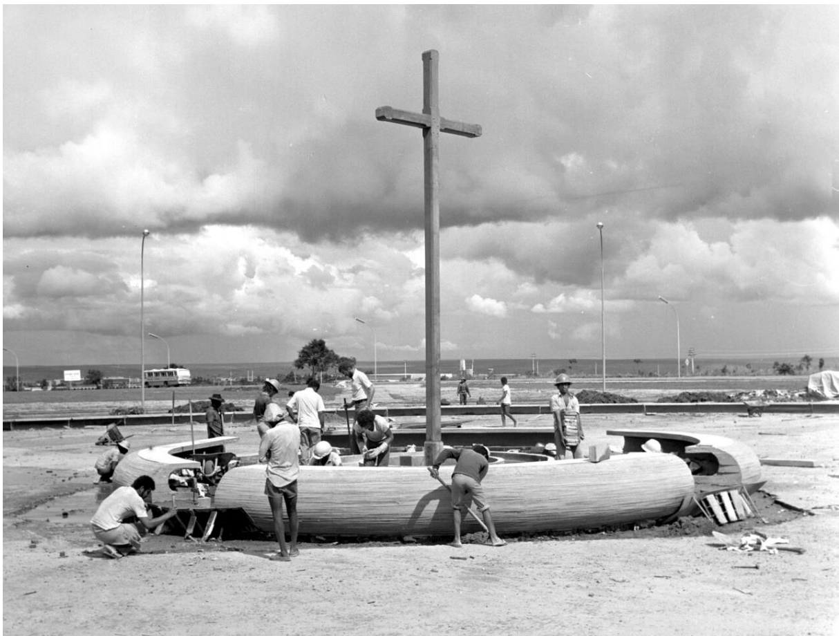
Figura 36. Construção da Praça do Cruzeiro (1974).
