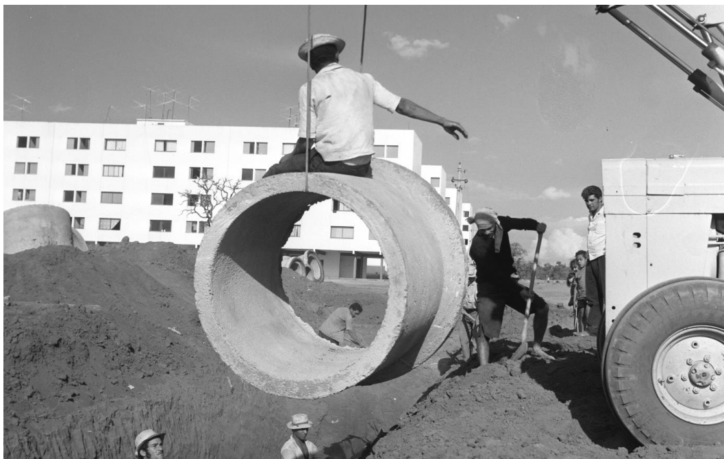
Figura 62. Obras de drenagem no Cruzeiro Novo (1970). Fonte: ARPDF (2023).
