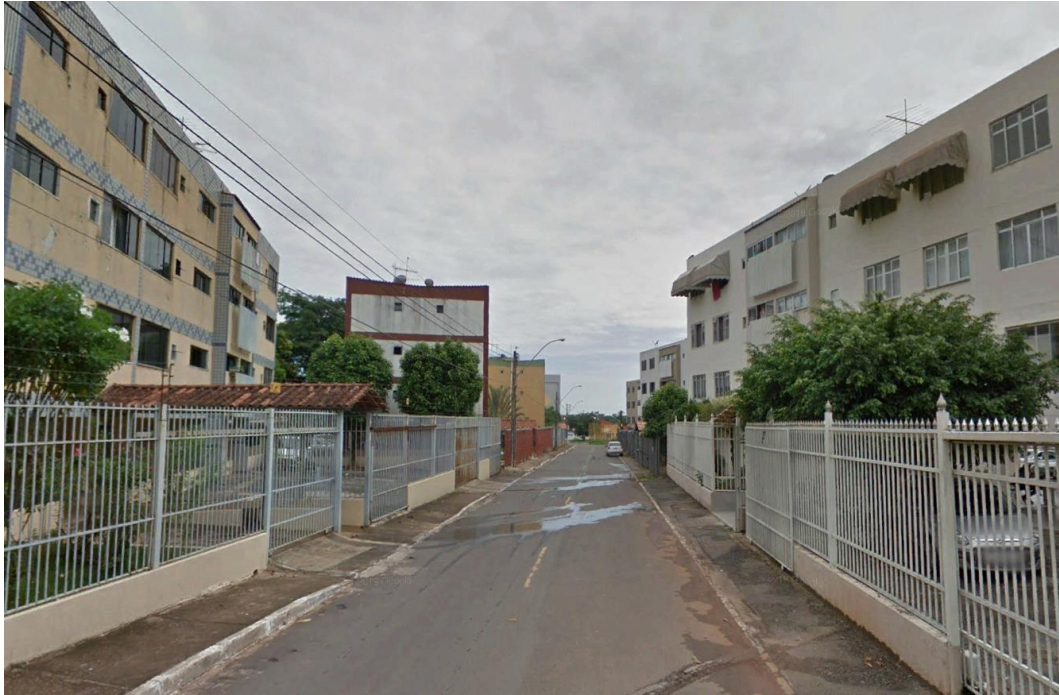
Figura 98. QELC, QE 1. Fonte: GOOGLE STREET VIEW (2021).
