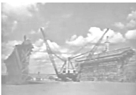
99 Concretagem simultânea em dois quadros (Figura 172), um guindaste para um quadro
