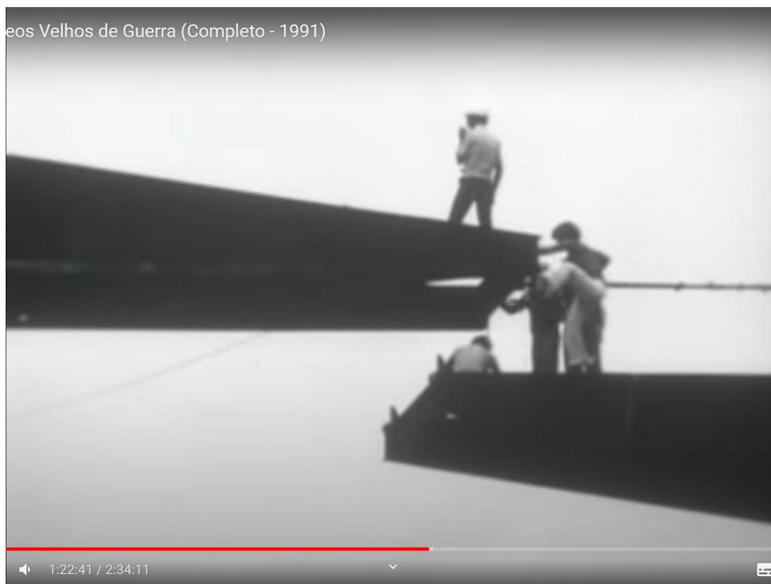
Figura 10 - Trabalhadores candangos durante a construção de ponte em Brasília (CARVALHO, 1990).
