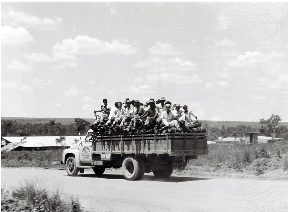
Figura 48 - Trabalhadores candangos indo em direção aos canteiros de obras. Disponível em: https://www.arquivopublico.df.gov.br/nucleos-de-apoio/ . Acesso em: 26/02/2024.
