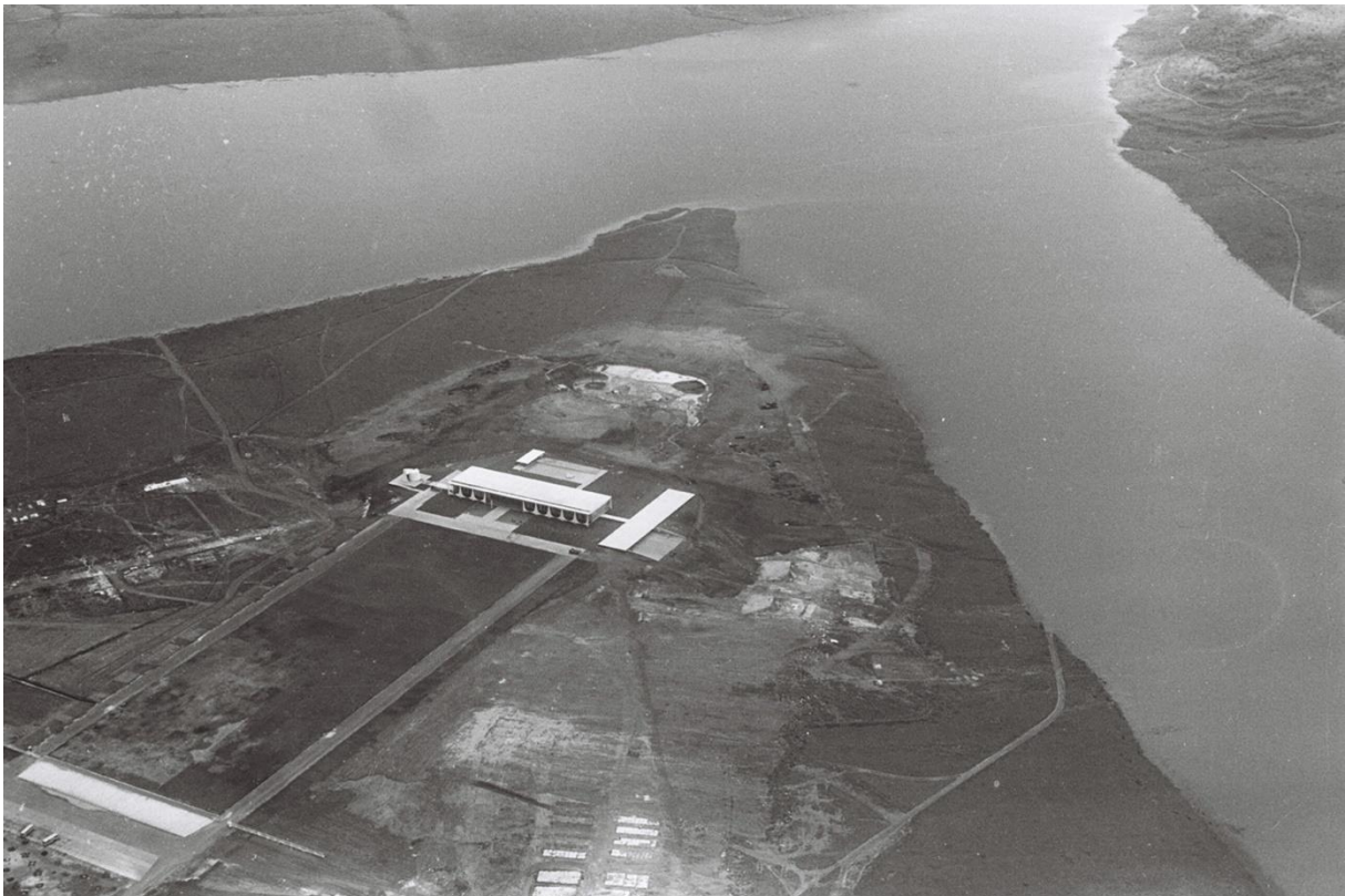
Figura 46 - Vista aérea do Lago Paranoá, com Palácio da Alvorada ao centro. Disponível em: https://www.arquivopublico.df.gov.br/lago-paranoa/ . Acesso em: 26/02/2024.
