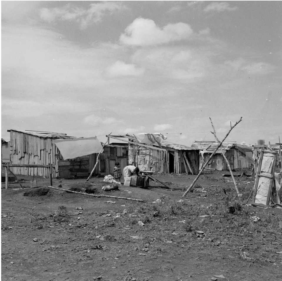
Figura 63 - Moradias na Vila Amaury em 1959. Foto tirada pelo fotógrafo Marcel Gautherot em 1960. Detentor dos direitos autorais: Instituto Moreira Salles.
