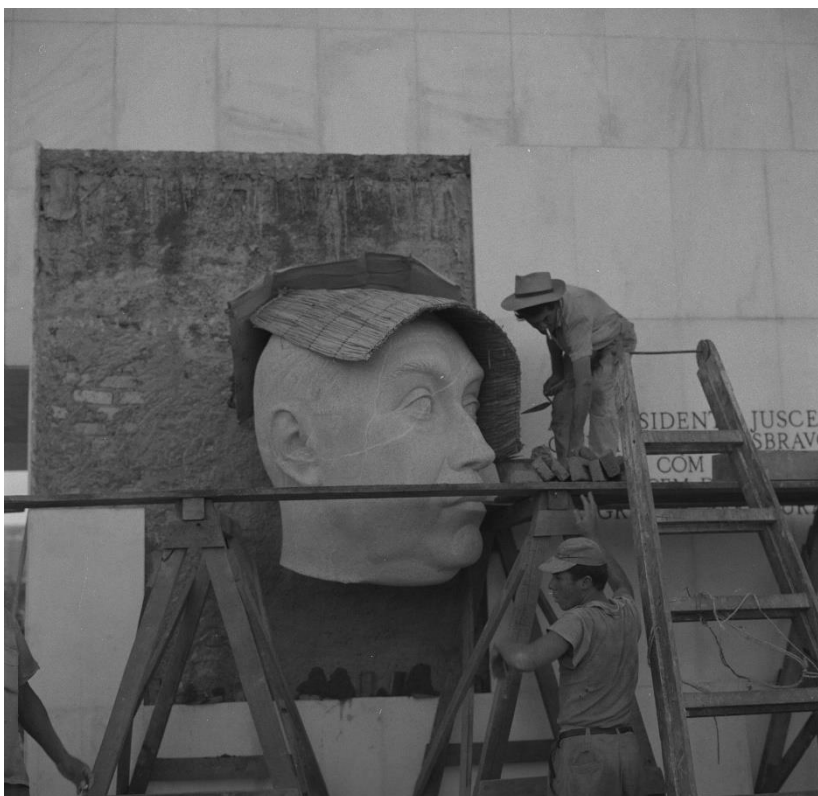
Figura 49 - Dois trabalhadores candangos estruturando a estátua da cabeça do presidente Juscelino Kubitschek, localizada na Praça dos Três Poderes. Foto tirada pelo fotógrafo Marcel Gautherot. Detentor dos direitos autorais: Instituto Moreira Salles.
