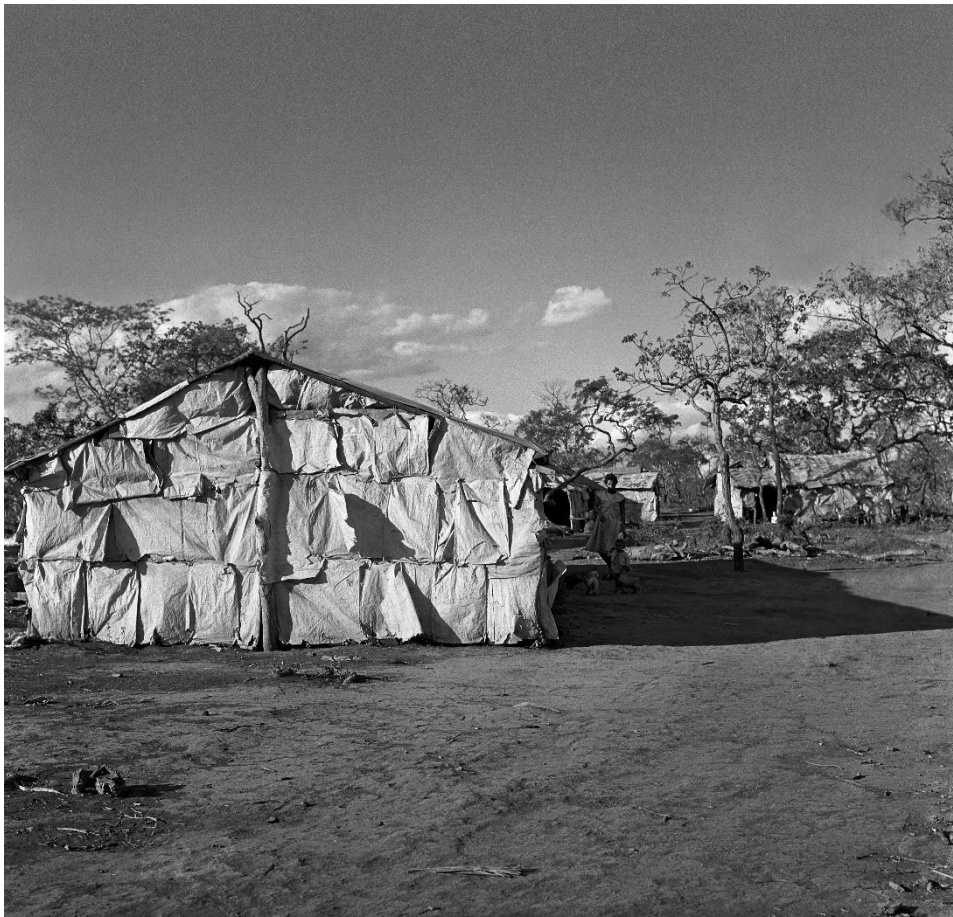
Figura 28 - Exemplo de moradia feita a partir de sacos de materiais usados na construção civil, na Vila Amaury. Foto tirada pelo fotógrafo Marcel Gautherot. Detentor dos direitos autorais: Instituto Moreira Salles.
