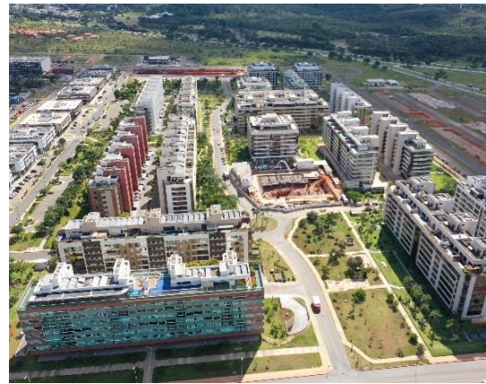
Figura 4 – Vista área da SQNW 111, Brasília – DF. Fonte: Autorial.
