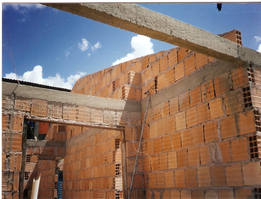
Figura 5.12 – Casa em construção 3. Fonte: (GONZALES, S.F.N.; JUCÁ FILHO, A. SOUZA E SILVA, M.F.; BUSON, M.A., 1998)
