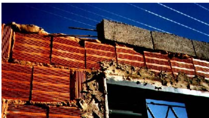
Figura 5.1 – Desperdício de materiais, falta de especificação e de assistência técnica. Fonte: SPOSTO (1999)
