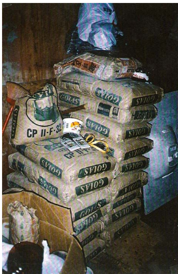
Figura 5.8 – Armazenagem de cimento e aparelhos. Fonte: (GONZALES, S.F.N.; JUCÁ FILHO, A. SOUZA E SILVA, M.F.; BUSON, M.A., 1998)
