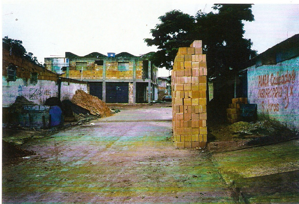
Figura 5.5 – Material armazenado na via pública: blocos cerâmicos. Fonte: (GONZALES, S.F.N.; JUCÁ FILHO, A. SOUZA E SILVA, M.F.; BUSON, M.A., 1998)
