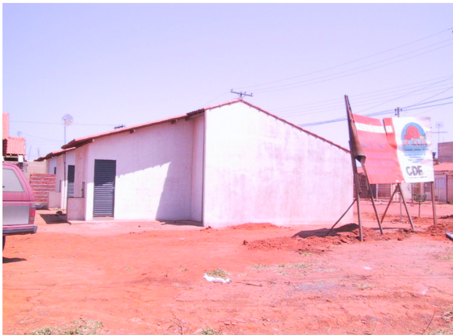
Figura 5.14 – Casas prontas e placa de obra do GDF. Fonte: (VIDAL, 2003)
