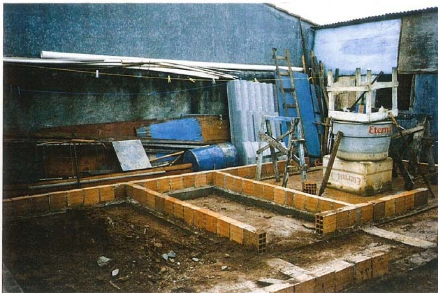
Figura 5.7 – Armazenagem de tubulação, telhas e caixa d'água. Fonte: (GONZALES, S.F.N.; JUCÁ FILHO, A. SOUZA E SILVA, M.F.; BUSON, M.A., 1998)
