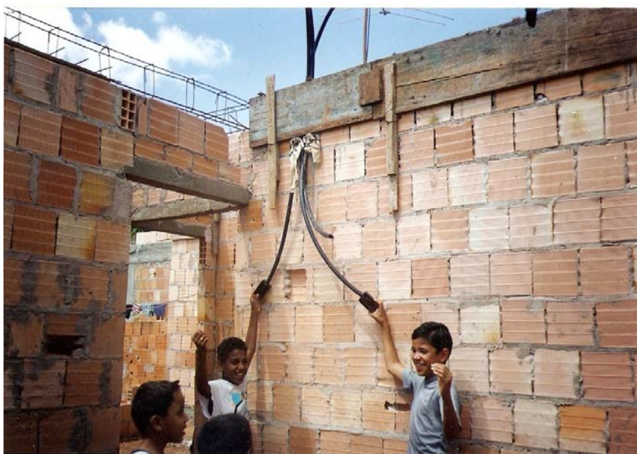
Figura 5.10 – Casa em construção 1. Fonte: (GONZALES, S.F.N.; JUCÁ FILHO, A. SOUZA E SILVA, M.F.; BUSON, M.A., 1998)
