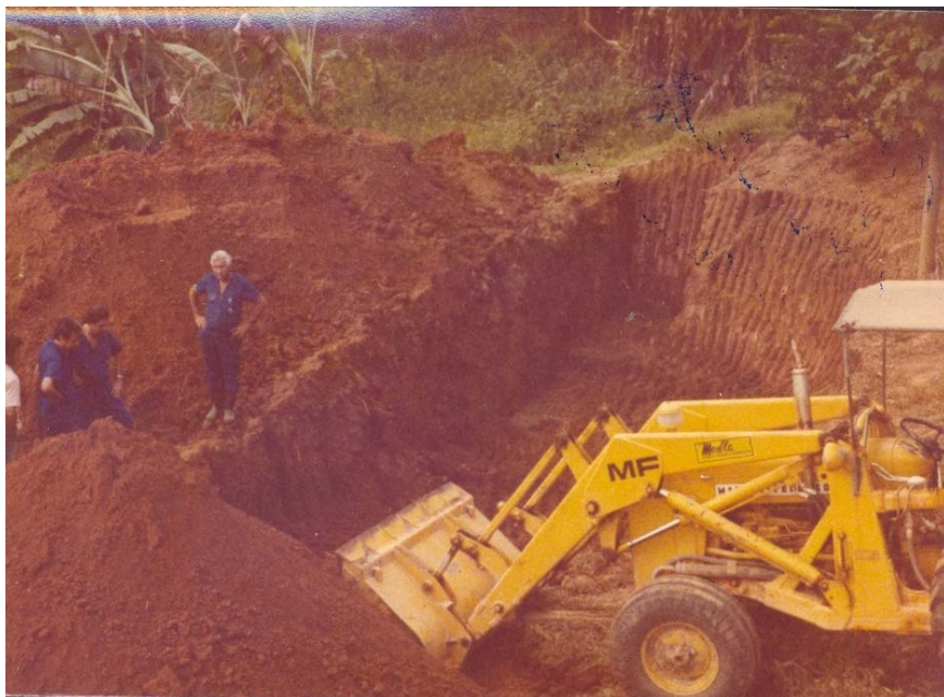
FIGURA 23 Abertura de valas, obedecendo a critérios técnicos, a fim de evitar a contaminação do lençol freático.
