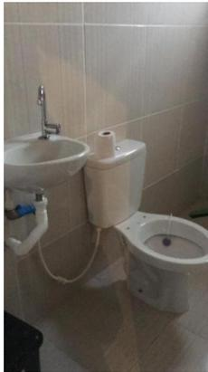
Figura 25: Residência Guiomar: banheiro após a intervenção – substituição das louças, instalação de revestimento cerâmico nas paredes e piso.
