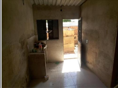
Figura 33: Residência Zildo: cozinha após a intervenção – aplicação de reboco nas paredes; assentamento de novo piso cerâmico; instalação de nova bancada.
