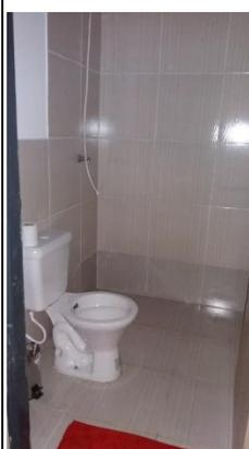
Figura 17: Residência Ana Claudia: Banheiro após a intervenção – substituição das louças, instalação de revestimento cerâmico nas paredes e piso.
