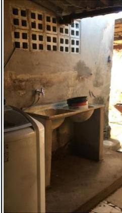
Figura 27: Residência Guiomar: área de serviço após a intervenção – regularização do piso; abertura com cobogós para nova cozinha; instalação de tanque de lavar roupas.
