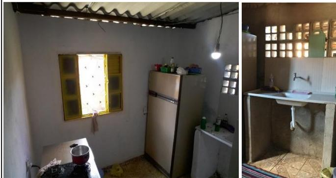
Figura 29: Residência Guiomar: cozinha após a intervenção – reforma da cozinha com instalação de nova pia e bancada; pintura das paredes; abertura com cobogós e instalação de revestimento cerâmico.
