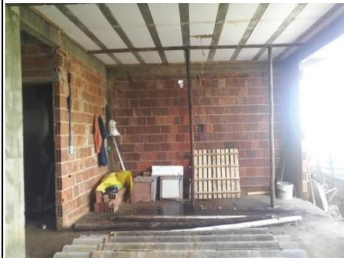
Figura 23: Residência Elisângela: sala após a intervenção – construção de laje pré-moldada em concreto; alvenaria de vedação.
