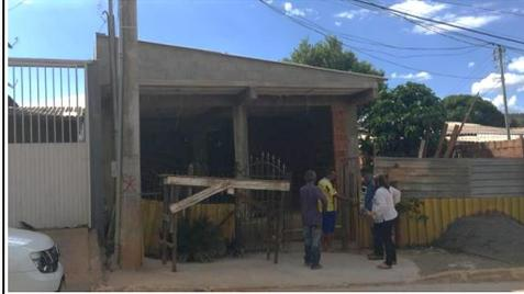
Figura 21: Residência Elisângela: Fachada frontal após a intervenção – construção de laje pré-moldada em concreto; alvenaria de vedação; instalação de telhado.
