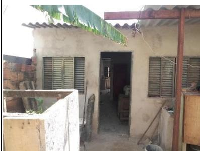
Figura 31: Residência Zildo: fachada frontal após a intervenção – aplicação de reboco.
