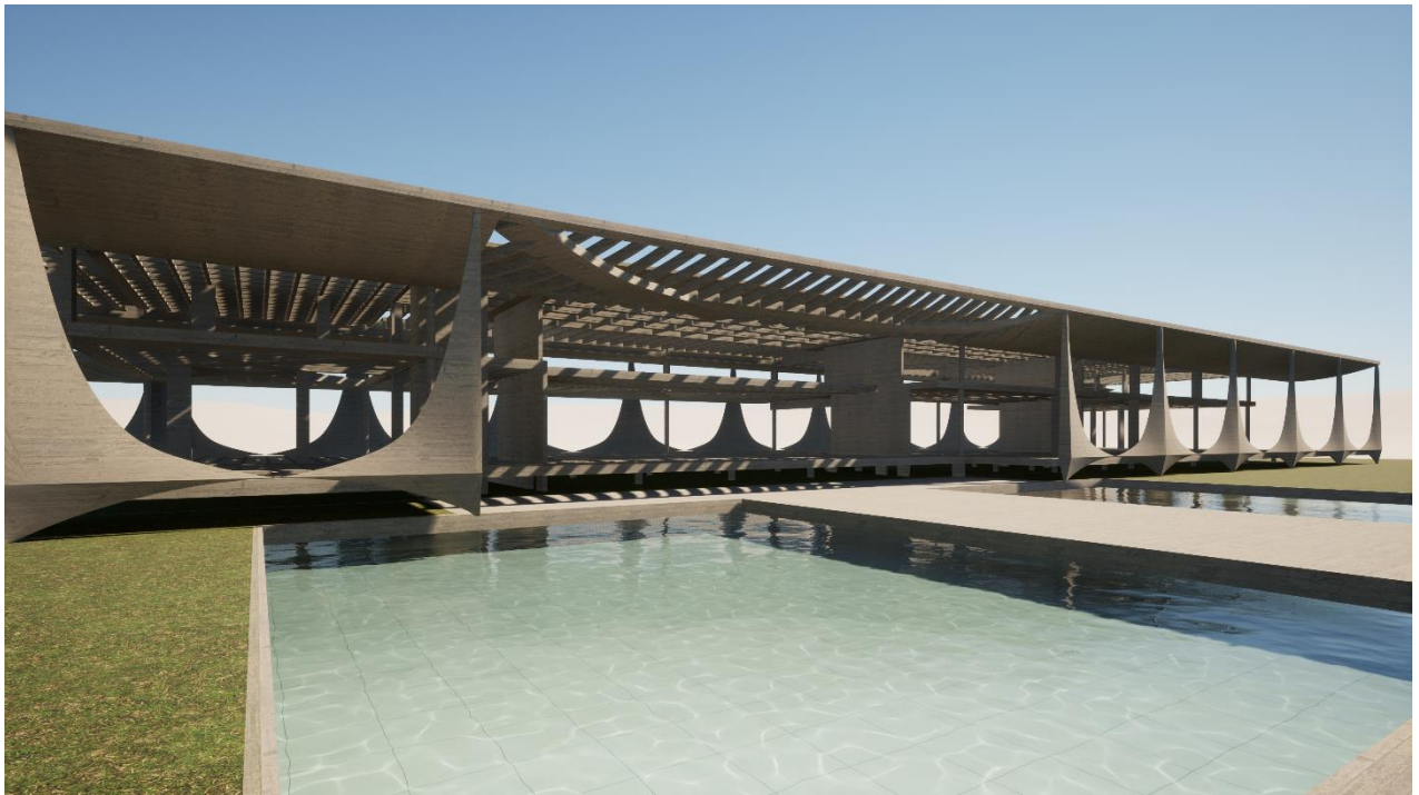
Figura 88. Modelagem tridimensional do sistema estrutural do Palácio da Alvorada. Fonte: Autoral.
