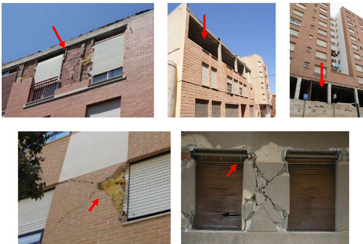
Figura 34. Mecanismo de falha fora do plano e no plano em painéis externos de alvenaria. . Fonte: Romão et al, 2011.
