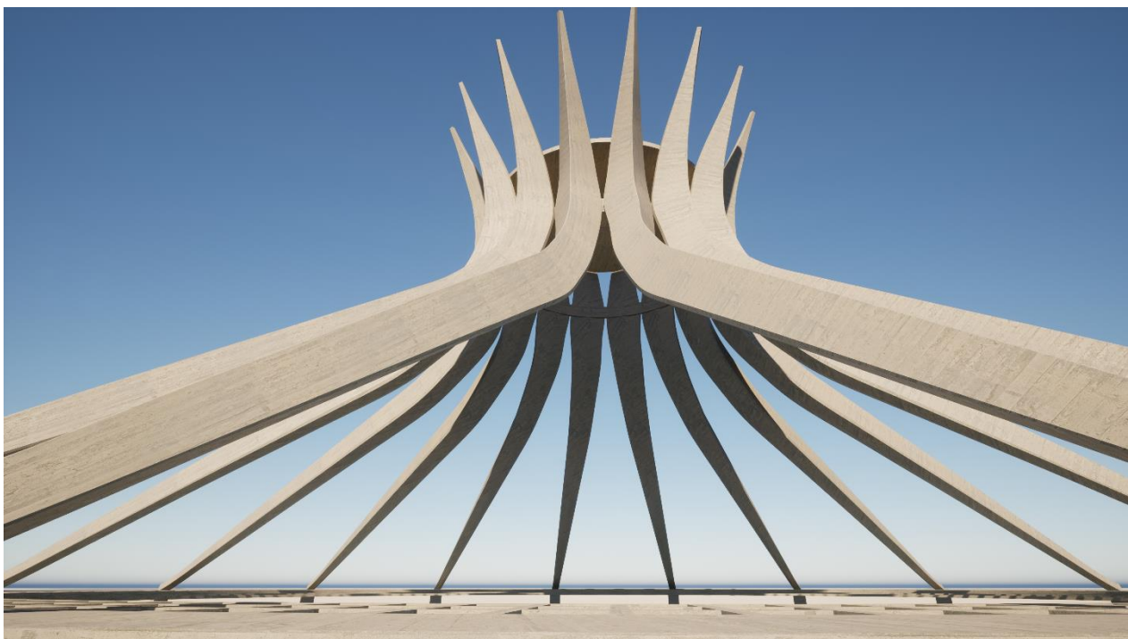
Figura 167. Detalhe dos montantes (Pilares). Fonte: Autoral.
