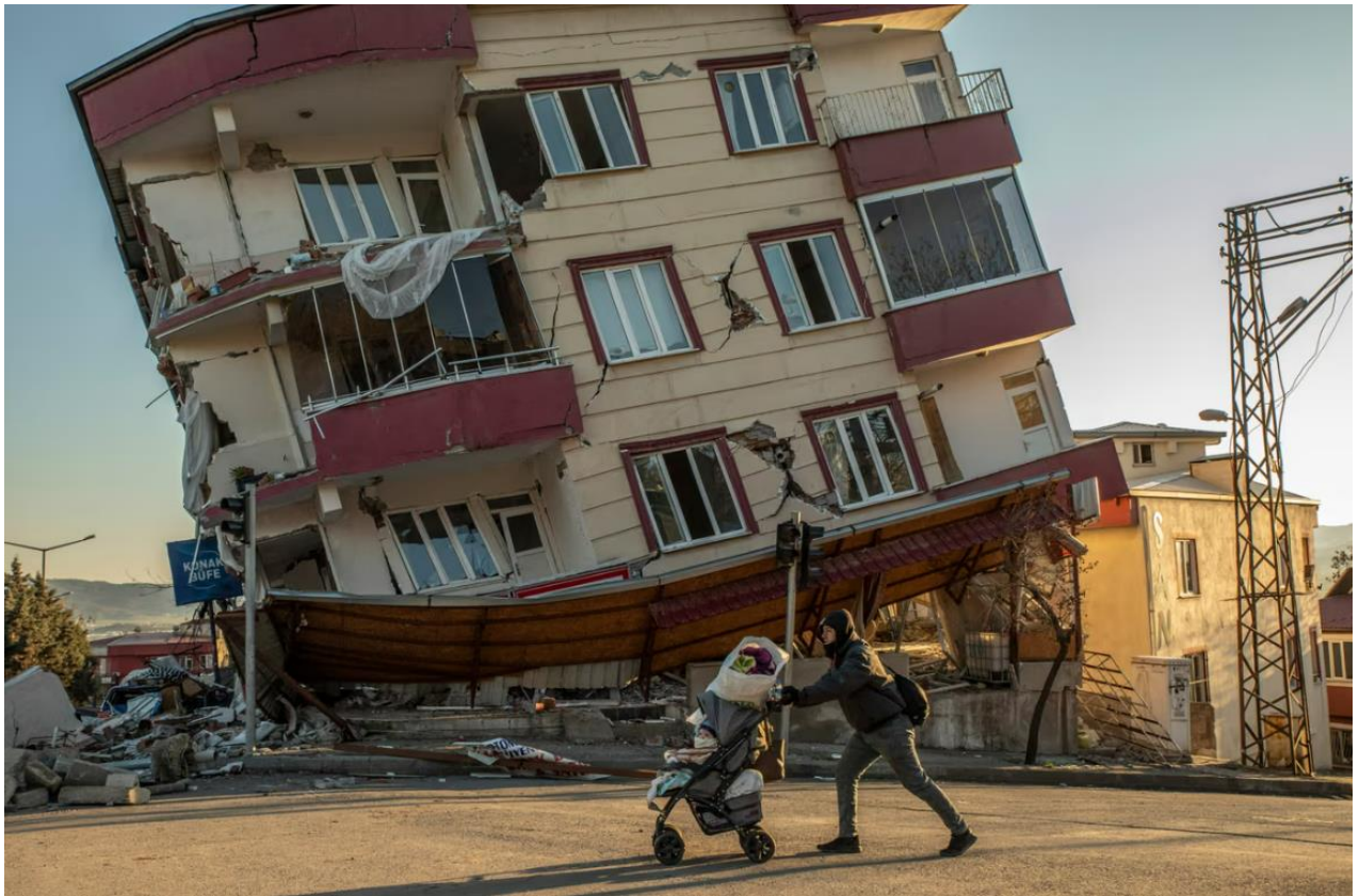
Figura 28. Caso de Soft Storey no terremoto da Turquia (2023). Fonte The Guardian.
