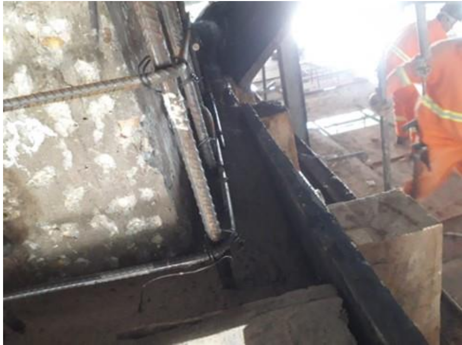
Figura 106 – Detalhe da execução da armadura de reforço dos pilares
