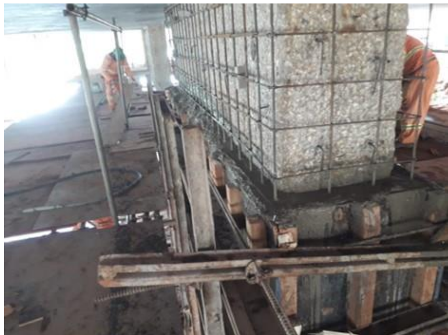
Figura 107 – Detalhe da concretagem da camada de recobrimento de reforço dos pilares
