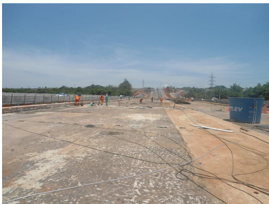
Figura 91 – Retirada da pavimentação existente e regularização do tabuleiro
