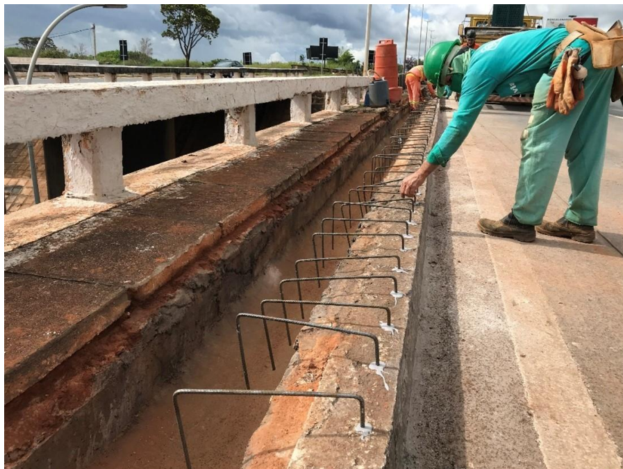
Figura 90 – Fiação de armadura das Barreiras de concreto com epóxi
