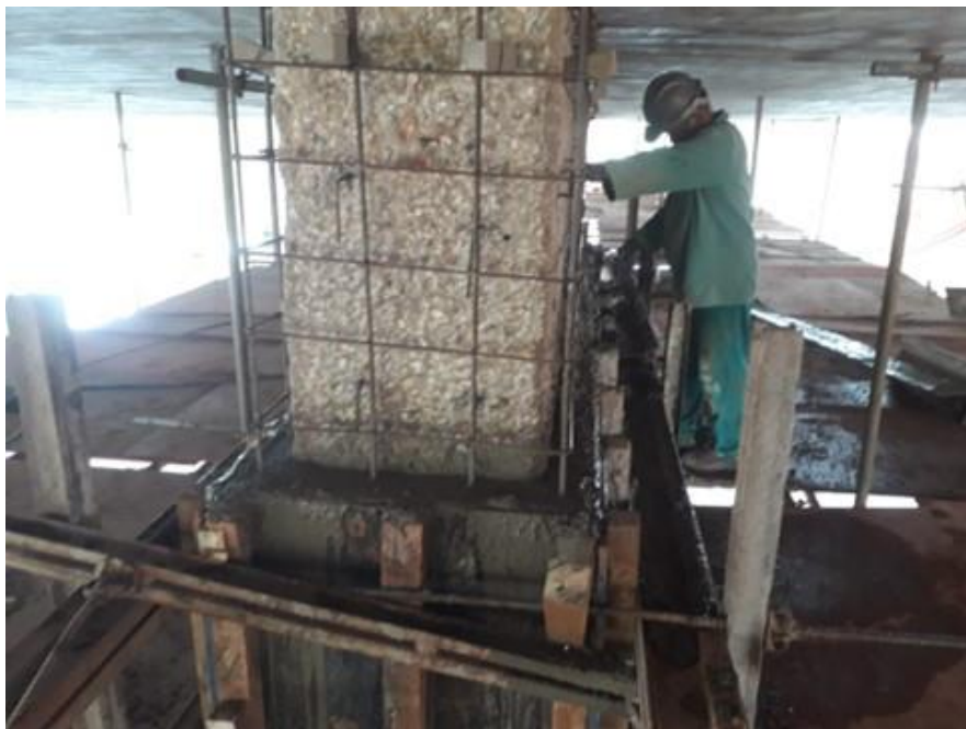
Figura 108 – Detalhe da concretagem da camada de recobrimento
