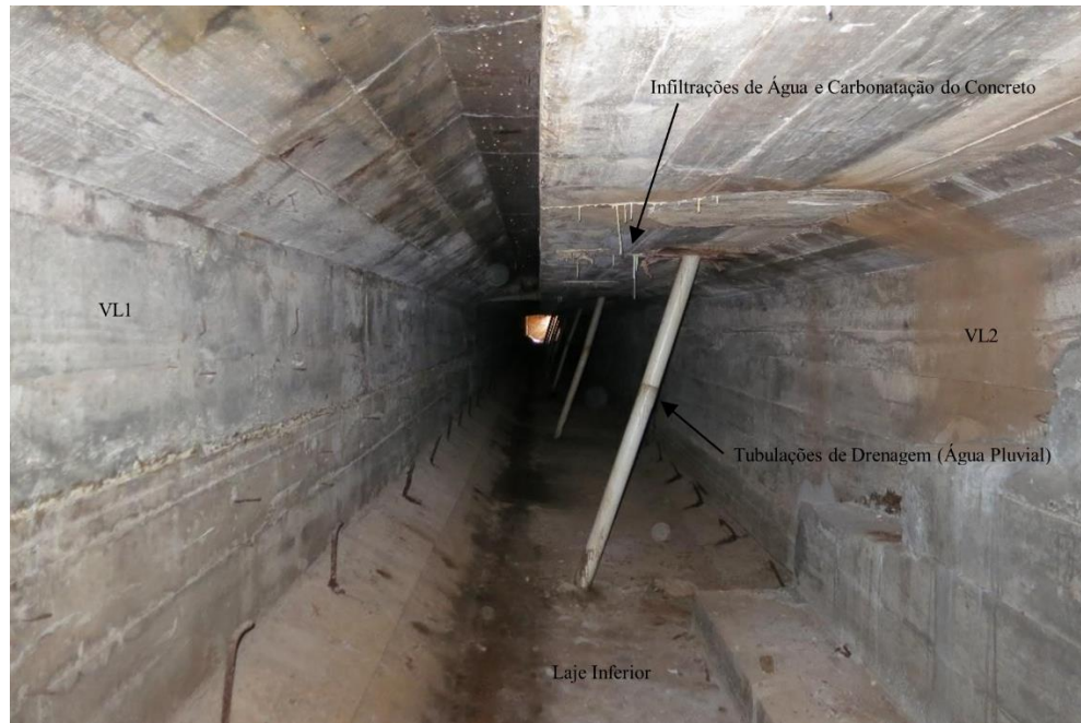
Figura 56 – Infiltrações de Água e Carbonatação do Concreto. Tubulações de Drenagem Desativadas da Galeria Celular entre VL1 e VL2
