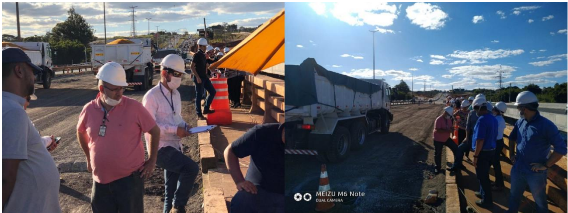
Figura 113 – Equipe de técnicos Novacap e DER/DF no teste de carga da Ponte Braghetto em 2019
