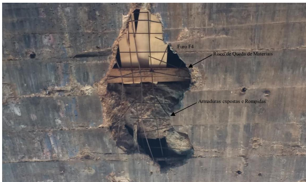
Figura 50 – Furo na Laje Inferior do Tabuleiro (F3)
