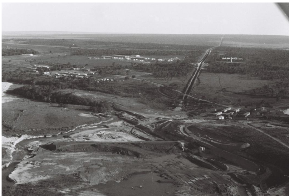
Figura 11 – Lago Paranoá na época da execução da fundação da Ponte Braghetto
