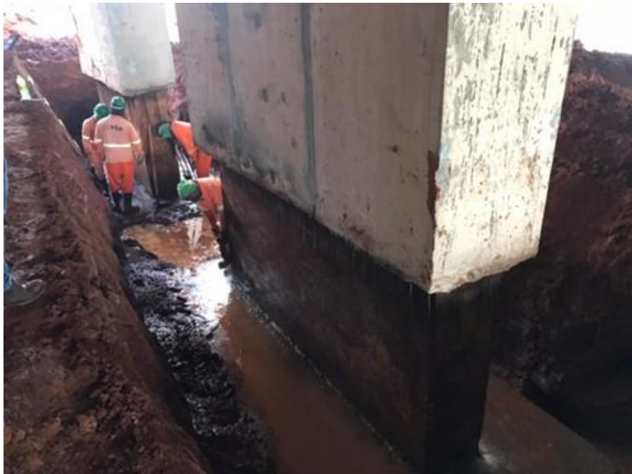
Figura 103 – Reforço nos pilares etapa 1
