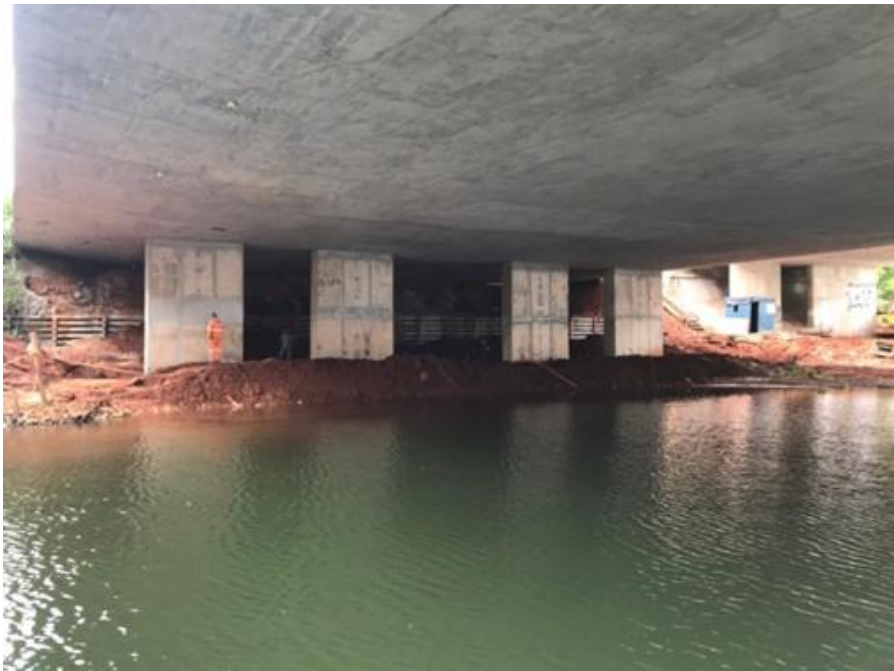
Figura 102 – restauração da laje inferior
