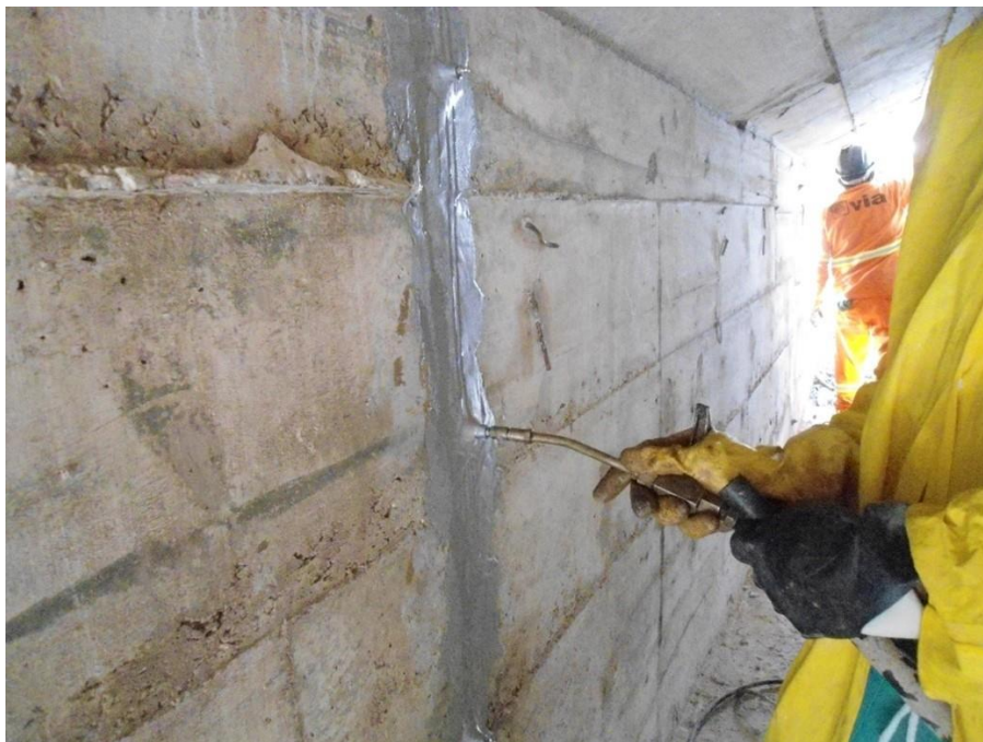
Figura 100 – Tratamento de trincas com resina epóxi
