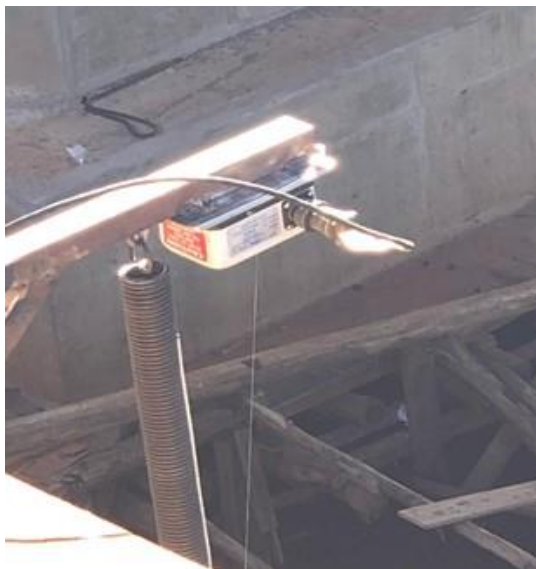
Figura 120 – Sensores instalados no ensaio
