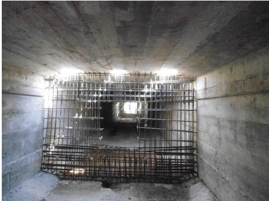
Figura 85 – Armadura novas vigas de apoio a protensão
