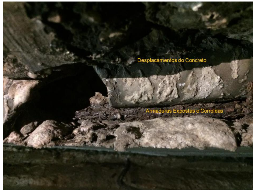
Figura 65 – Regiões com Baixo Cobrimento e Armaduras Expostas
