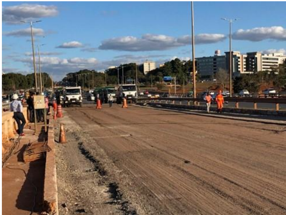
Figura 116 – Caminhões caçambas carregados com 30 toneladas
