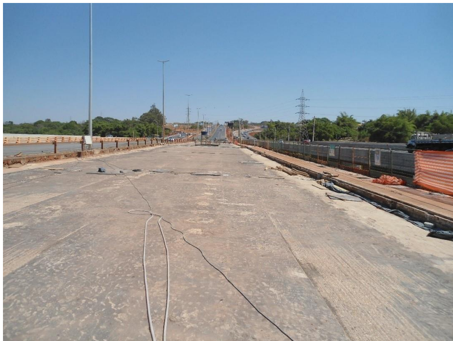
Figura 92 – Retirada da pavimentação existente e regularização do tabuleiro
