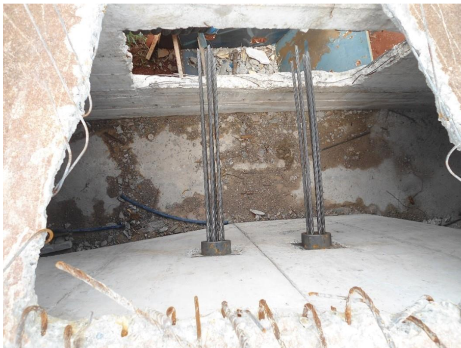
Figura 101 – Cabos de protensão novos
