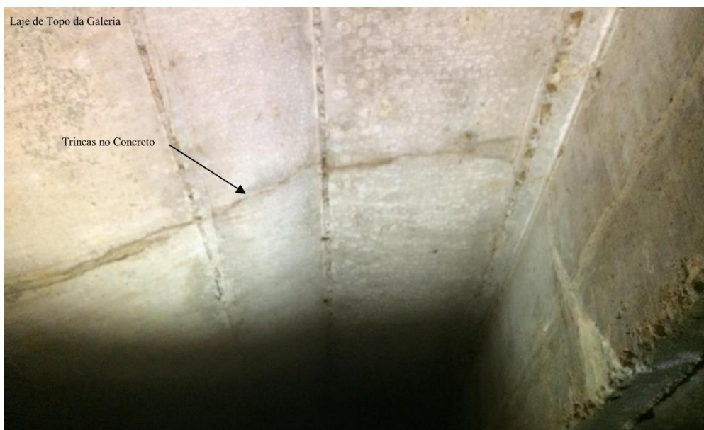
Figura 71 – Trincas na Face Interna das Galerias Celulares
