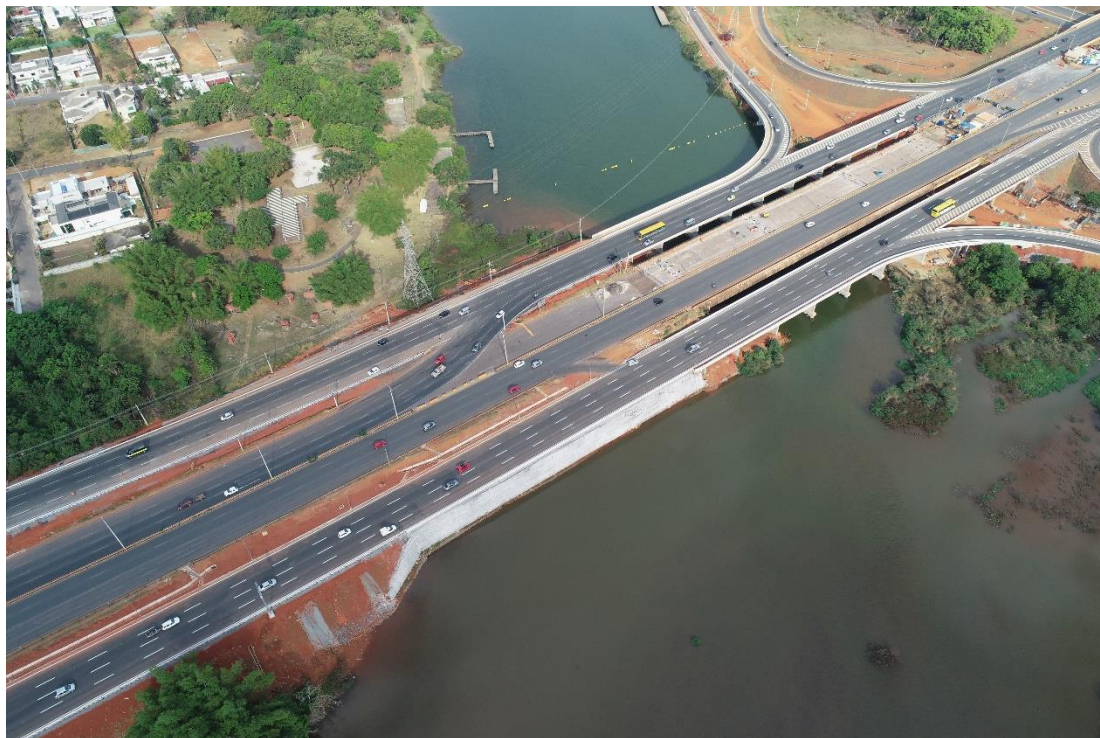
Figura 3 – Vista aérea da ponte do Braghetto depois da reabilitação
