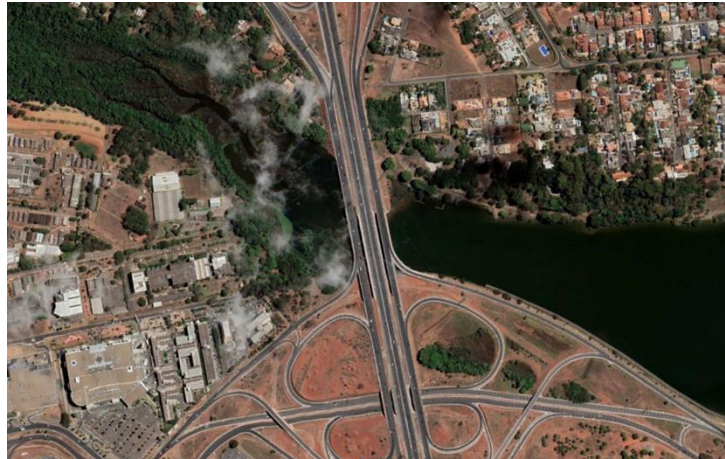
Figura 20 – Ponte do Braghetto e duas novas pontes paralelas
