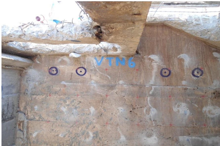
Figura 86 – Tratamento de trincas nas vigas existentes e perfurações das passagens dos cabos de protensão
