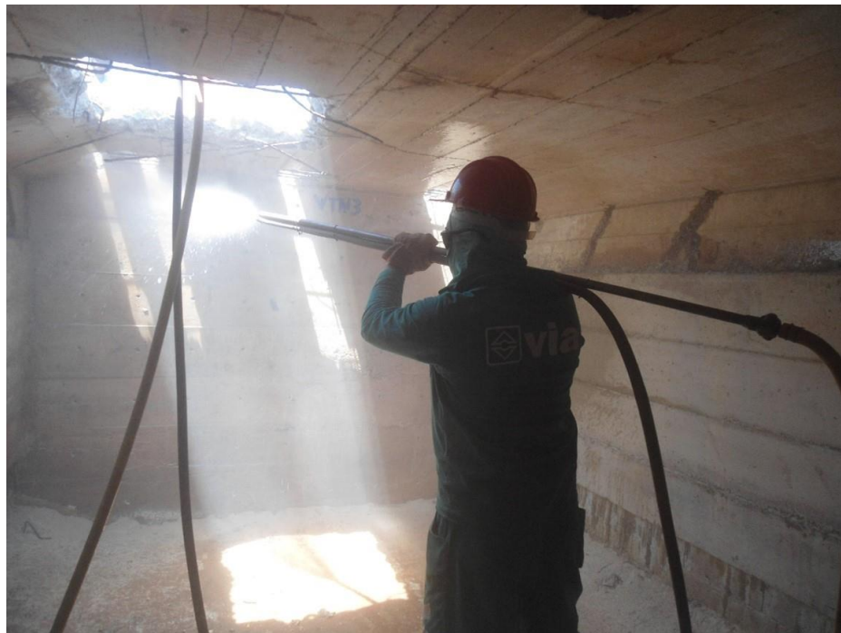
Figura 87 – Abertura da visitas e tratamento do concreto com jateamento de água
