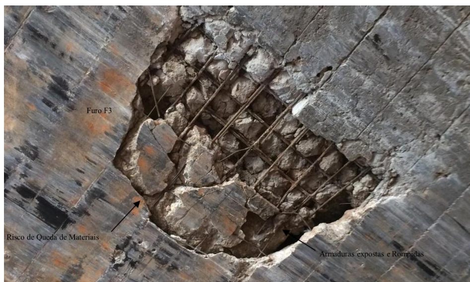
Figura 48 – Furo na Laje Inferior do Tabuleiro (F1)
