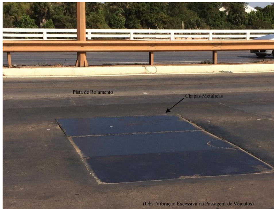
Figura 54 – Laje Superior do Tabuleiro – Eixos E3 a E4 Chapa Metálica p/ Vedar Furo Existente na Laje
