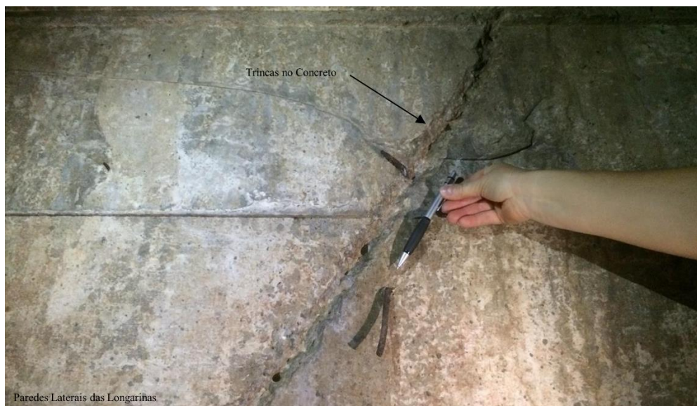
Figura 71 – Trincas na Face Interna das Galerias Celulares
