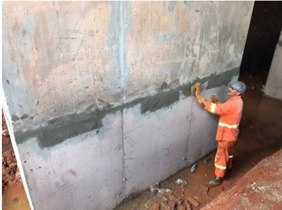
Figura 104 – Reforço nos pilares etapa 2
