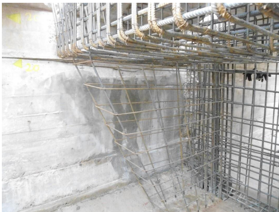
Figura 93 – Armadura das novas vigas
