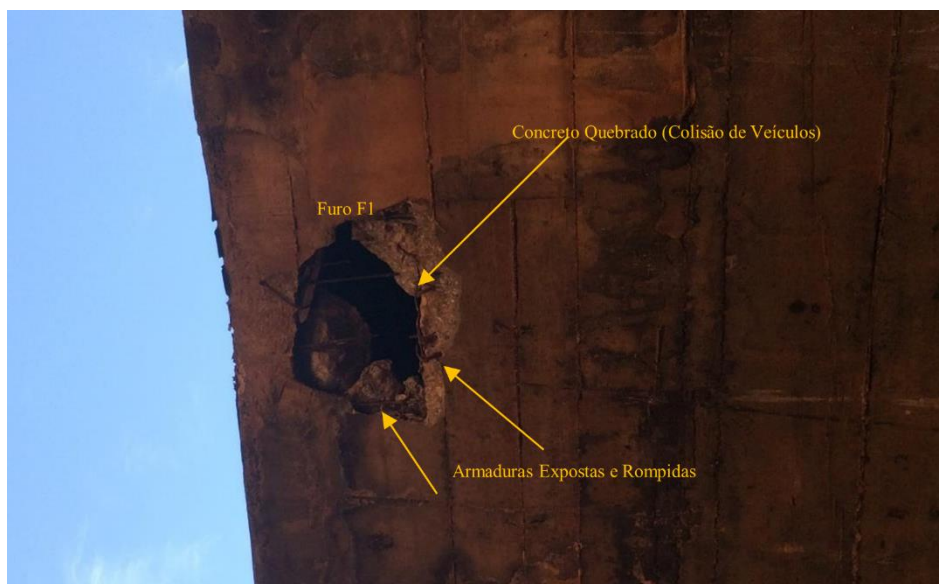
Figura 46 – Laje Inferior do Tabuleiro Eixos E1 a E2 Furos Existentes (F1 a F5s ) Furo – Parcialmente Reparados (RE1 a RE6)
