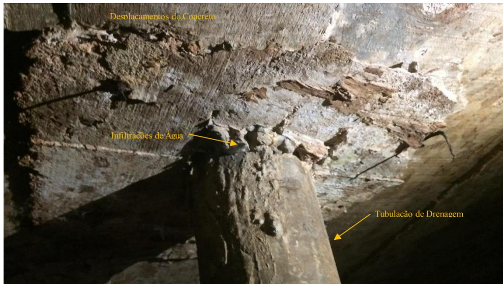
Figura 56 – Infiltrações de Água e Carbonatação do Concreto. Tubulações de Drenagem Desativadas da Galeria Celular entre VL1 e VL2
