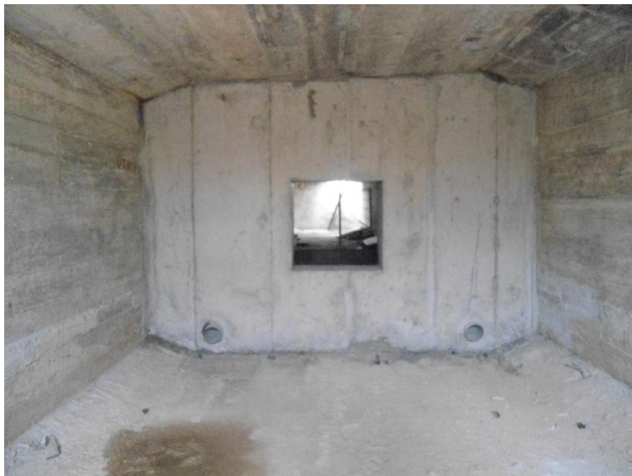
Figura 94 – Execução vigas transversinas internas
