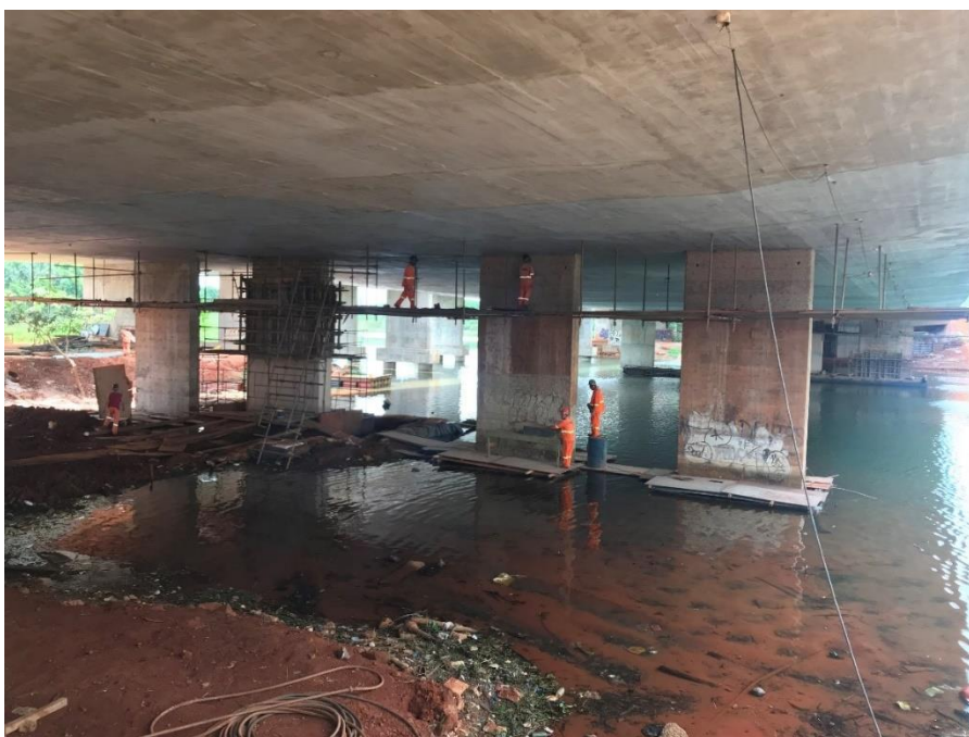
Figura 109 – Execução de tratamento na laje inferior
