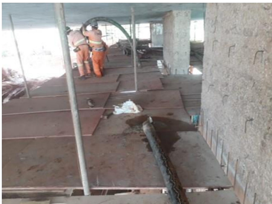
Figura 111 – Concretagem reforço dos pilares
