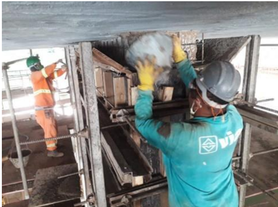
Figura 105 – Concretagem reforço nos pilares
