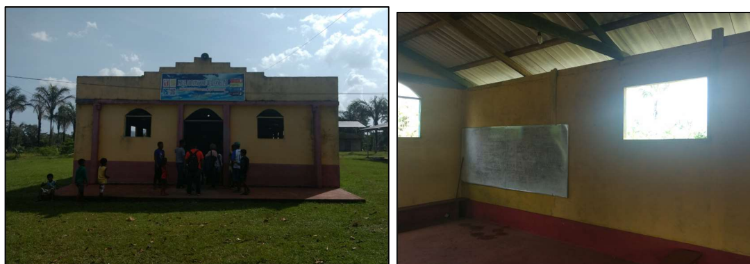
Figura 55 – Sala de aula 3 - Salão de Igreja usada durante o dia como sala de aula
