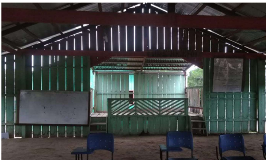
Figura 57 – Sala de aula na comunidade de Amiú
