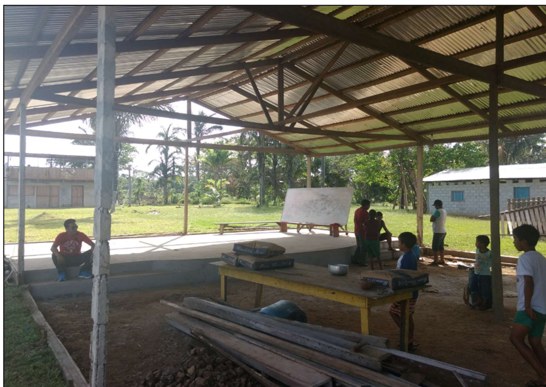
Figura 56 – Sala de aula 4 – “parcialmente” construída
