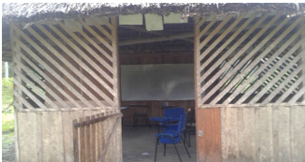
Figura 61 – Comunidade Auxiliadora – sala de aula
