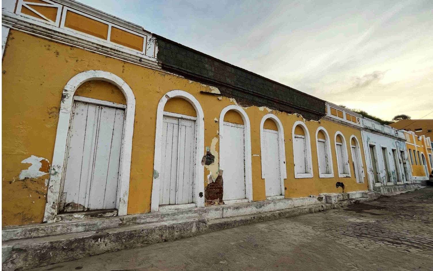
Figura 82– Intervenção construtiva feita em concreto em um dos bens de Piranhas Sede. Fonte: fotografia autoral, 2023.
