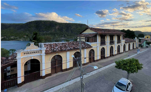
Figura 40 – Prédio da estação ferroviária, museu e monumento de referência no setor. Fonte: fotografia autoral, 2023.
