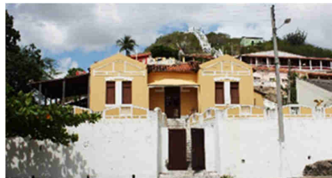
Figura 44 – Antiga residência do chefe da estação ferroviária. Fonte: IPHAN, 2014.
