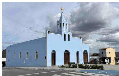
Figura 64 – Igreja localizada na praça de Piau. Fonte: fotografia autoral, 2023.
