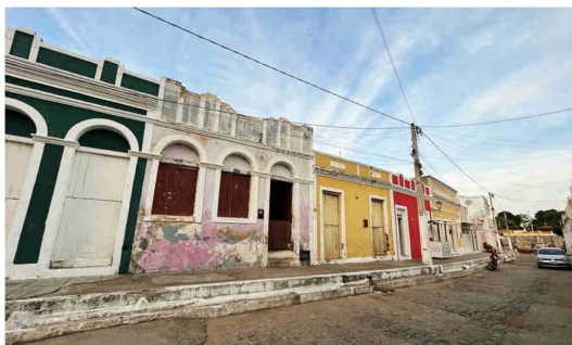
Figura 56 – Edificações em diferentes estados de integridade. Fonte: fotografia autoral, 2023.
