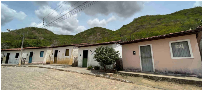
Figura 28 – Residências do tipo porta e janela. Fonte: fotografia autoral, 2023.
