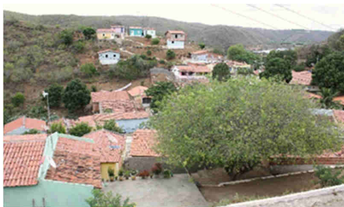
Figura 49 – Ocupação das encostas no Alto do Cabrobó, Piranhas Sede. Fonte: IPHAN, 2014.
