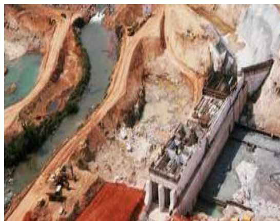
Figura 4C - Término do desvio e curso normal pronto para ser bloqueado.
