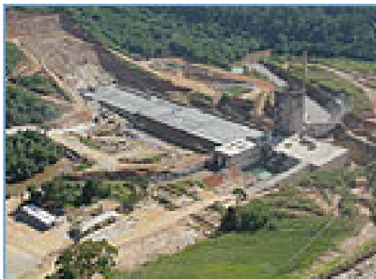
Figura 8C - Vista geral de jusante (maio/2004). Fonte: SANEAGO (2005).
