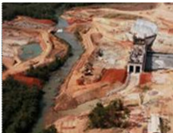
Figura 3C - Ribeirão João Leite em seu leito natural e a construção do desvio.
