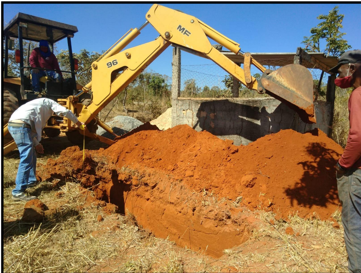
Figura 2 - Fotografia tirada durante medição de profundidade da SEP01. A esquerda observa-se a retroescavadeira utilizada para escavação das SEP's.
