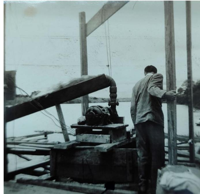
Figura 95 - Instalação da bomba de recalque da Estação Elevatória. Data e autor não identificados.
