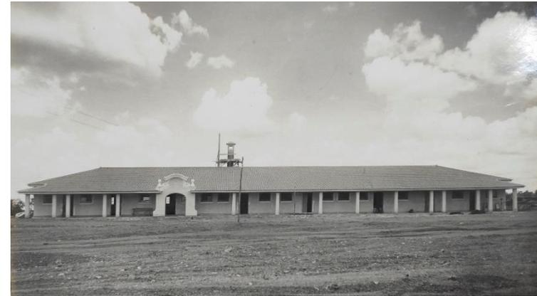
Figura 232 - Fachada de um dos pavilhões de alojamento com frontão deslocado lateralmente. Fotografia tirada em janeiro de 1941, autor não identificado.
