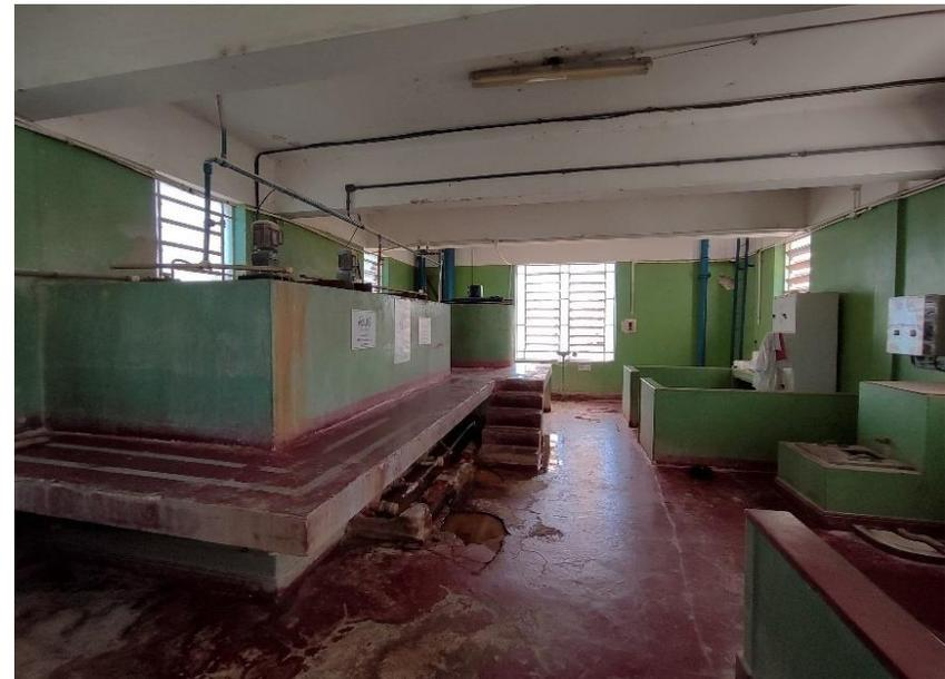
Figura 97 - Vista interior do pavimento superior da Estação de Tratamento de Água onde é possível notar algumas rachaduras e acúmulo de água no piso.
