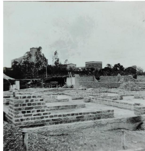
Figura 189 - Início da construção do Centro de Saúde, no final da década de 1930, onde é possível verificar o sistema de alvenaria estrutural empregado no edifício. Autor não identificado.
