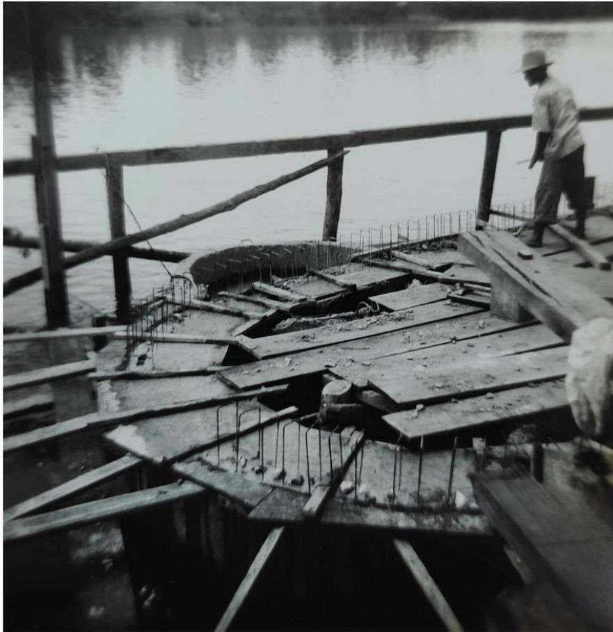
Figura 94 - Estação Elevatória de Água durante a construção. Data e autor não identificados.
