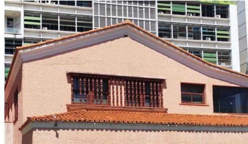
Figura 40 - Detalhe da grade balaustrada em madeira na janela do andar superior.
