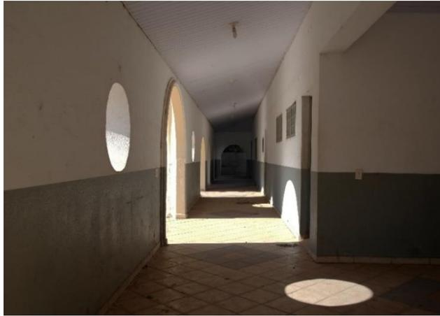
Figura 198 - Varanda da edificação com aberturas tipo óculo e acessos em arcos.
