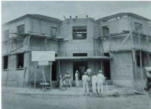
Figura 191 - Centro de Saúde na fase de execução da cobertura. Fotografia da década de 1930, autor não identificado.
