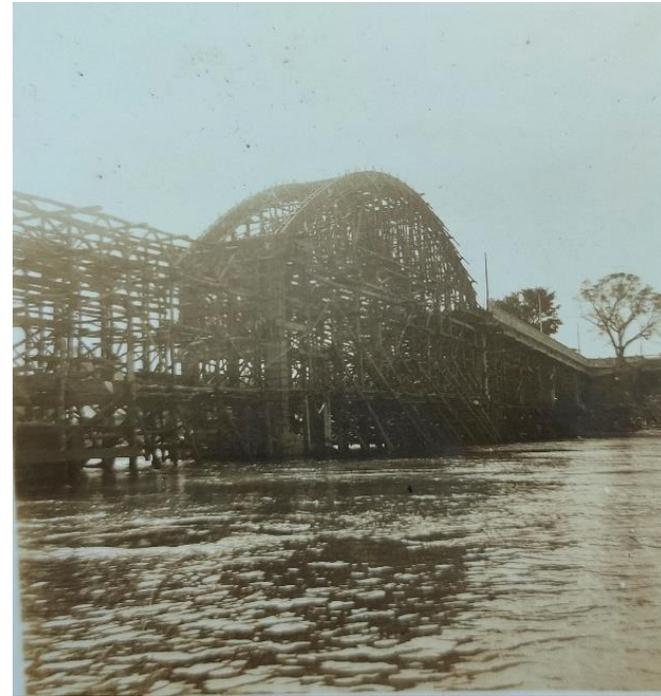
Figura 156 - Estrutura para concretagem da ponte. Autor e data não identificados.
