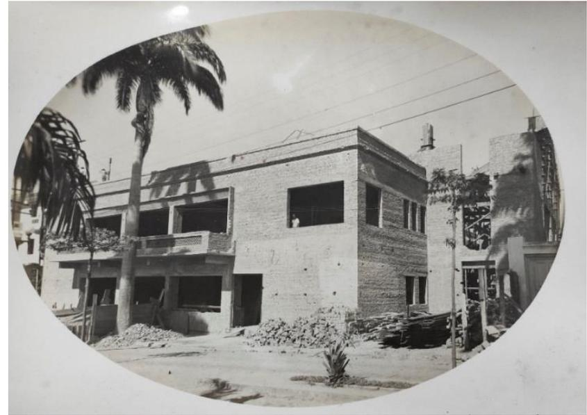
Figura 73 - Cine Teatro durante a obra onde é possível ver o sistema estrutural de alvenaria de tijolos que foi adotado. Data e autoria da foto não identificadas.
