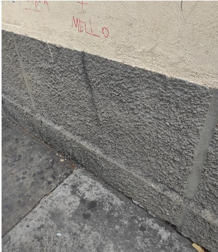
Figura 139 - Chapisco da parede correspondente a área da Praça de Esportes/Estádio desenhado de forma a remeter as placas de revestimento.
