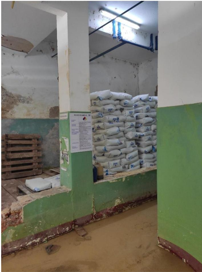
Figura 98 - Alas lateral esquerda (em relação a fachada principal) no térreo com bastante água acumulada e vários danos na edificação, sobretudo causados por infiltração.
