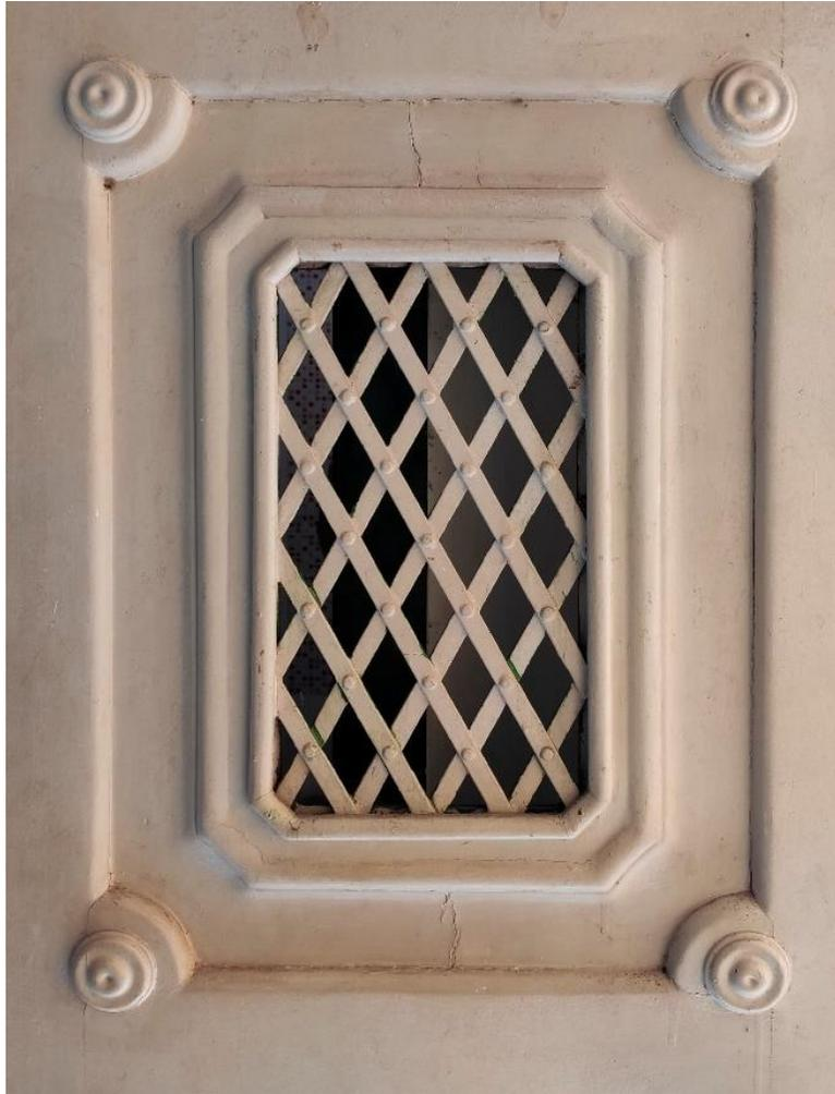
Figura 202 - Detalhe da parte vazada em aço, da porta de entrada.
