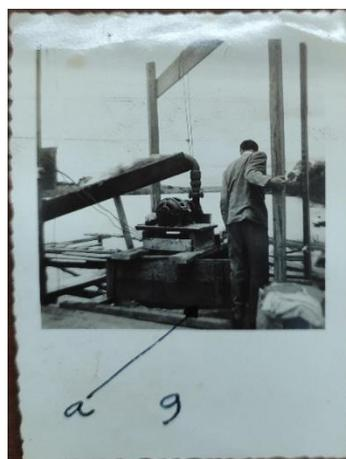
Instalação do maquinário da Estação Elevatória, fotografia da década de 1940, autor não identificado.
