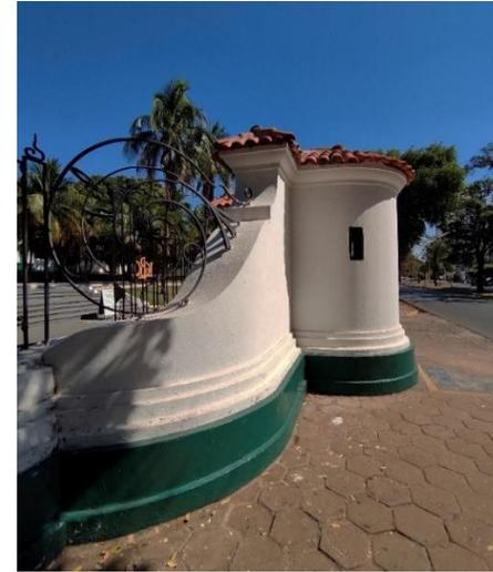
Figura 233 - Detalhe do contraforte lateral às guaritas cilíndricas.
