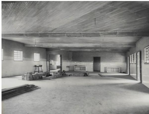
Figura 236 - Interior de pavilhão não identificado do 16º BC. É possível identificar o emprego do acabamento do forro em madeira.
