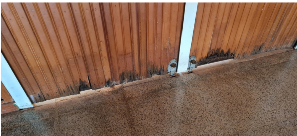
Figura 74- Sistema de vedação - módulo histórico - Imóvel educacional.
