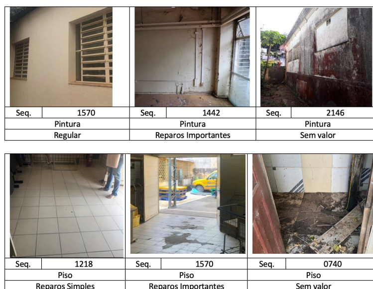
Figura 57 - Fichas de estado de conservação por sistema. Fonte: Dados fornecidos pelos Correios.
