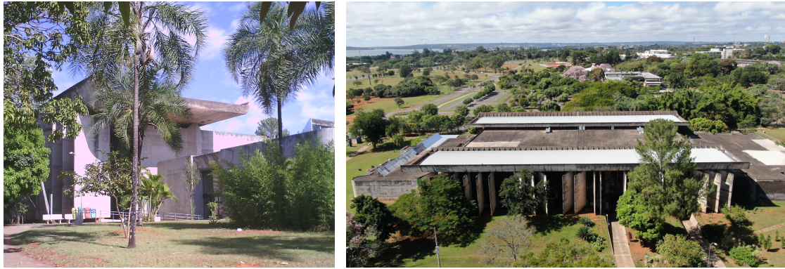
Figura 122- Fachada Leste e Norte da BCE.
