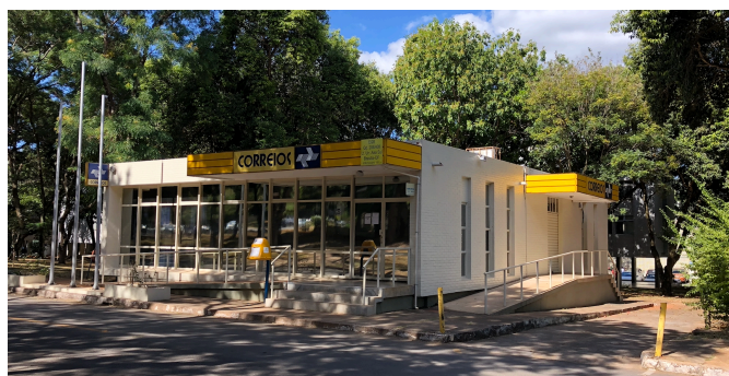
Figura 76 - Amostra 1 - Fachada e sala administrativa - imóvel comercial.
