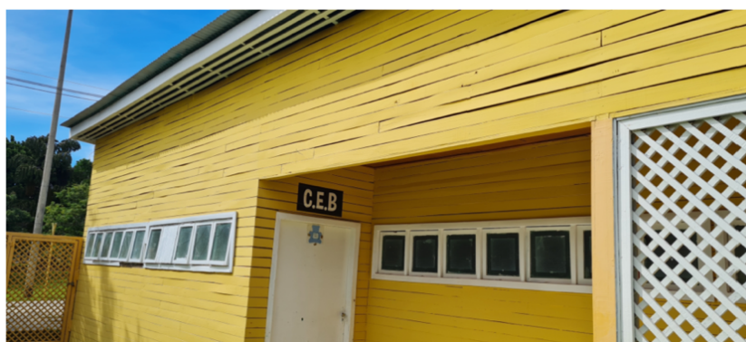
Figura 71- Módulo Histórico, estrutura de madeira - Imóvel educacional.
