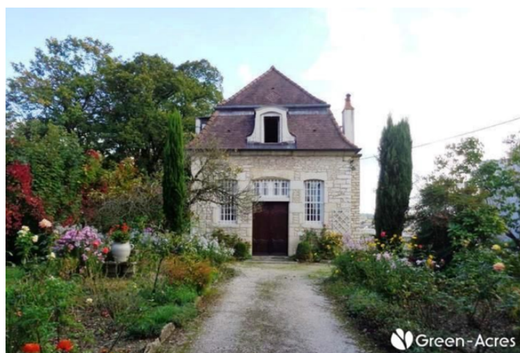
Figura 65 - Imóvel com vida útil avançada, mas que ainda está no mercado imobiliário
