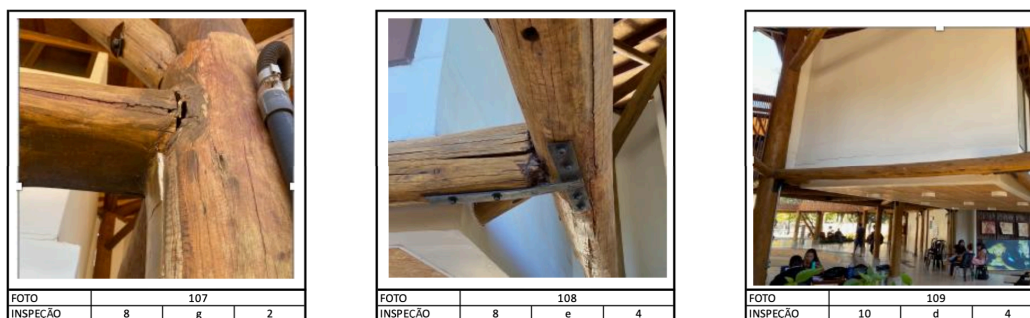
Figura 118 – Movimentação nas ligações metálicas.
