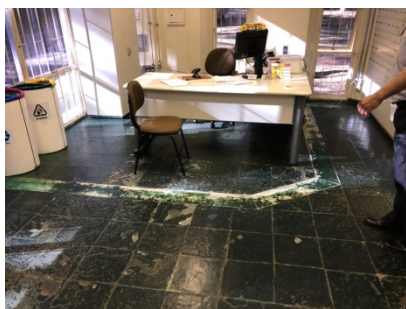
Figura 78 - Desgastes de sistemas decorrentes do uso - imóvel comercial.
