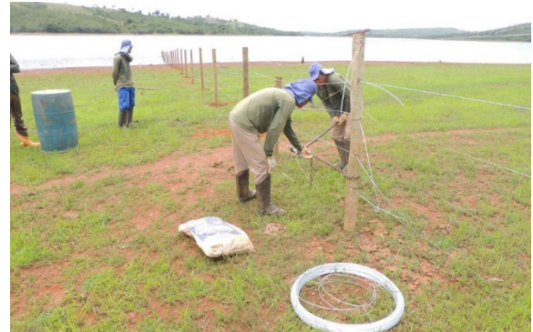
Figura 4.2 - Construção de cerca.
