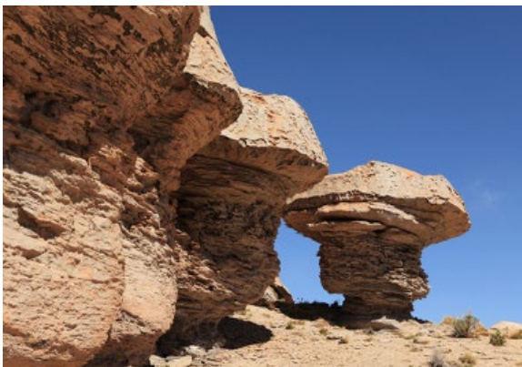
Figura 3.2 - Ilustração de um processo erosivo natural.
