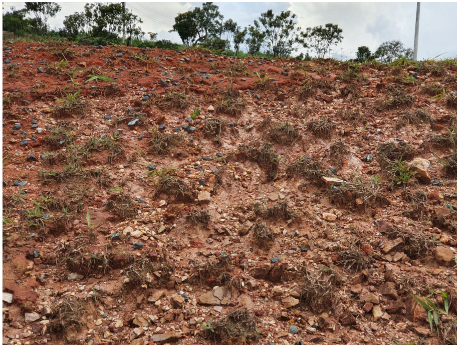
Figura 3.7 - Detalhe de processo erosivo laminar. Fonte: Autor 2023.
