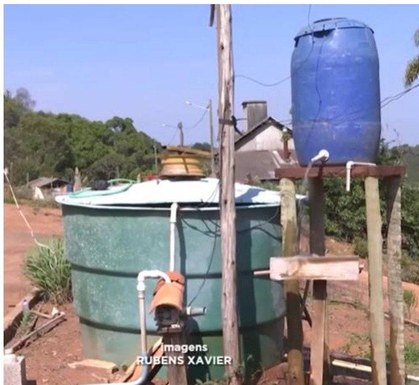
Figura 3.11: Sistema de filtração lenta em residência de produtor rural adaptada de Leal et al. (2013). Direito de imagem: Rubens Xavier.
