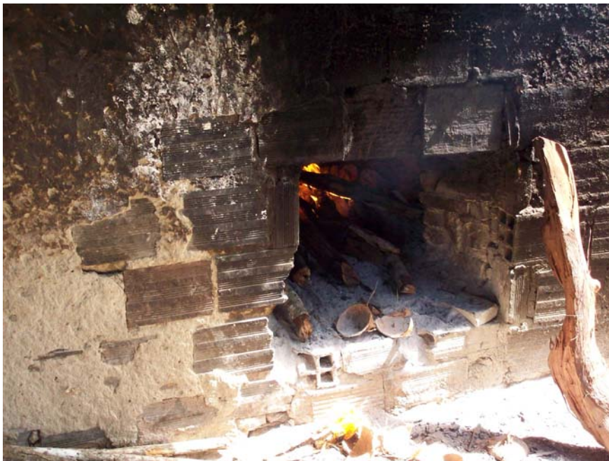
Boca do fogo que alimenta o fogão de lenha (o fogão de lenha, localizado no interior da casa, é mantido acesso através desse compartimento localizado do lado de fora da casa – São Cristóvão/SE)
