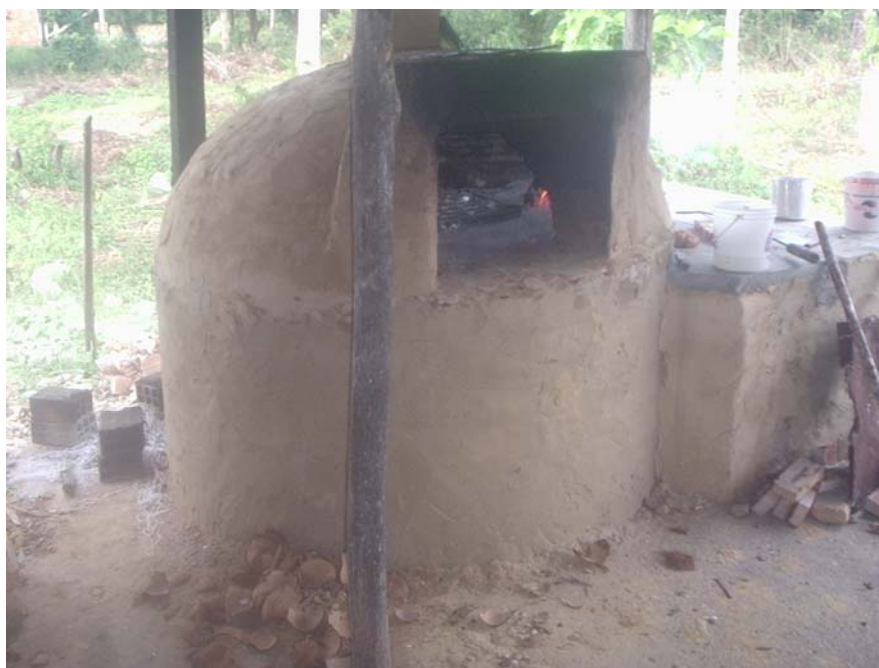
Forno à lenha – feito a base de taipa. Aqui são assados os bolos e as bolachinhas (São Cristóvão/SE)
