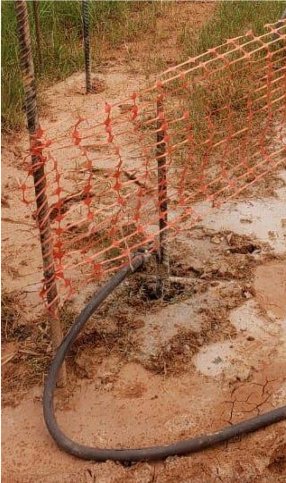
Figura 5.22 – Detalhe da reinjeção dos grampos executados por meio da técnica de reinjeção setorizada
