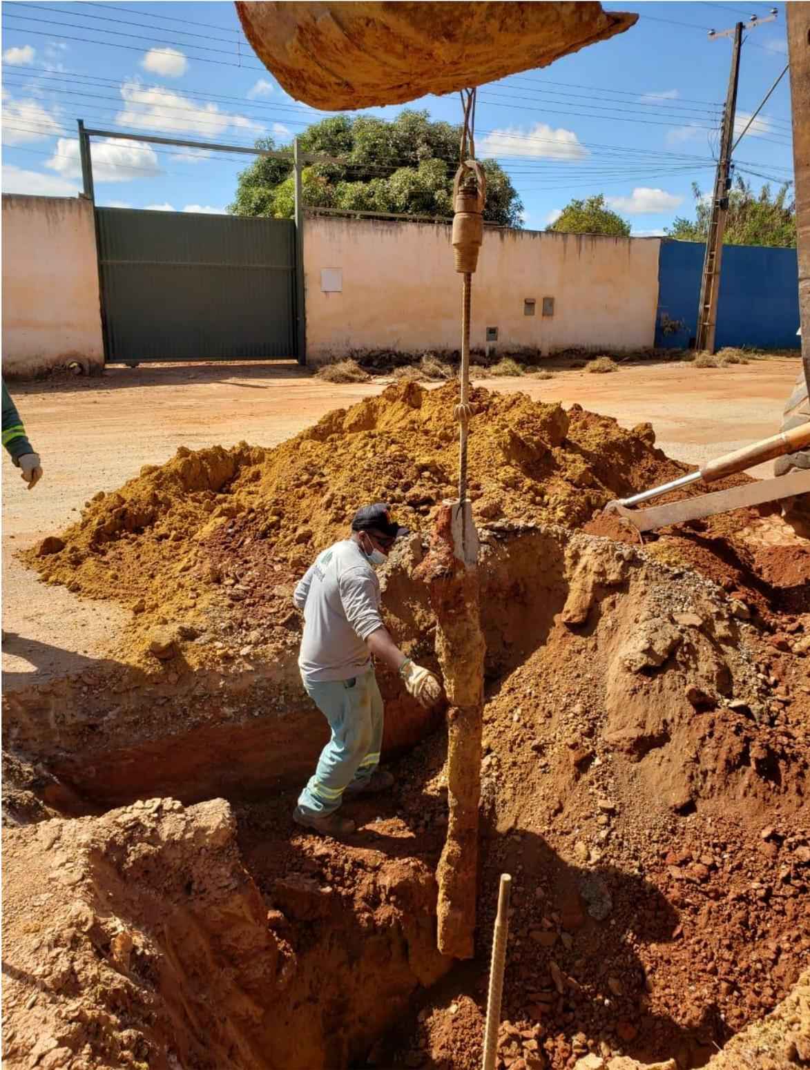
Figura 5.34. Detalhe de içamento mecanizado dos grampos, com auxílio de sinaleiro para içamento controlado.
