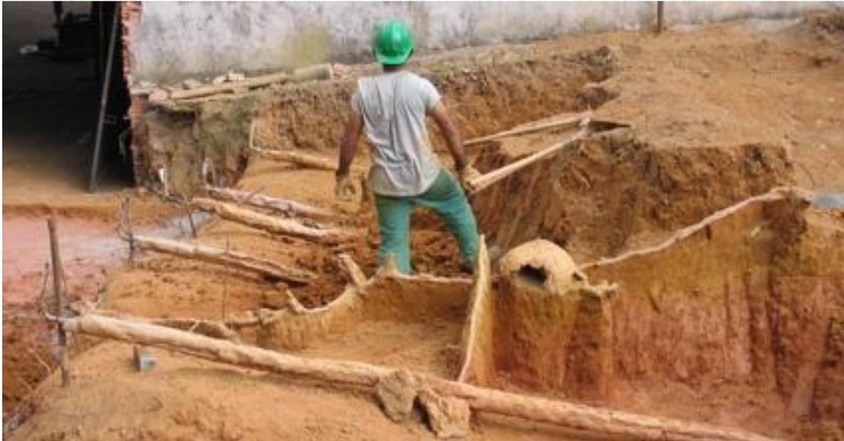
Figura 4.4. Exumação de grampos que foram executados por meio da técnica de reinjeção setorizada, em que a maior rugosidade da superfície pode ser vista. (Souza et al., 2015)
