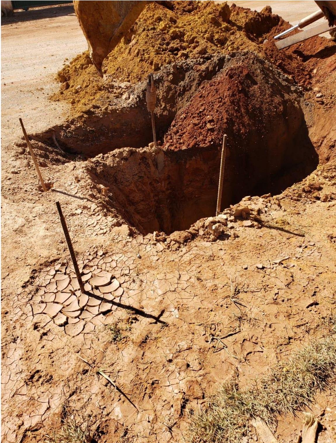
Figura 5.30. Escavação mecanizada dos grampos, detalhe da escavação ao redor dos grampos 3, 4 e 5.
