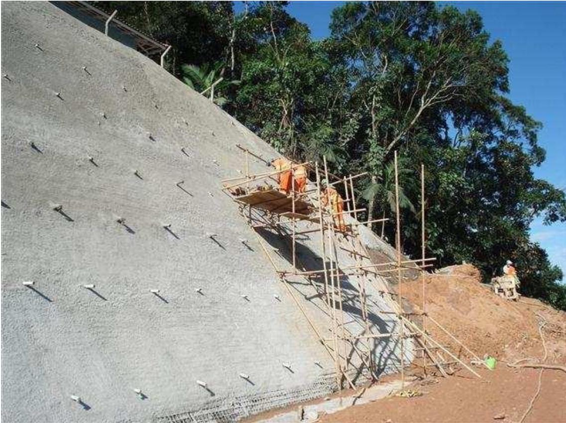
Figura 4.12. Ensaio de arrancamento após execução do paramento. Tal execução foi possível devido a confecção de grampos de sacrifício durante a obra, em que o trecho livre foi envolto por graxa grafitada e por tubos de proteção e a cabeça dos grampos isoladas por meio de tubo PVC e membrana de borracha
