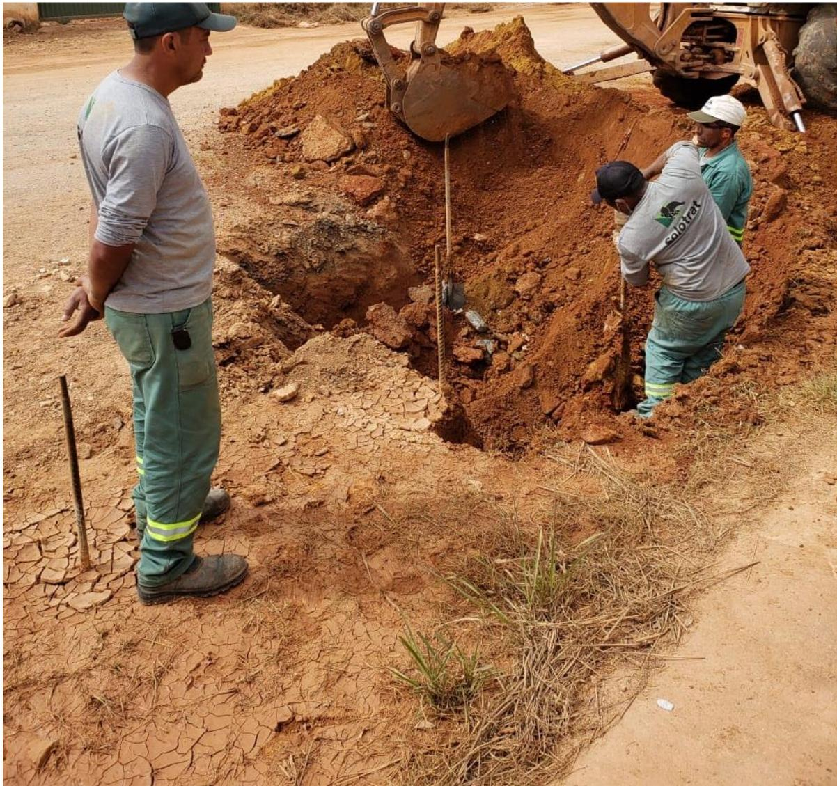
Figura 5.33. Detalhe de escavação manual dos grampos paralelamente à escavação mecanizada.
