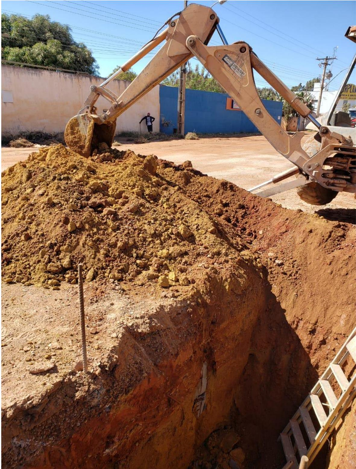
Figura 5.28. Detalhe do início da escavação entre grampos, para posterior retirada de material escavado de forma manual no entorno do grampo.
