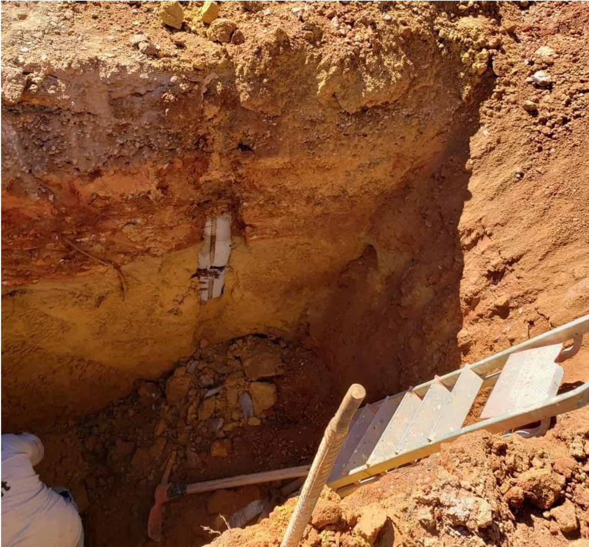
Figura 5.31. Escavação manual após nicho escavado mecanicamente.
