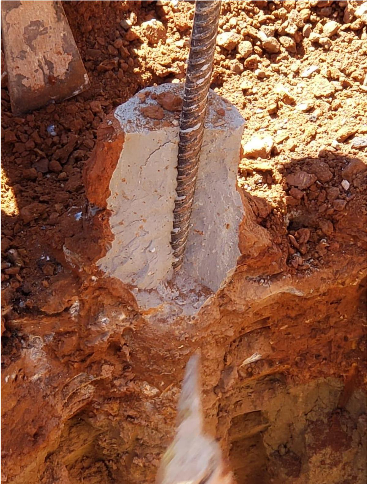
Figura 5.36. Detalhe de dano mecânico gerado pela escavação mecanizada
