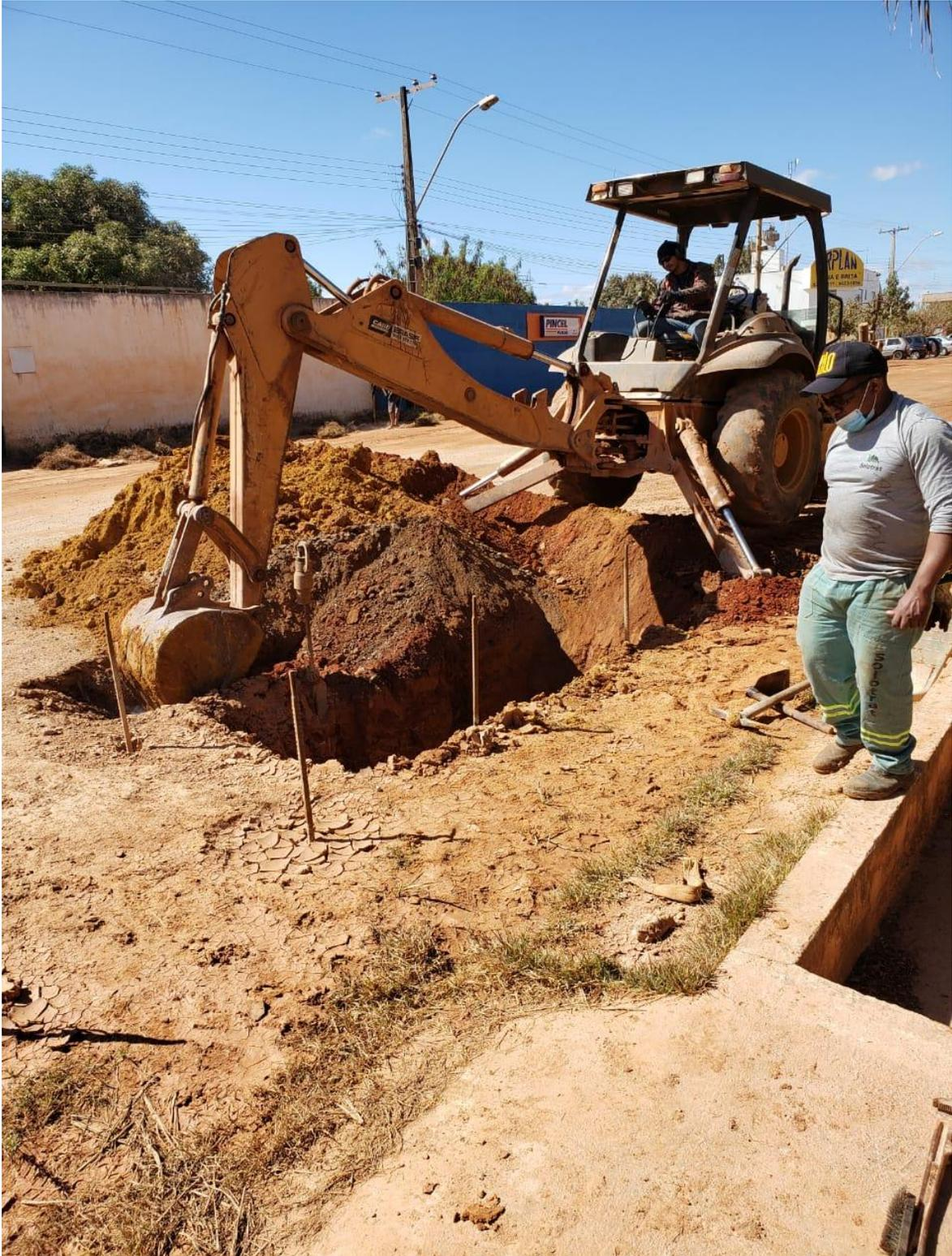
Figura 5.27. Escavação mecanizada entre grampos, feita após os ensaios de arrancamento, de forma que não houvesse influência do peso da retroescavadeira no ensaio.
