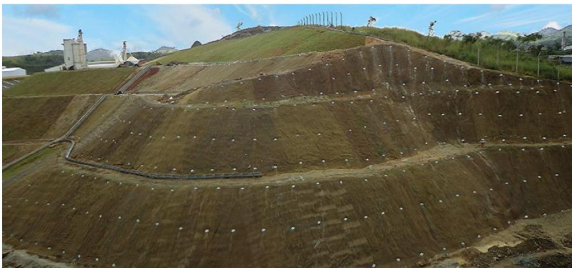
Figura 4.17. Contenção em solo grampeado com paramento flexível, tipo Macmat R1®, em 2013, primeira obra em paramento flexível com uso de grampos executados com reinjeção setorizada
