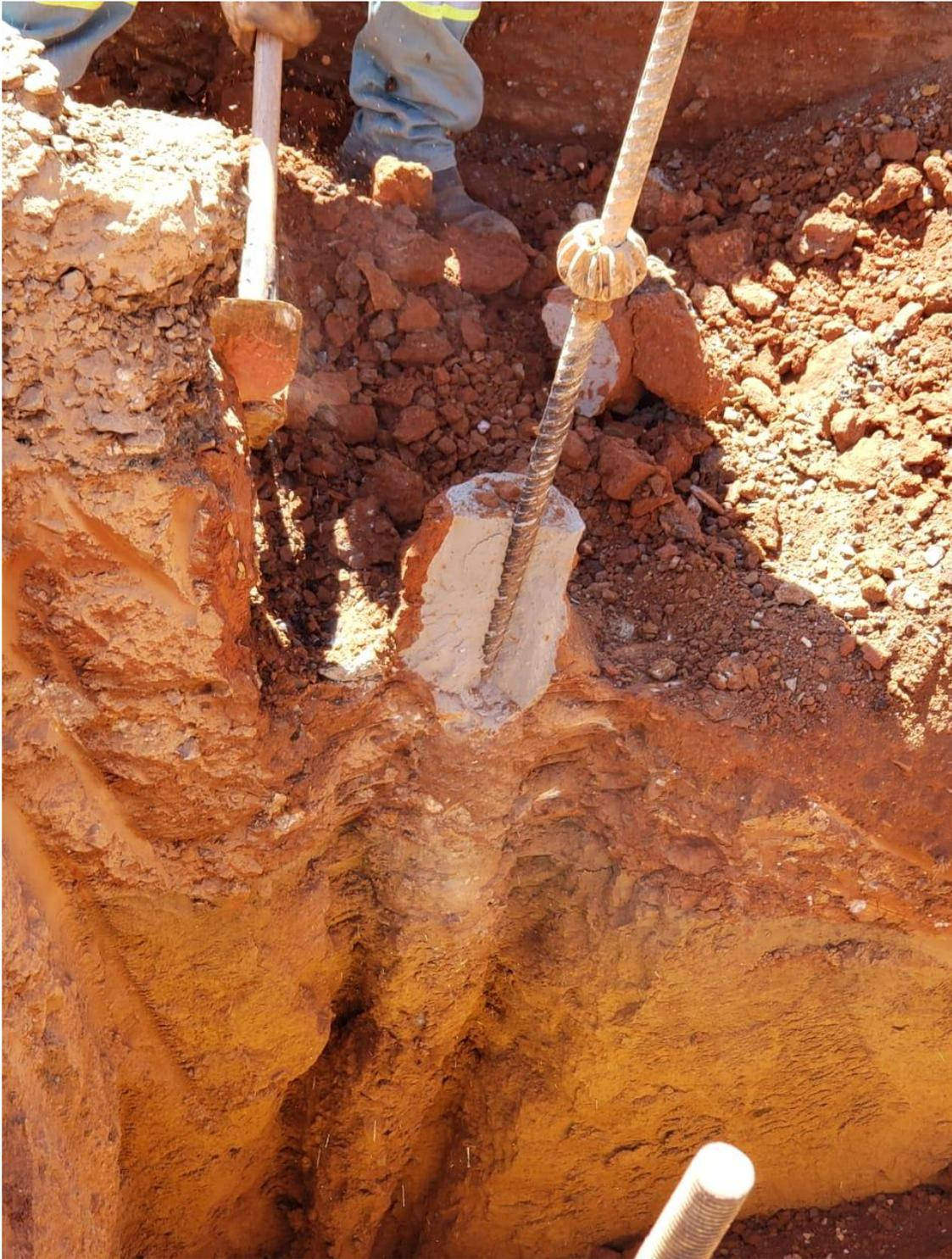
Figura 5.32. Escavação manual após nicho escavado mecanicamente. Detalhe da escavação do grampo 1.
