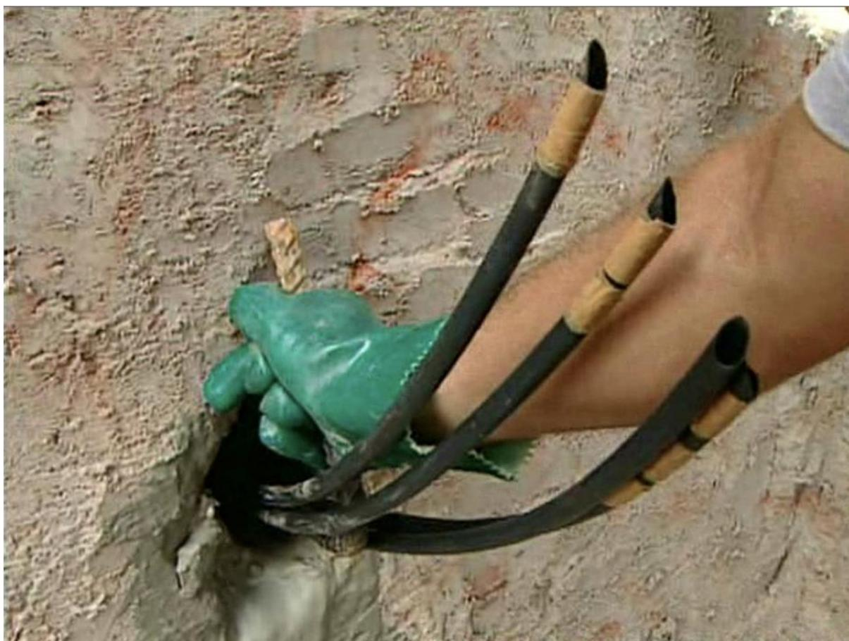
Figura 4.15. Cota superior de um grampo previamente à execução da reinjeção setorizada, em que cada setor é marcado com um símbolo específico, no caso uma fita gomada para o primeiro setor, duas fitas gomadas para o segundo setor e três fitas gomadas para o terceiro setor.
