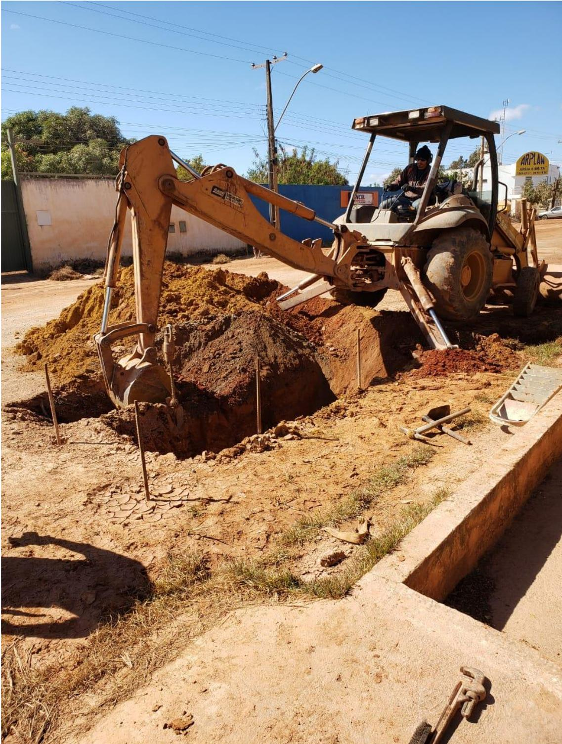
Figura 5.29. Escavação mecanizada entre grampos, feita após os ensaios de arrancamento, de forma que não houvesse influência do peso da retroscavadeira no ensaio.
