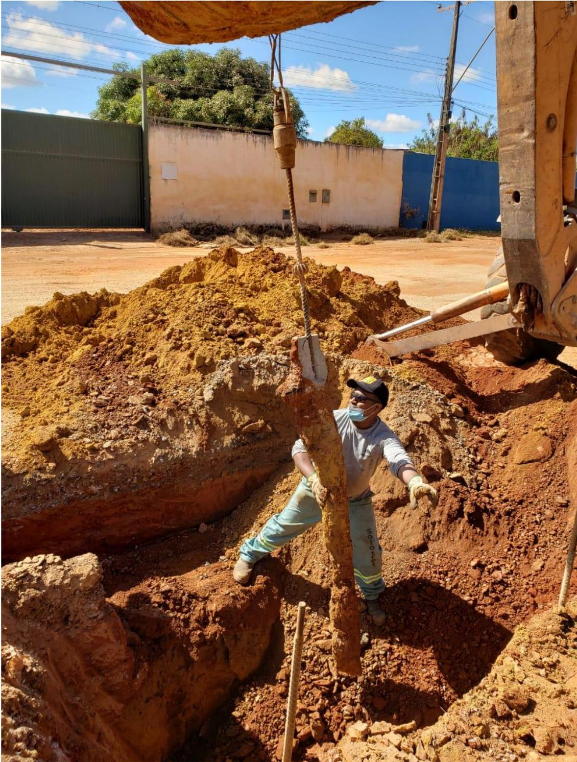
Figura 5.35. Detalhe de içamento mecanizado dos grampos, com auxílio de sinaleiro para içamento controlado.
