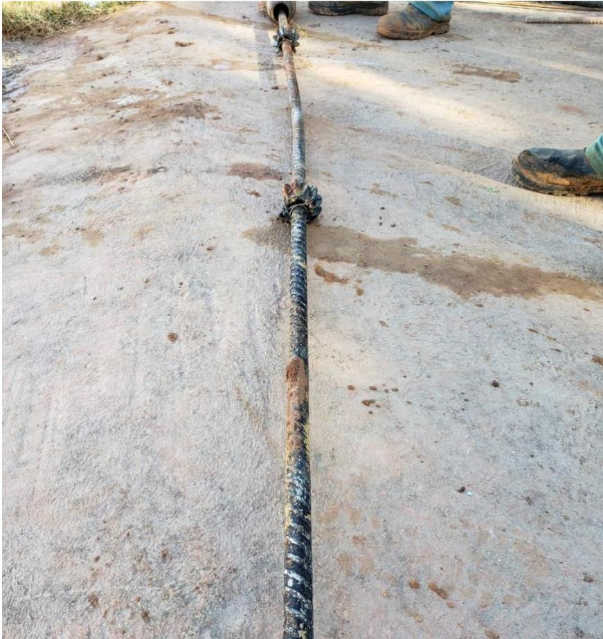
Figura 5.16 – Exemplo de barra antes da centralização no furo, com espaçadores tipo carambola a cada metro.
