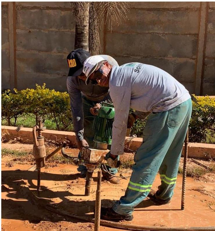
Figura 5.15 – Perfuratriz rotativa manual para execução de grampos com circulação de água
