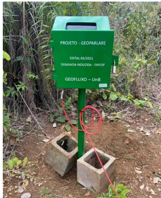
Figura 4.16 – Instalação em Campo de Dataloggers (Fonte: Projeto GeoPARLARE).
