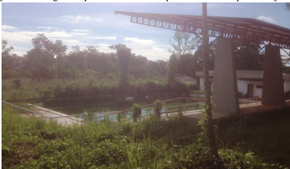
Figura 10 – Imagem da piscina do Centro Esportivo no município de Bujari/AC
