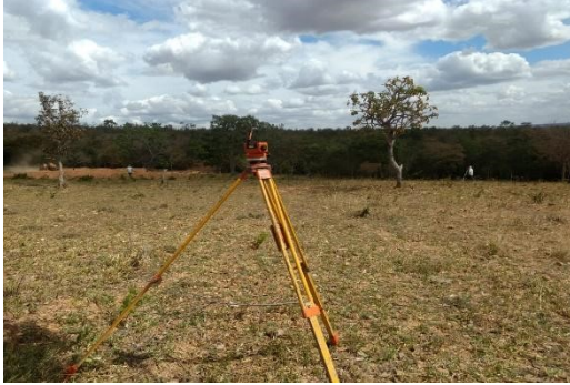
Marcação da linha de nível
