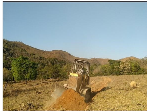
Construção com trator de esteira
