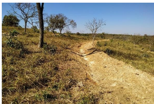
Terraço em construção
