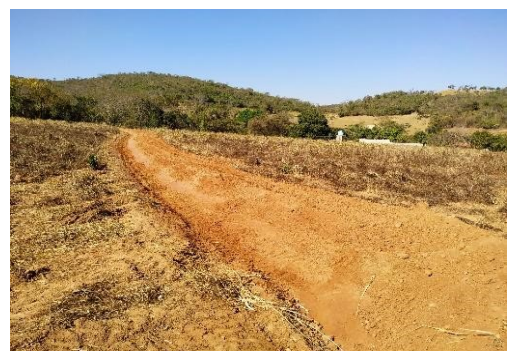
Terraço em construção
