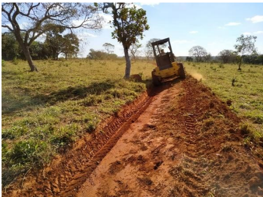
Construção com motoniveladora
