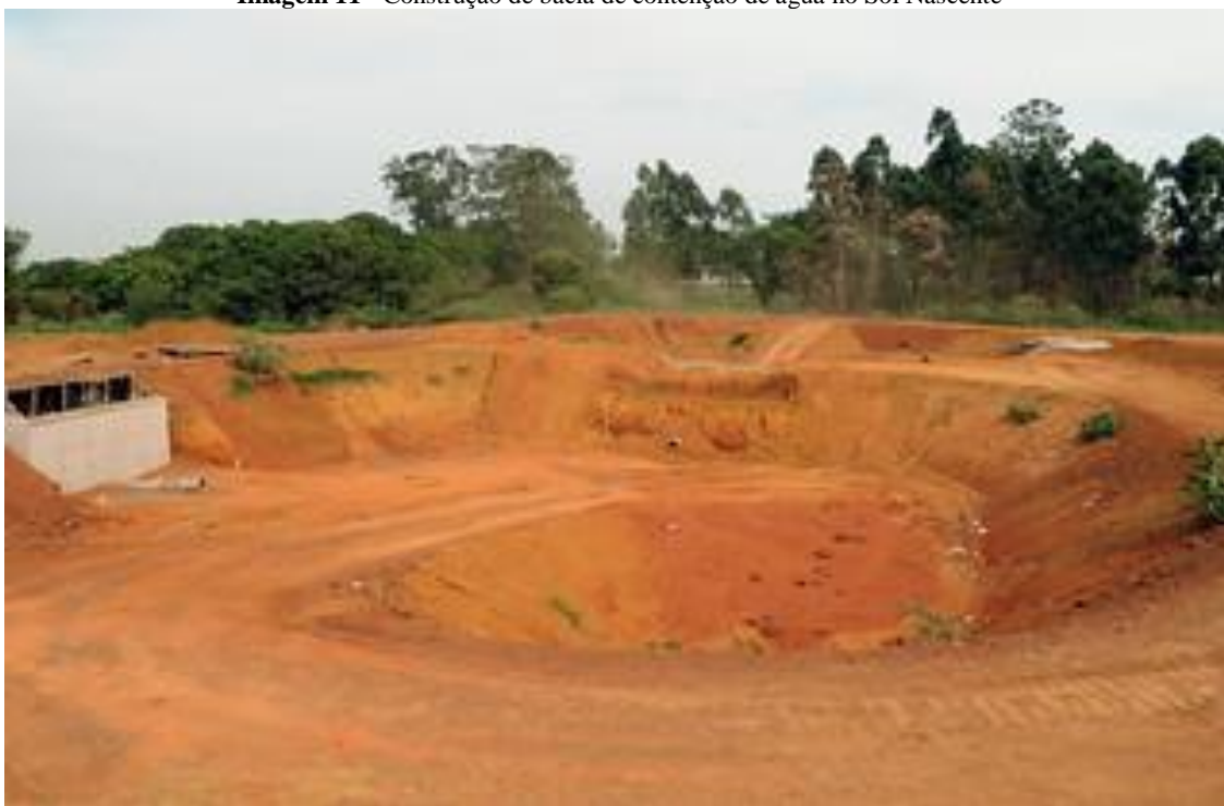
Imagem 11 - Construção de bacia de contenção de água no Sol Nascente
