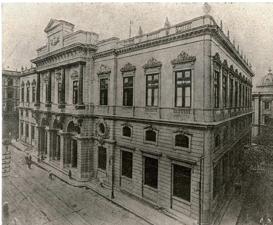
Imagem 2 – Fachada BB após a reforma 1926
