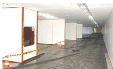
DIVISÓRIAS E CARPETES JÁ FORAM INSTALADOS: FALTAM APENAS RETOQUES NA BIBLIOTECA NACIONAL
