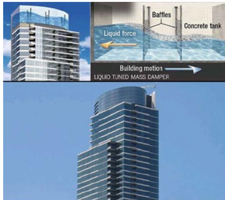
Figura 2.5 – Edifício One Rincon Hill e ilustração do seu atenuador do tipo TLD. Fonte: Kamgar et al. (2020).
