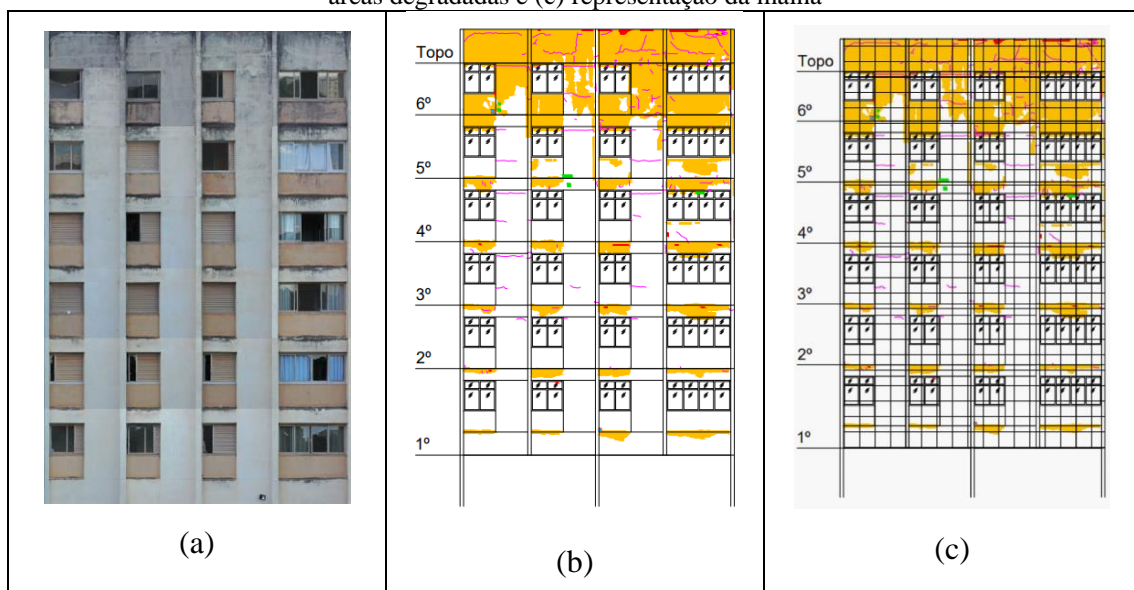
Figura 7 - Detalhes da definição da amostra: (a) obtenção da imagem digital e ortogonalização, (b) esboço de áreas degradadas e (c) representação da malha
