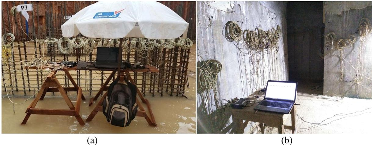
Figura 3.56. Leitura das deformações dos sensores instalados durante a cura do radier (a) e após a passagem dos cabos para o interior do fosso do elevador (b).
