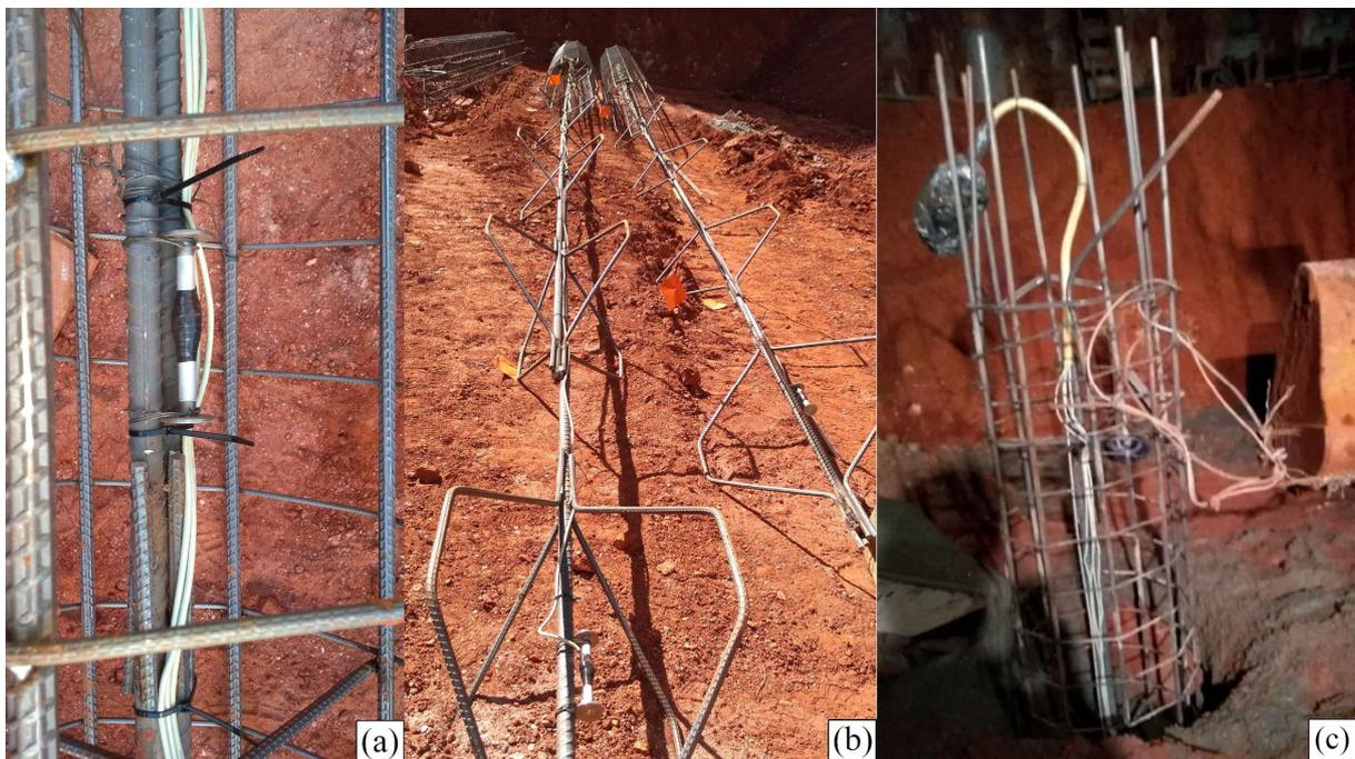
Figura 3.30. Detalhe do sensor de imersão preso à ferragem da estaca da prova de carga (a) ferragem das provas de carga (b) e detalhe para ferragem parcialmente inserida na estaca PCE-02 (c).
