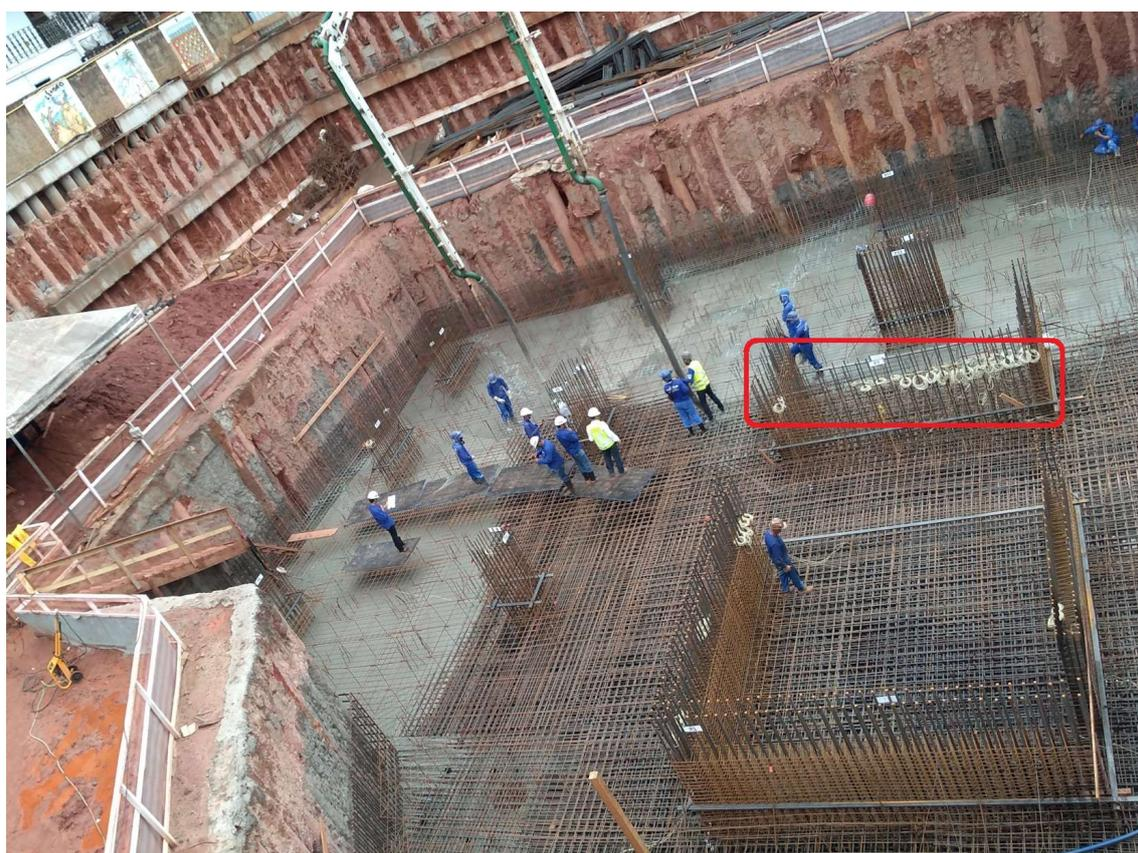
Figura 3.55. Cabos presos ao arranque dos pilares durante a concretagem do radier.
