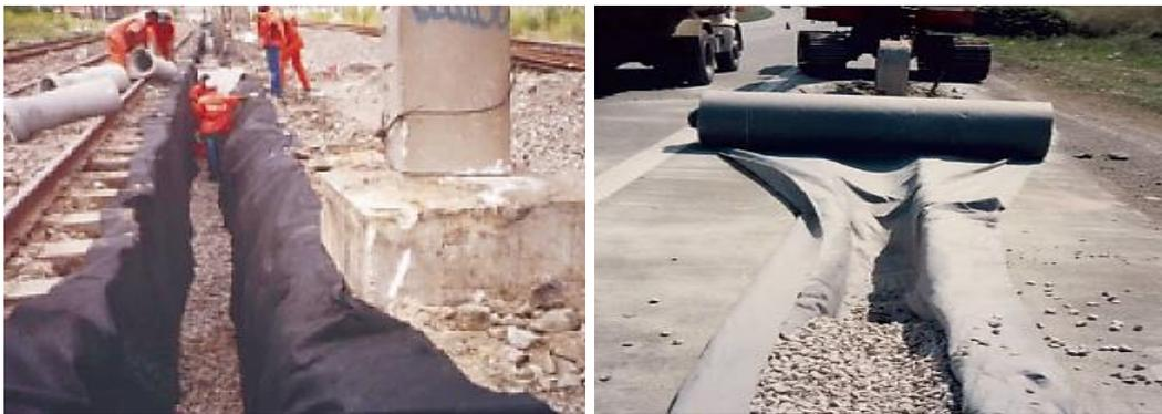
Figura 2.5. Dreno longitudinal utilizando geotêxtil como elemento filtrante, a) Ferrovia; b) Rodovia (ABINT, 2001; Bidim, 1991).
