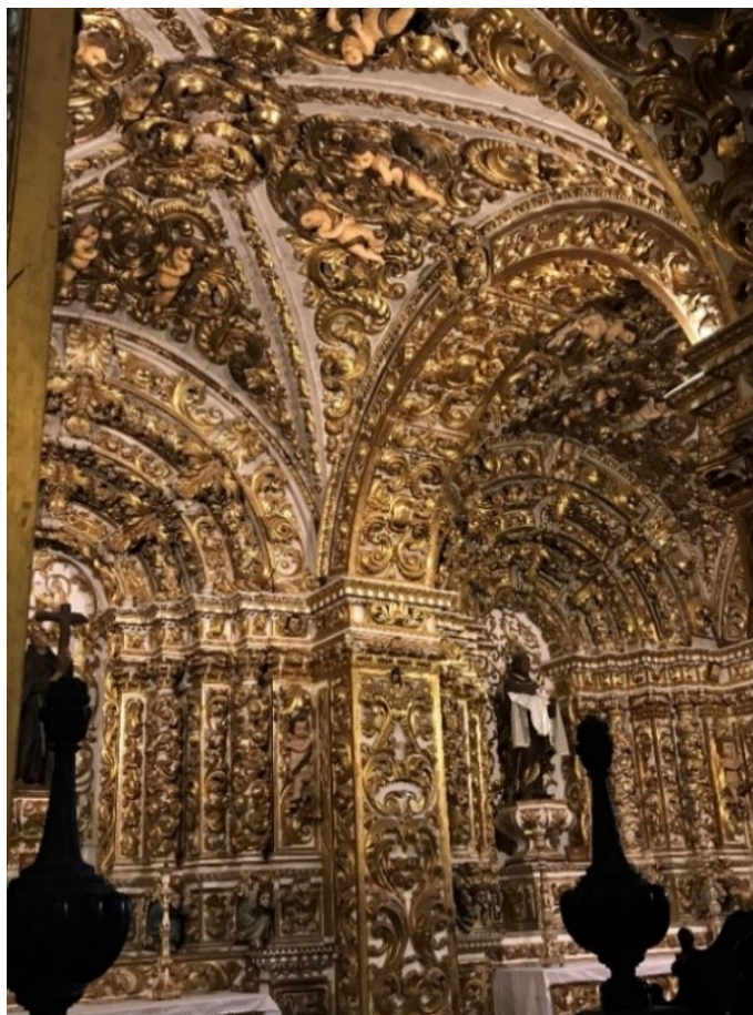
Figura 9. Detalhes da talha dourada da Igreja de São Francisco em Salvador, Bahia, dez. 2021. Acervo: arquivo pessoal do autor
