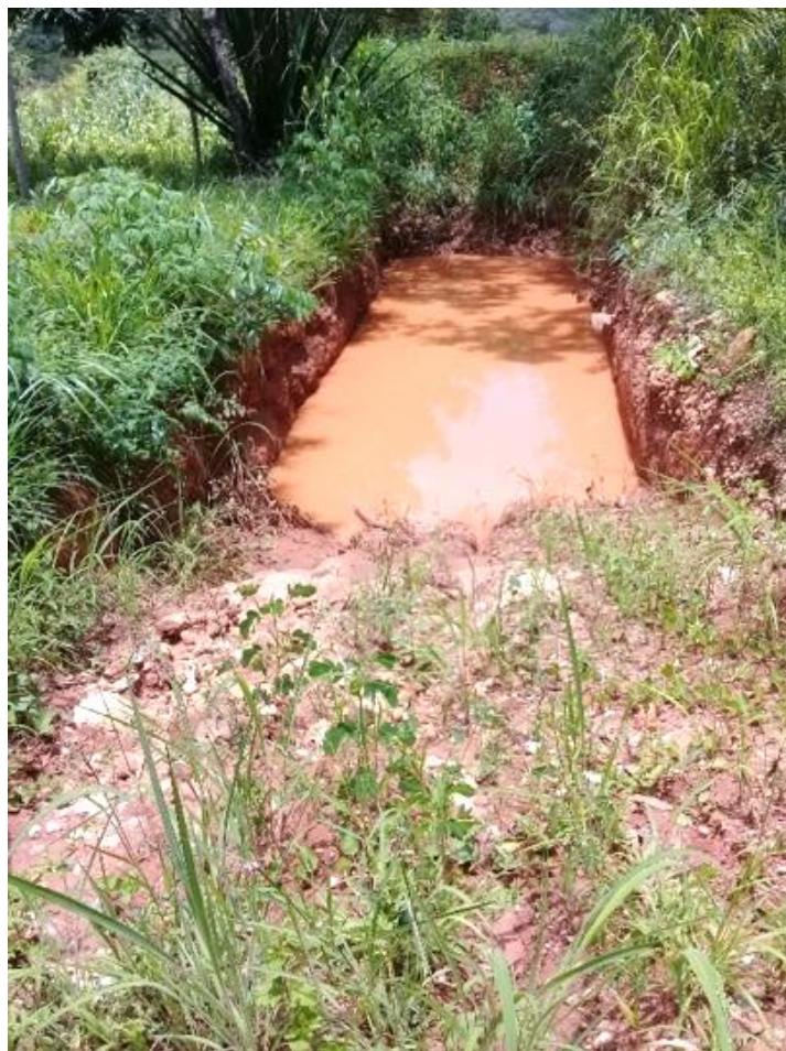
Figura 45 - Pequena barragem de contenção de enxurradas construídas na área da RDS/NG.
