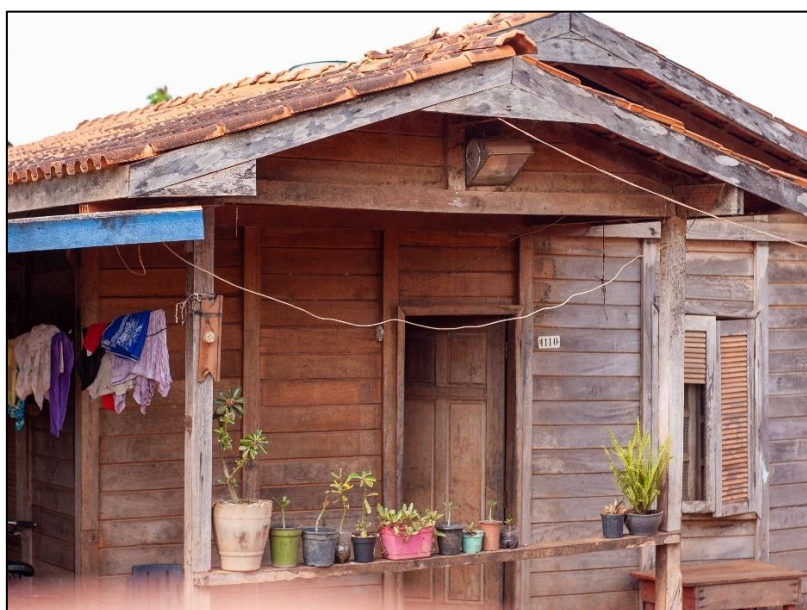
FIGURA 3. Imagem de habitação que teve 1 varanda externa ampliada. Fonte: Imagem capturadas por Ícaro Benetti, julho 2021.
