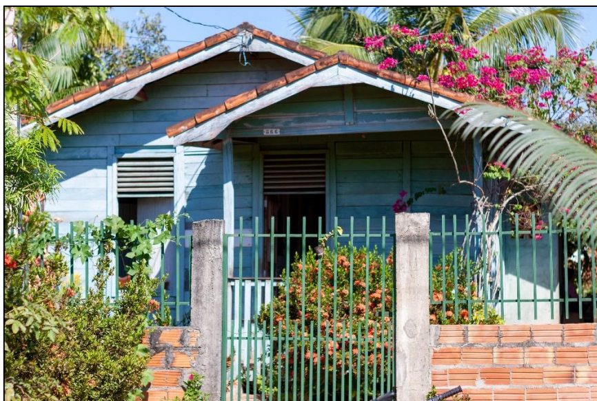
FIGURA 2. Imagem de habitação que teve 1 quarto e 1 cozinha ampliados Fonte: Imagem capturadas por Ícaro Benetti, julho 2021.
