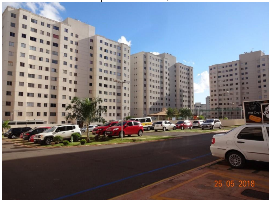
Figura 4. Interior de um condomínio JC Gontijo no bairro Parque das Cachoeiras em Valparaíso de Goiás, GO.
