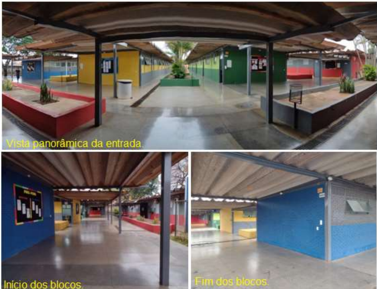
Figura 6 - Blocos de sala de aula CEF 10
