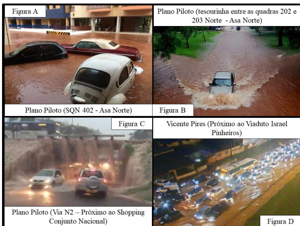
Figura 73 – Impactos dos alagamentos no sistema viário (Distrito Federal).
