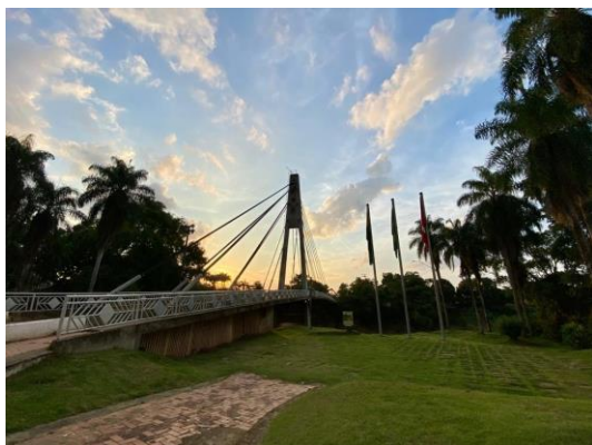
Figura 84 – Ponte Internacional Wilson Pinheiro, vista a partir da margem esquerda do rio Acre, em Brasília
