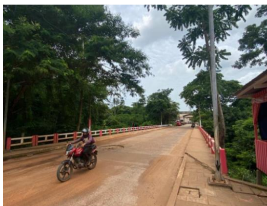
Figura 86 – Ponte internacional sobre o Igarapé Bahia, a partir de Epitaciolândia, com vista para Cobija
