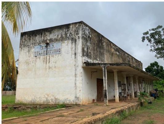
Figura 134 – Antiga estação Vila Murтинho da Estrada de Ferro Madeira Mamoré
