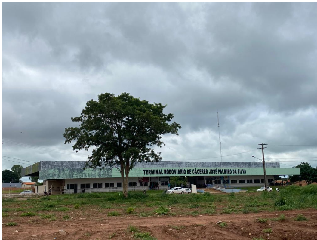
Figura 213 – Terminal rodoviário de Cáceres
