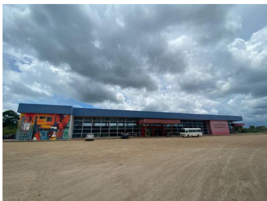
Figura 244 – Terminal rodoviário de Puerto Suárez
