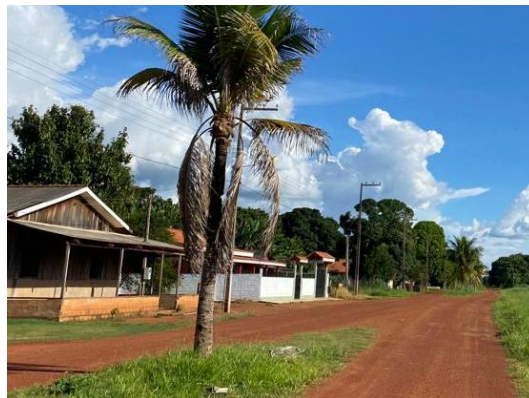
Figura 194 – Residências na rua do Forte, na comunidade de Forte Príncipe da Beira
