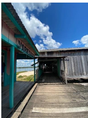
Figura 182– Corredor sobre palafitas entre as construções em madeira de Buena Vista
