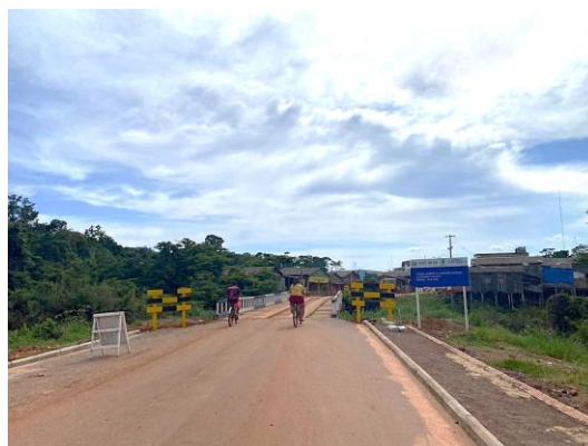
Figura 108 – Ponte sobre o igarapé Rapirrã, entre Brasil e Bolívia, com o acesso a Puerto Evo, a partir de Plácido de Castro
