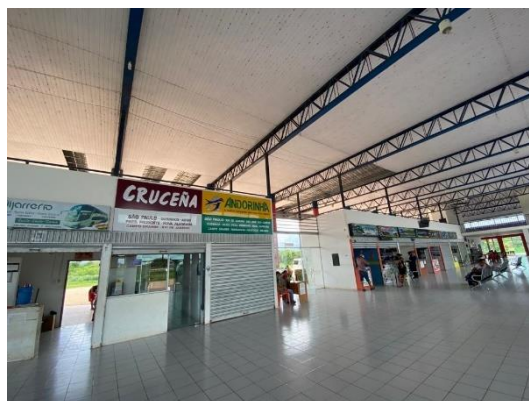
Figura 245 – Terminal rodoviário de Puerto Suárez
