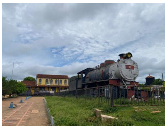
Figura 159 – Antiga estação da Guajará-Mirim, da Estrada de Ferro Madeira Mamoré, em perspectiva a partir da praça dos Pioneiros, próxima ao porto
