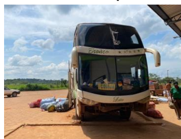
Figura 93 – Terminal rodoviário de Cobija: área de embarque
