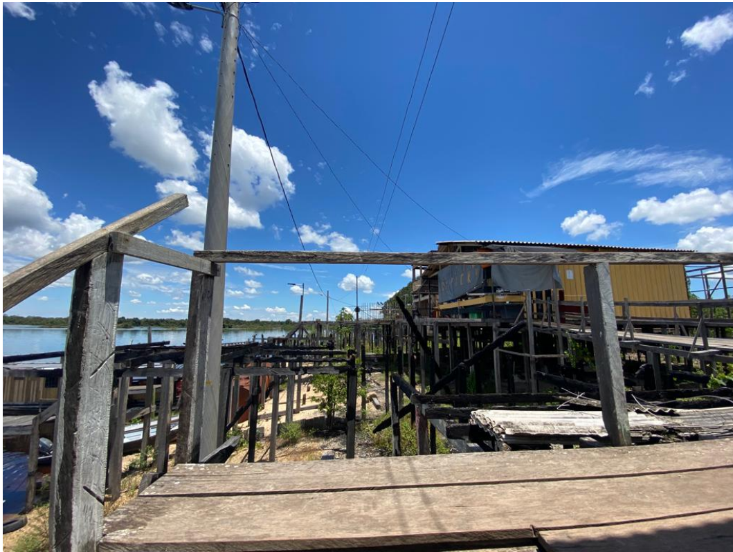
Figura 185 – Estrutura sobre palafitas destruída pelo incêndio em Buena Vista, ocorrido em 2019
