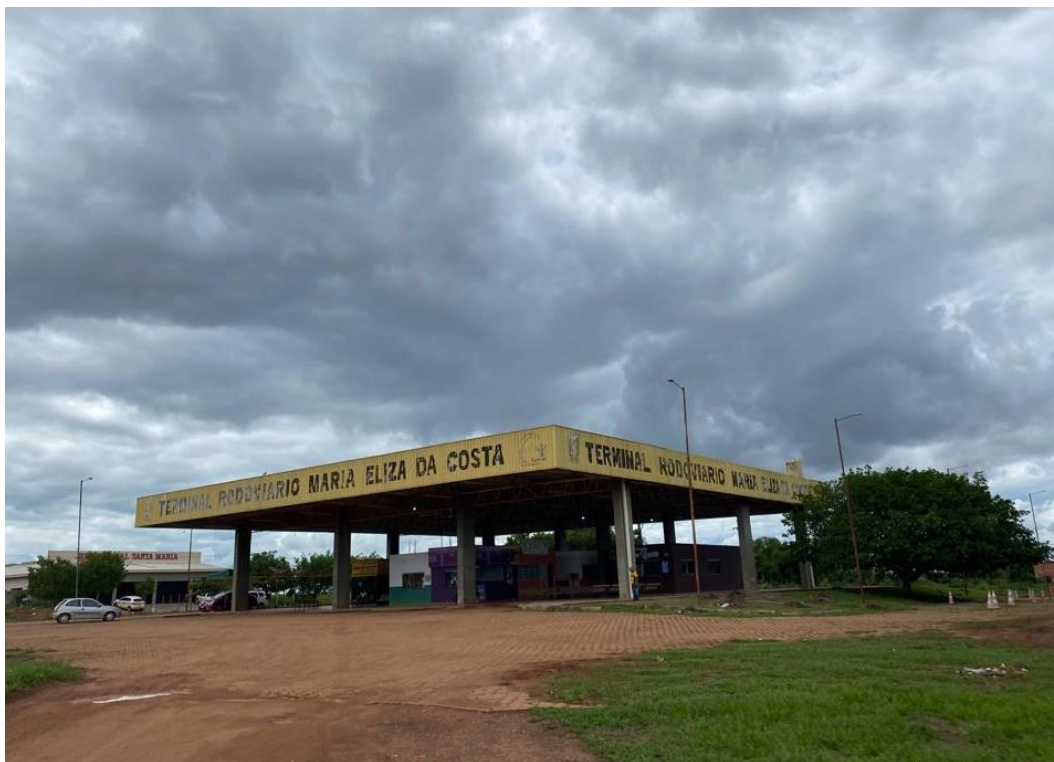
Figura 150 – Terminal rodoviário de Nova Mamoré
