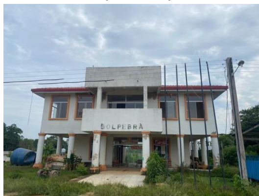
Figura 73 – Sede do Poder Público municipal de Bolpebra
