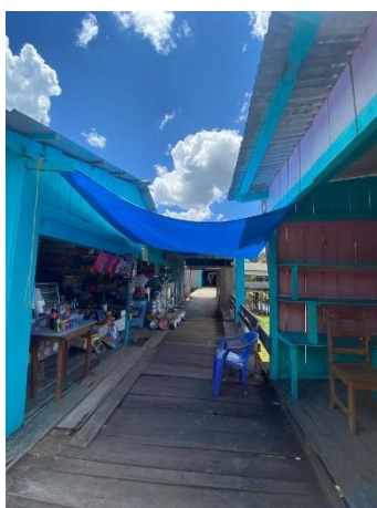
Figura 183 – Corredor sobre palafitas entre as construções em madeira de Buena Vista
