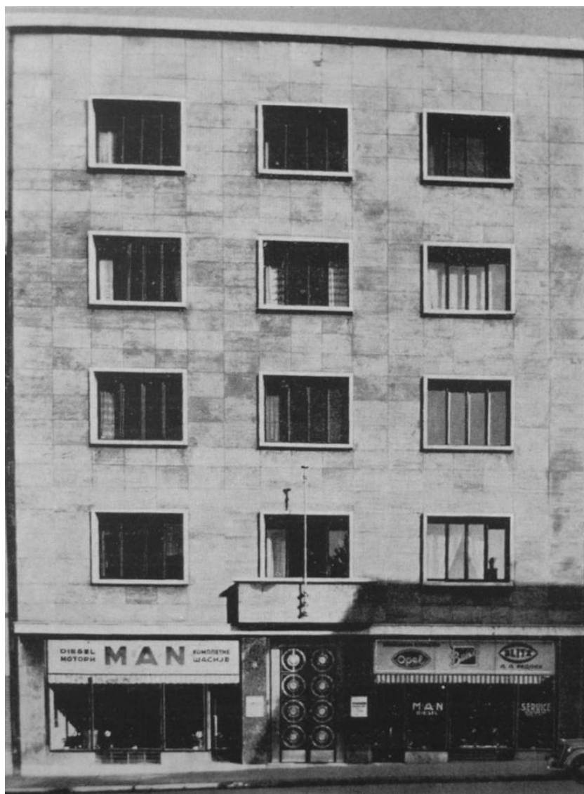
4.90. Fachada principal, anos 1930. Fonte: BLAGOJEVIĆ, 2003.
