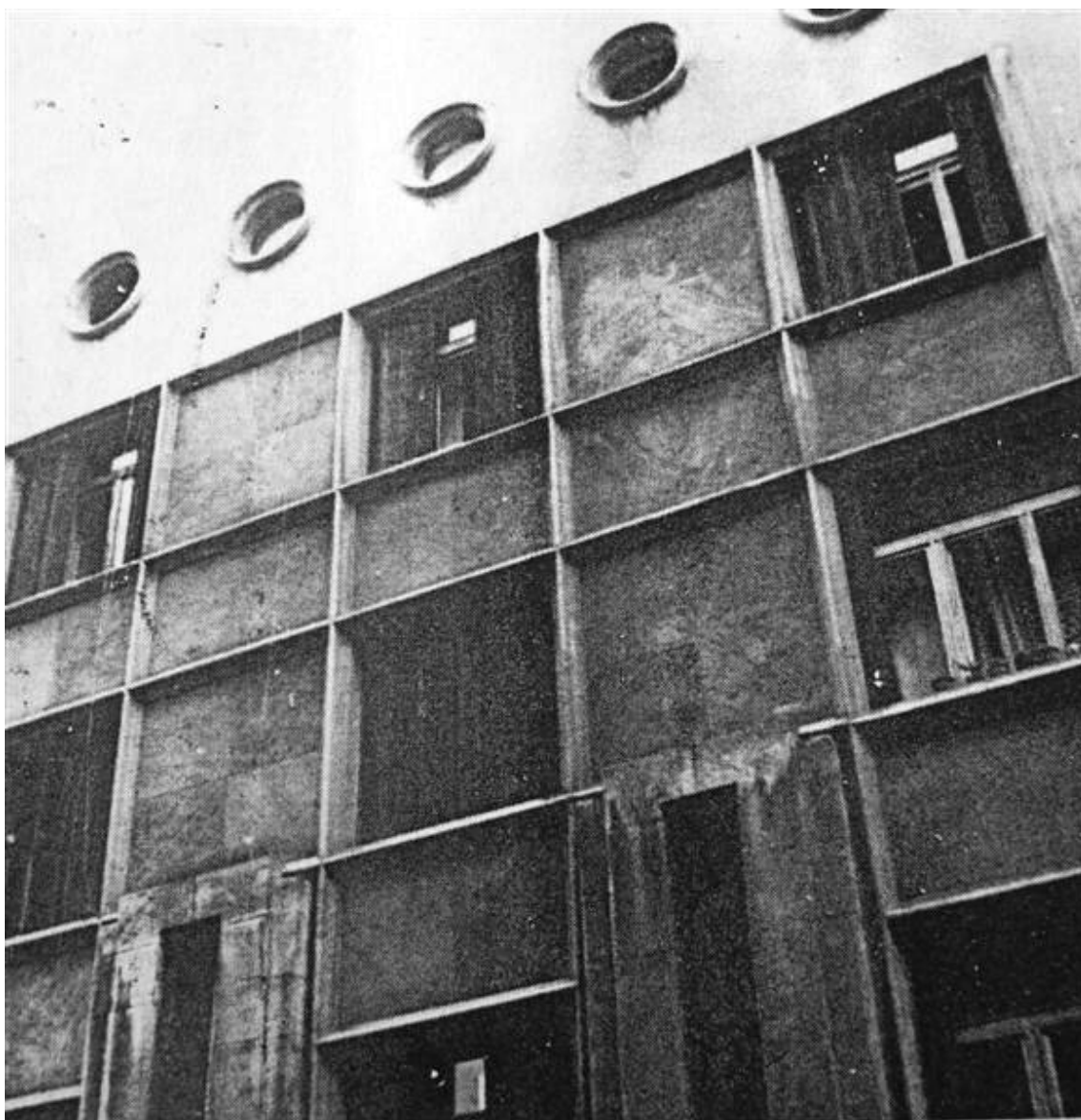
4.74. Fachada principal, fotografia contemporânea. Fonte: MARTINOVIĆ, 1972.
