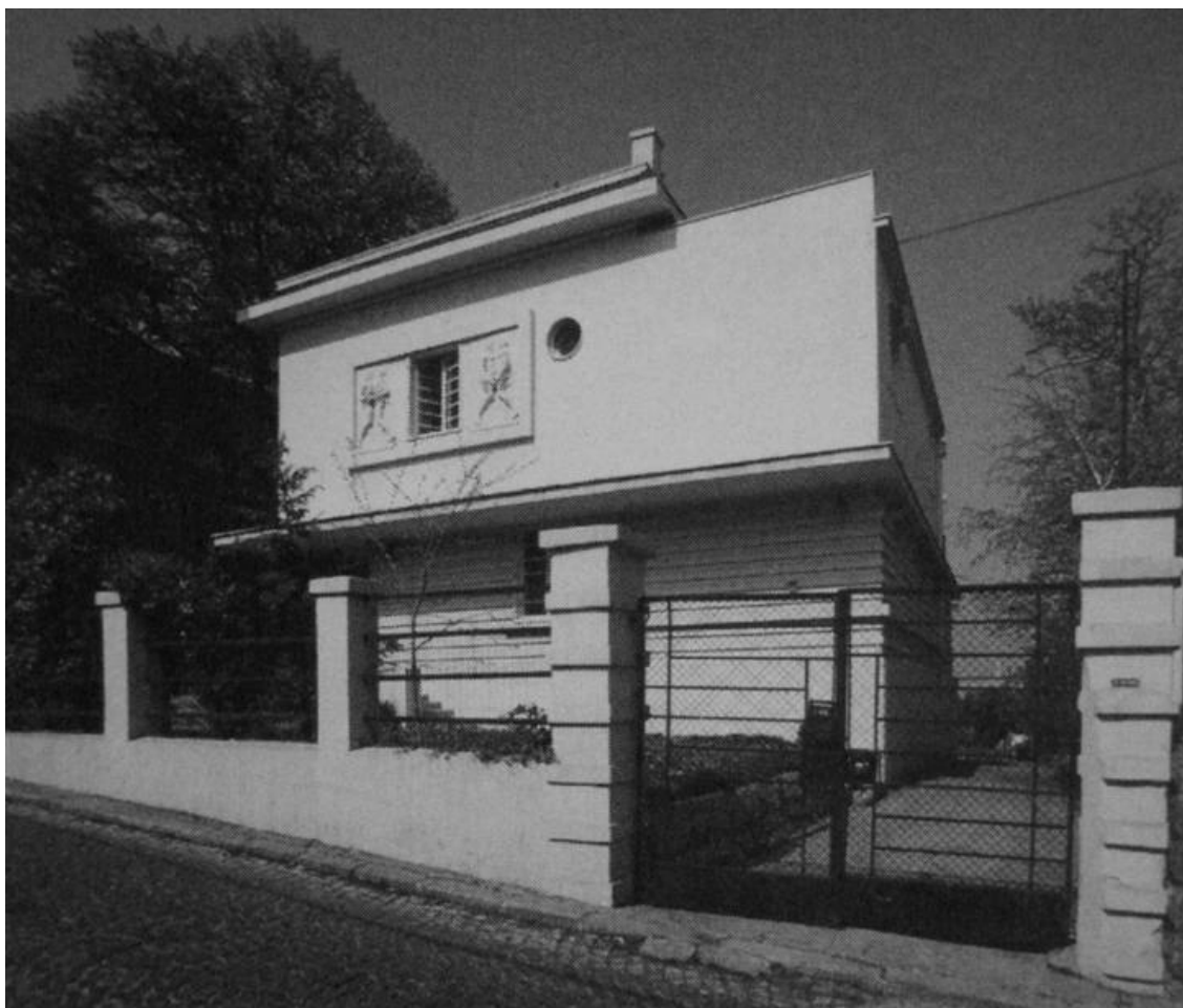
4.41. Fachada principal, fotografia contemporânea. Fonte: BLAGOJEVIĆ, 2003.
