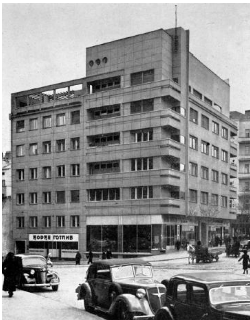
4.91. Fachada principal nos anos 1930. Fonte: Arquivo Histórico de Belgrado.
