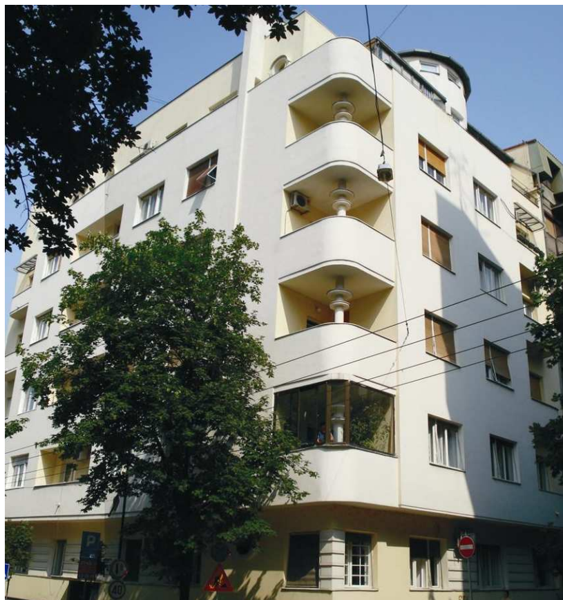
4.96. Vista da esquina. Fonte: arquivo pessoal, 2007.
