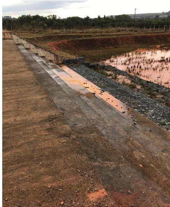
Figura 12 - Vertedouro do reservatório de qualidade para o reservatório de quantidade.
