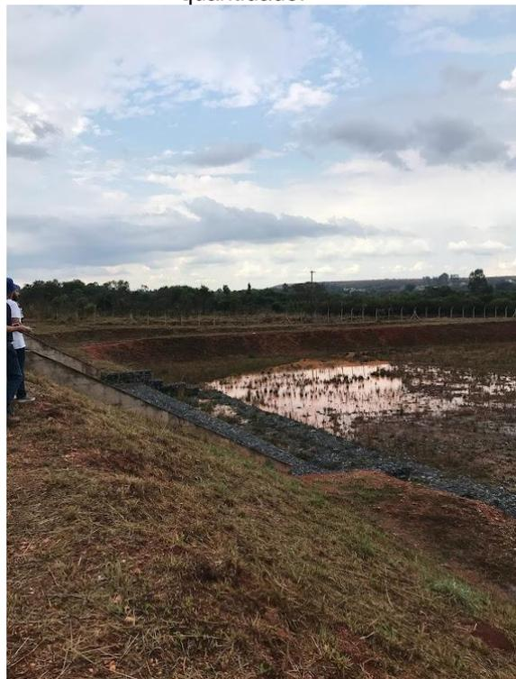
Figura 14 - Vertedouro do reservatório de qualidade para o reservatório de quantidade.
