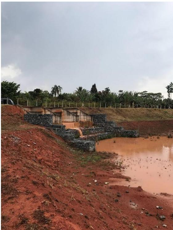
Figura 13 - Dissipador de drenagem pluvial e parte do reservatório de qualidade.
