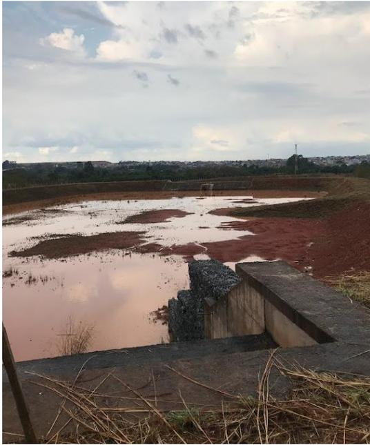
Figura 11 - Dissipador de macrodrenagem na entrada do reservatório de qualidade.
