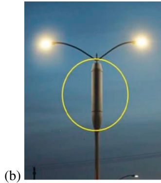
Figura 4.26: Calçada com equipamento 5G [167]
