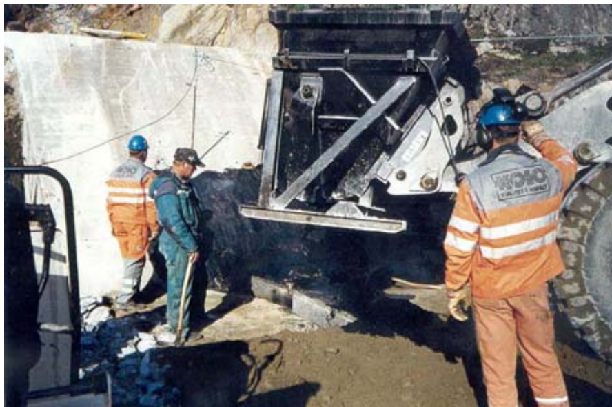
Figura 2.27 - Aplicação do concreto betuminoso com formas metálicas (Kolo, 2003).
