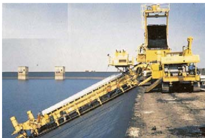
Figura 2.9 - Ponte acabadora operando na parte superior do talude de montante (Walo, 1994).
