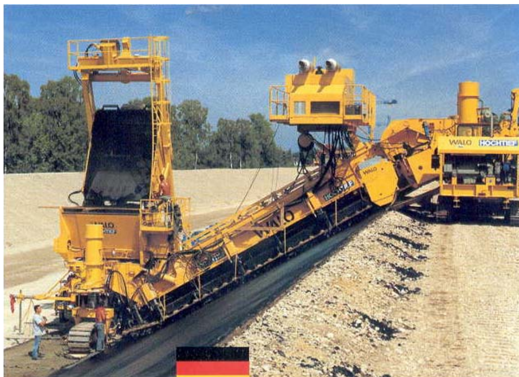
Figura 2.32 - Construção do canal Lech, Alemanha (Walo, 1997a).
