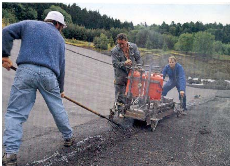
Figura 2.13 - Tratamento da junta perimetral (Walo, 1997a).
