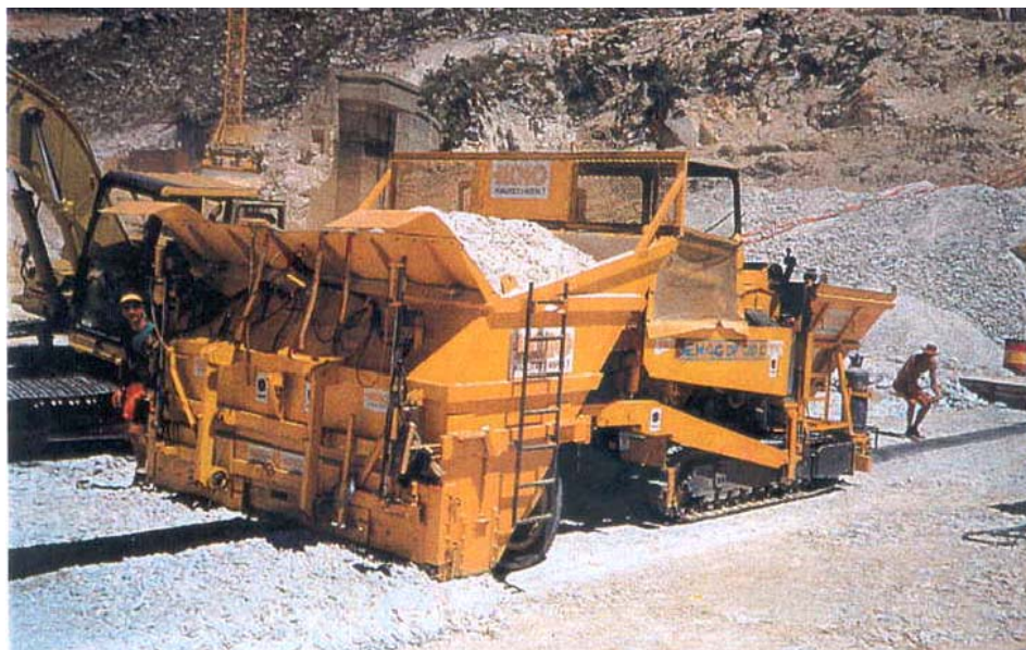
Figura 2.21 – Máquina pavimentadora em execução (Kolo, 2003).
