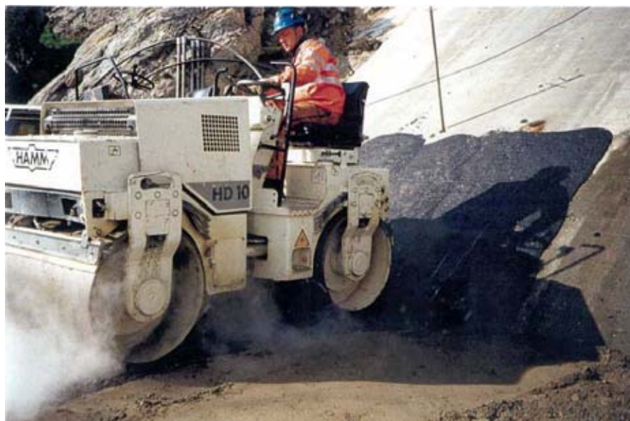
Figura 2.29 - Compactação do núcleo junto a estrutura de concreto (Kolo, 2003).
