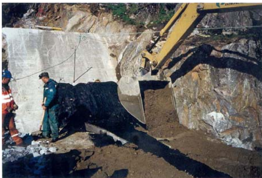
Figura 2.28 - Colocação das camadas de transição ao lado das formas metálicas (Kolo, 2003).
