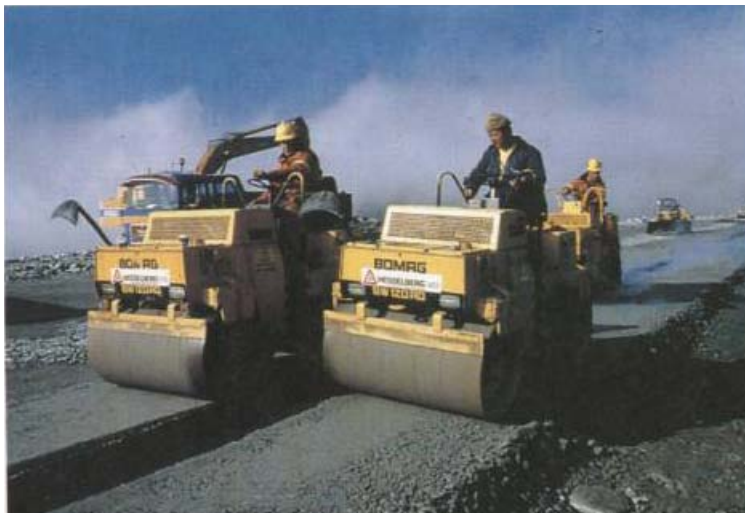
Figura 2.22 - Compactação do núcleo e transições (Höeg, 1993).
