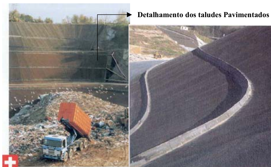
Figura 2.34 - Depósito de lixo Valle della Motta, Suíça (Walo, 1997a).
