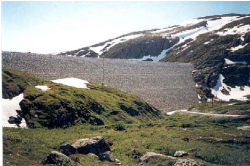
Figura 2.24 – Barragem Storglovant com 125 metros de altura (Kolo, 2003).
