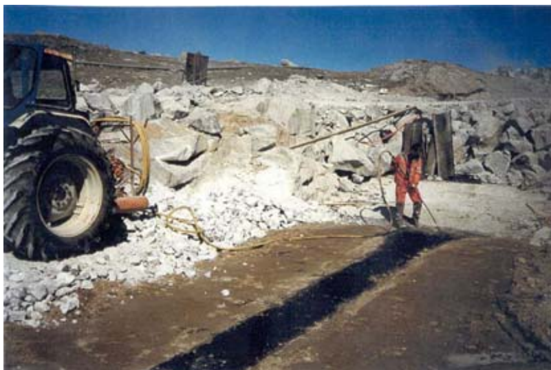
Figura 2.25 - Limpeza da base de concreto com jateamento de ar comprimido (Kolo, 2003).
