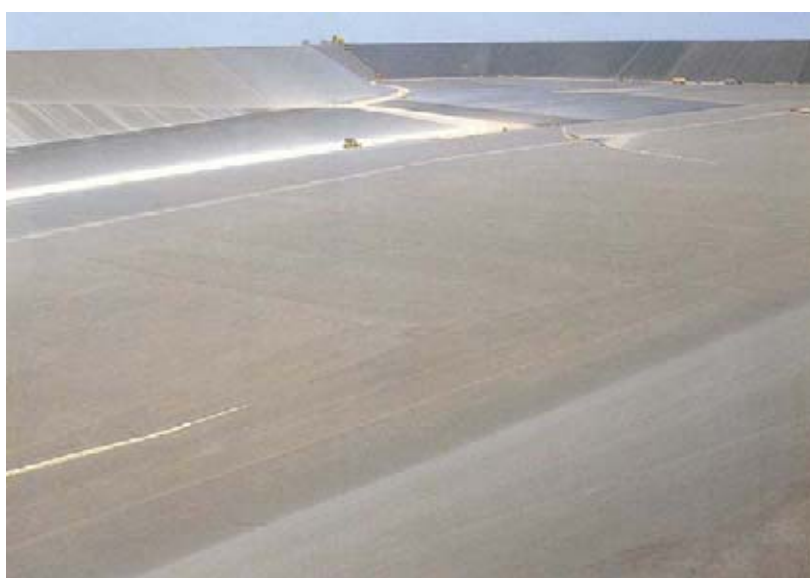
Figura 2.35 - Reservatório de bombeamento Goldisthal, Alemanha (Walo, 2001).
