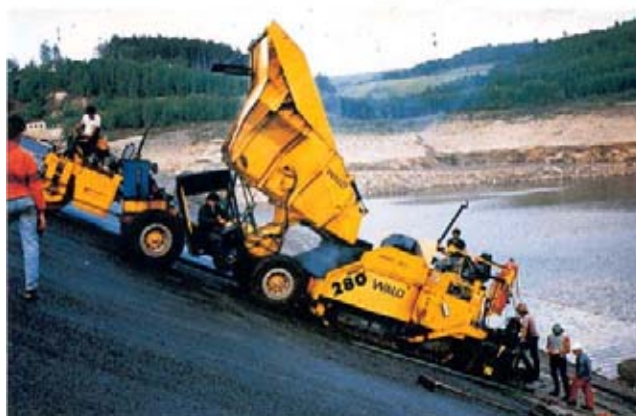
Figura 2.11 – Dumper abastecendo a pavimentadora ao longo do talude (Walo, 1994).
