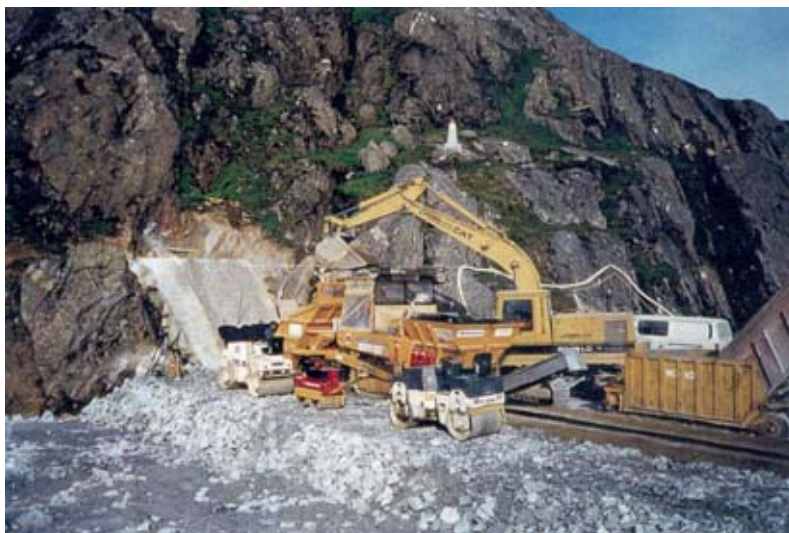
Figura 2.26 - Paver pronta para iniciar a execução de uma nova camada (Kolo, 2003).
