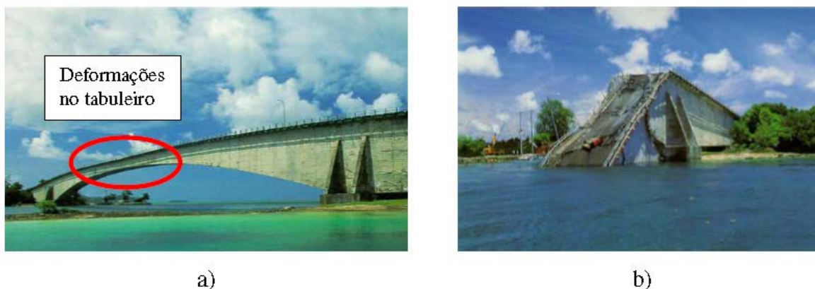
Figura 1.1 - Ponte Koror-Babeldaob em Palau: a) Deformações excessivas a meio vão; b) Colapso da ponte
