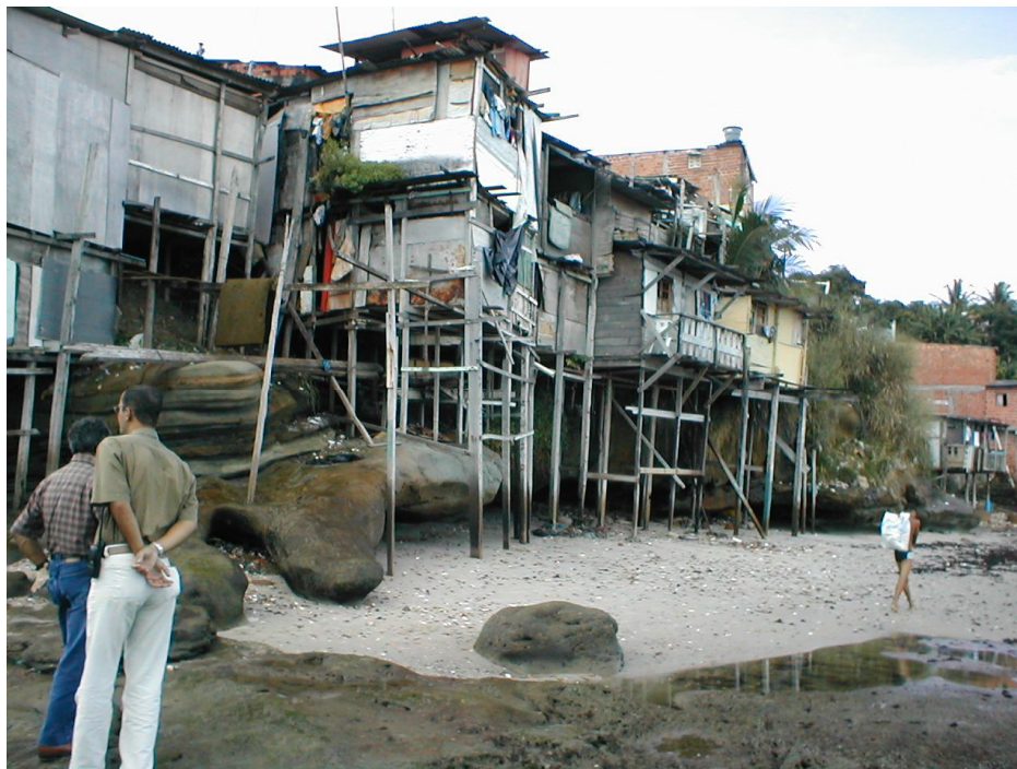
Figura 1.2 – Palafitas no Bairro de Pedra Furada, em Salvador. A ocupação não permite implantação de rede de esgotamento sanitário. As casas não possuem instalações sanitárias.
