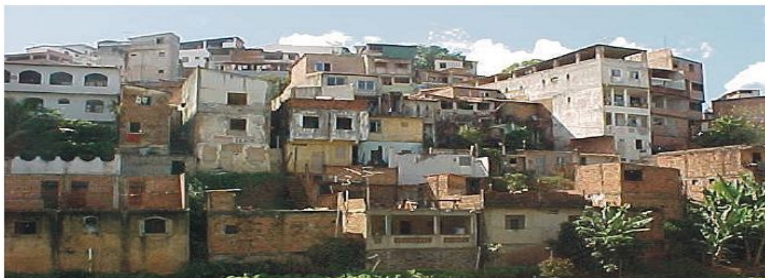
Figura 2.5.1 – Ocupação espontânea em encosta do bairro de São Marcos, na cidade de Salvador, sem os arruamentos e drenagem pluvial, dificultando a implantação de abastecimento de água e esgotamento sanitário.
