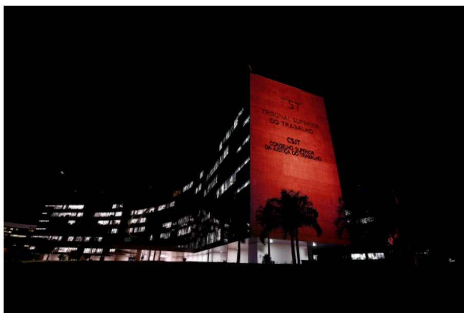
Figura 30 – Tribunal Superior do Trabalho (TST). Retirado de https://www.tst.jus.br . Acesso em 4 de julho de 2023.
