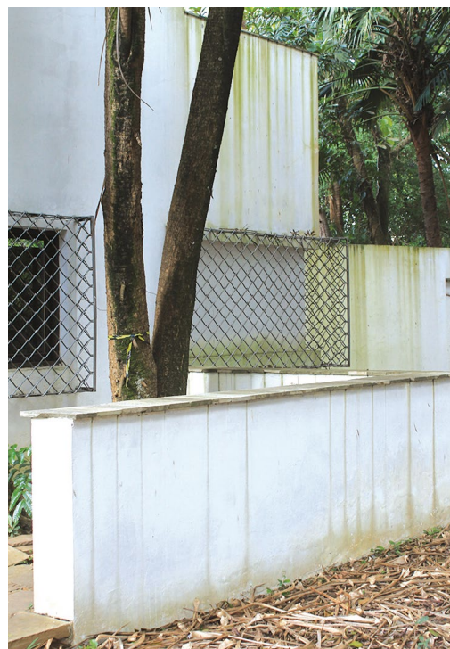
Figura 7.9. Situação atual. Fachada sul. Janela sudeste, fechada na reforma de 1934-35. O arquiteto manteve a simetria existente, usando um baixo-relevo e um gradil semelhante aos demais.
