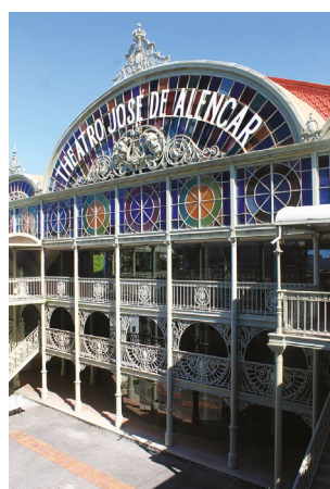
Figura 5.83. Teatro José de Alencar. Pátio interno e fachada do volume da plateia.
