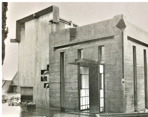
Figura 5.58. Mausoléu Brion. Concreto projetado para envelhecer. 96
