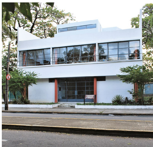
Figura 6.38. Antigo Pavilhão de Verificação de Óbitos (Recife). Tentativa de pilotis, janela em fita, teto plano. Elementos e organização próprios de uma época.
