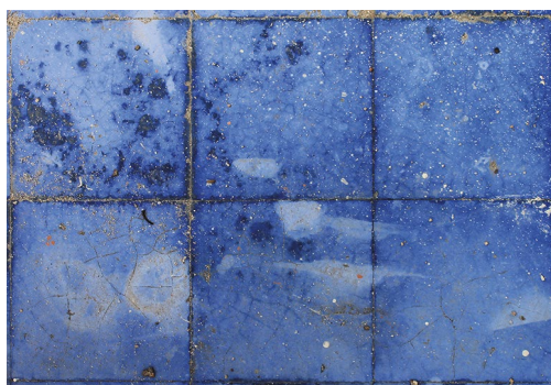
Figura 5.69. Pavilhão Luiz Nunes, Recife. Ladrilhos hidráulicos. Marcas do tempo sobre material íntegro.
