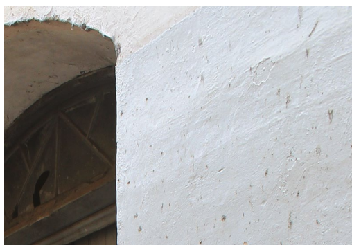
Figura 5.72. Cantina de vinhos, em Serafina Corrêa. Textura resultante das múltiplas repinturas.
