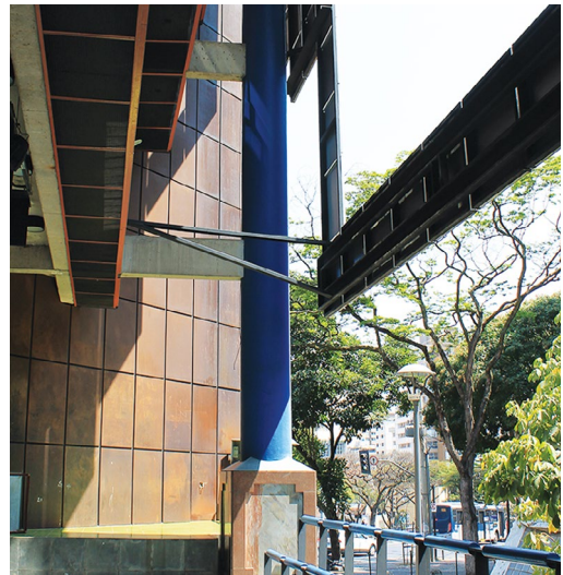
Figura 6.11. Fachada leste, dupla, vista de baixo. A camada externa se apoia na camada interna por meio de hastes de aço.
