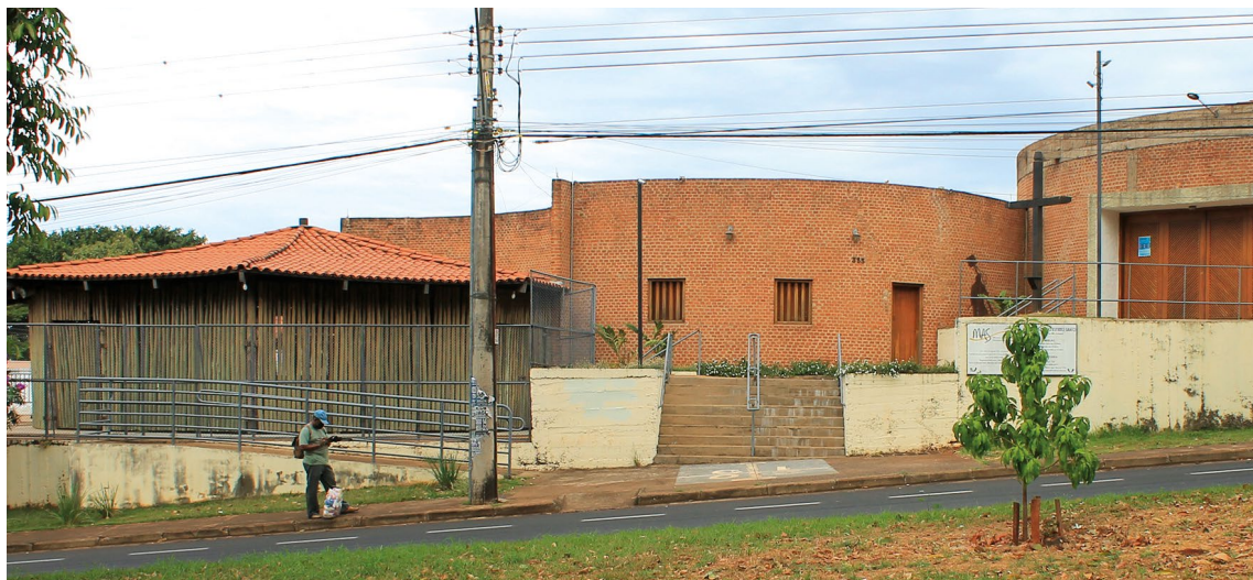
Figura 7.69. Vista a partir do norte, 2021. Observar instalação de rampas e guarda-corpos.
