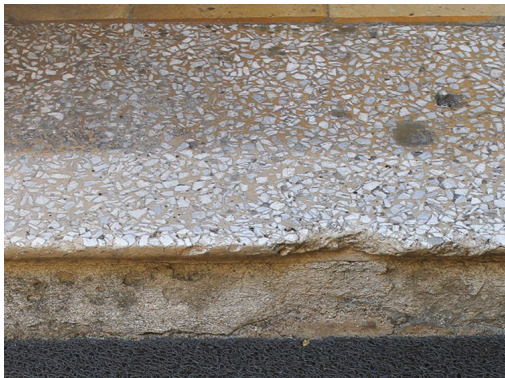
Figura 5.78. Palacete Argentina, em Porto Alegre. Degrau em granilite exposto aos agentes atmosféricos. Lacunas de médio porte.
