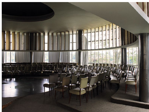
Figura 8.23. Interior do restaurante/auditório. Papel dos rebatedores acústicos na definição do espaço.
