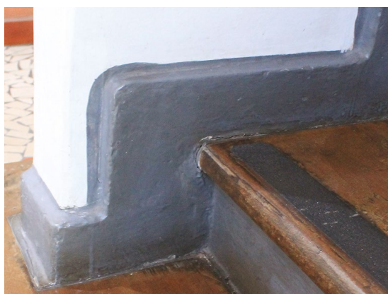
Figura 5.21. Argamassa pintada. Material tradicional frágil, que pode acumular valor de antiguidade pela repetição de manutenções. Museu Professor Zoroastro Artiaga, em Goiânia. Rodapé da escada.
