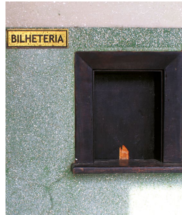
Figura 5.75. Rádio Difusora de Caruaru. Granilite com partículas de mica, em diálogo com o revestimento em pó de pedra. O envelhecimento deste material, junto à bilheteria, reforça as evocações do uso.
