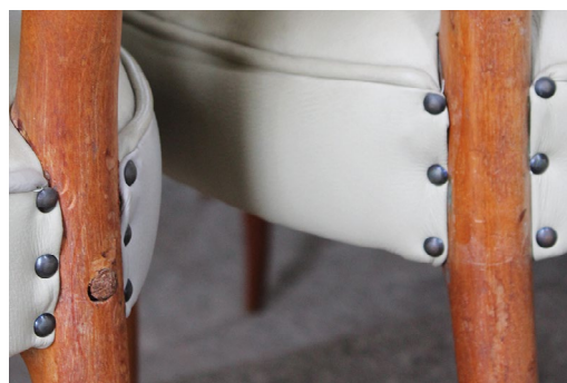
Figura 8.65. Cadeiras remanescentes. Observar arranhões, alterações cromáticas e marcas de reparos na estrutura em madeira.
