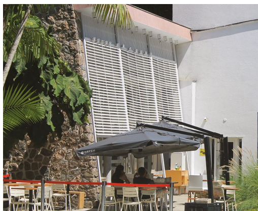
Figura 5.11. Esquadrias da sala de jantar. Observar discreta flexão dos brises horizontais.
