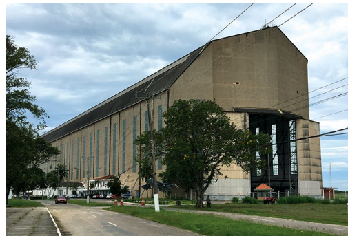
Figura i.16. Hangar de Santa Cruz (antigo hangar de dirigíveis). 1936. Rio de Janeiro.
