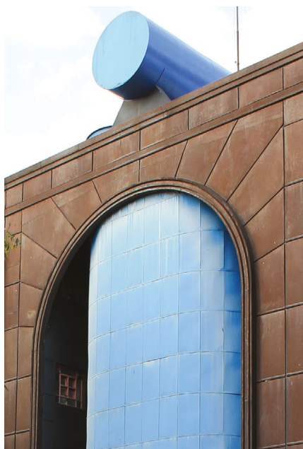
Figura 6.15. Marcação de rusticação no revestimento em chapas de aço na fachada sudoeste.
