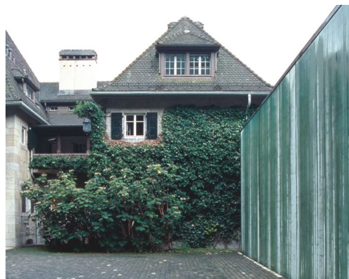
Figura 5.59. Galeria Oskar Reinhart, Winterthur. Superfície projetada para ser alterada pelos agentes atmosféricos. 97
