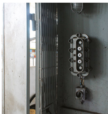
Figura 6.51. Elevador de passageiros e de carga, com seus elementos de fechamento, controle e iluminação iniciais.
