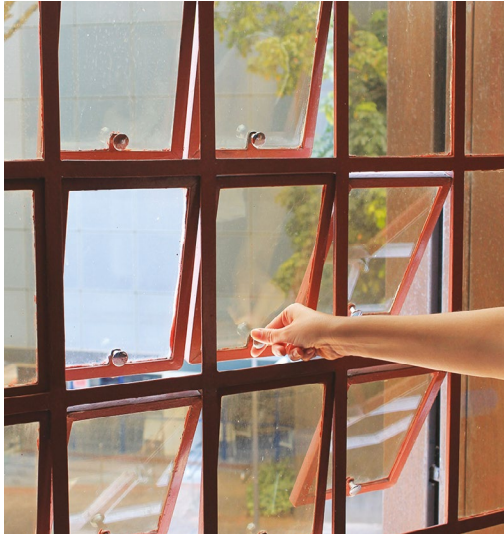
Figura 6.8. Esquadrias de aço do volume que contém as escadarias. Rótulas ou janelas maxim air em miniatura.
