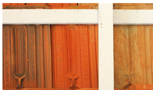
Figura 5.108. Casa da Cultura de Pires do Rio. Variações na coloração, textura e fabricante do telhamento, associadas a três momentos de fornecimento.
