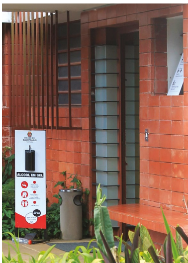
Figura 7.14. Esquadria de acesso. Volume de vidro translúcido, protegido por barras de aço.
