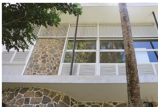
Figura 5.13. Alvenaria de pedra, fachada sudeste. Volume da escada, juntas limpas e pintadas.
