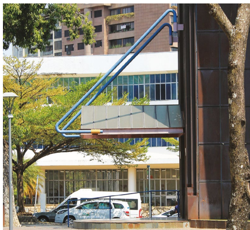
Figura 6.13. Marquise sobre o acesso, com estrutura metálica e fechamento em vidro.
