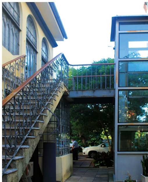
Figura 7.97. À direita, plataforma para acessibilidade (2007–2008), ligada ao patamar da escada de 1928. Sob a escada, envidraçamento dos vãos do pavimento inferior (1993–2003).
