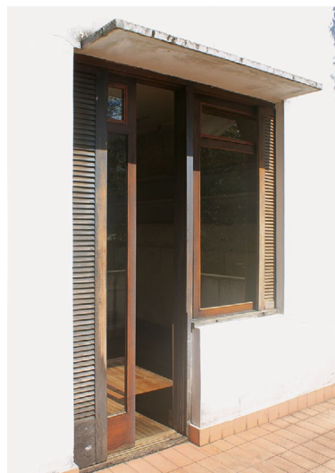
Figura 7.15. Esquadria do quarto sudoeste. Combinação de marquise, porta e janela, folhas de correr e de tomar, venezianas e vidro.
