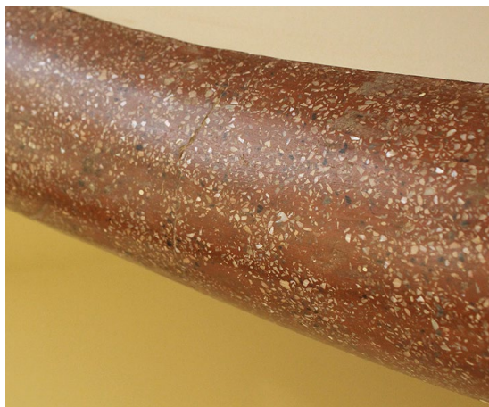
Figura 5.20. Granilite. Material moderno com alta durabilidade, que frequentemente apresenta valor de antiguidade relevante. Estação Ferroviária de Goiânia. Corrimão da escada da torre.
