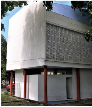
Figura i.17. Pavilhão Luiz Nunes (antigo pavilhão de de verificação de órbitas). 1937. Recife.
