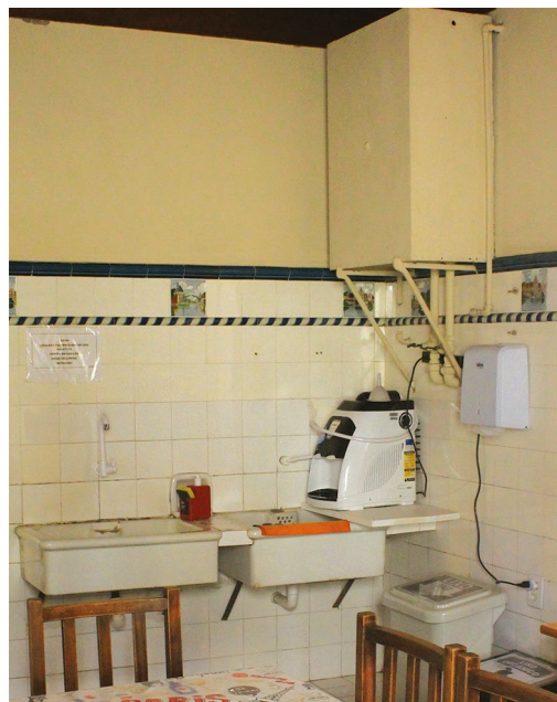
Figura 7.100. Cozinha. Observar cubas, azulejos e caixa d'água remanescentes do uso enquanto residência.
