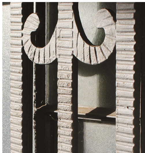
Figura 5.97. Teatro Goiânia. Textura resultante das sucessivas repinturas sobre barras de aço com seus próprios relevos.
