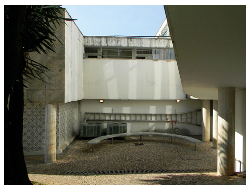
Figura 8.36. 1995–1996. Demolição de volume anexo, para recriação de área descoberta.
