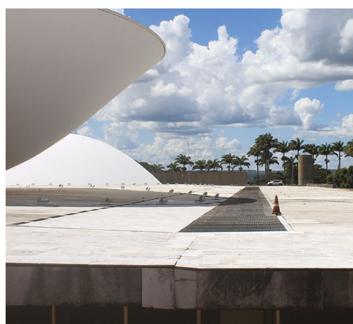
Figura 7.32. À esquerda, trecho inicial, com cobertura mais inclinada. Ao centro, grelha sobre o jardim. À direita, ampliação de 1968. Na borda da plataforma, a emenda entre os corpos é mais visível.
