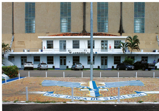
Figura 6.52. Antigo terminal de passageiros, atual Comando da Ala 12.
