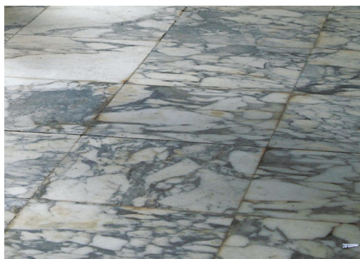
Figura 6.96. Mármore do piso do foyer térreo, com alterações cromáticas.
