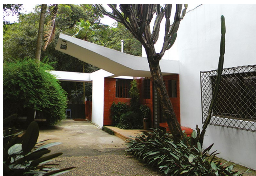
Figura 7.10. Fachada oeste (trecho). Marquise inserida na reforma de 1934–35. Ao fundo, passagem coberta para edículas.
