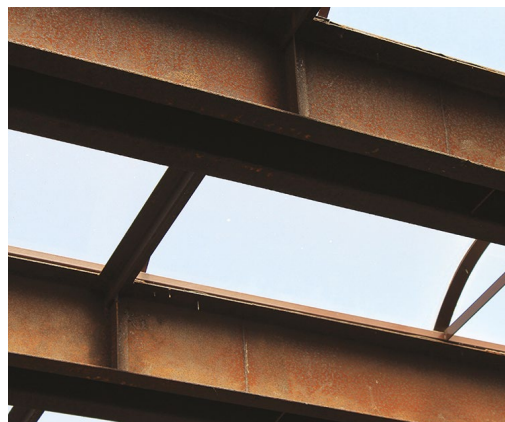
Figura 5.55. Sede da Chesf, vigas em aço corten, visíveis no pátio interno.
