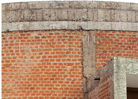
Figura 7.71. Detalhe do volume da nave (2021), depois da recuperação da alvenaria de tijolos e limpeza desse material e do concreto aparente.
