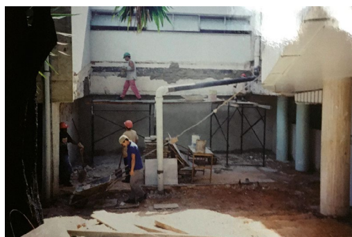
Figura 8.34. Novo pátio, em área descoberta recriada. 139
