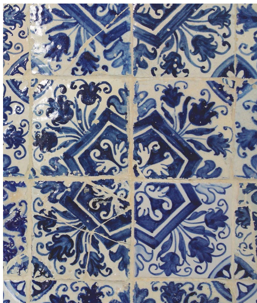
Figura 5.9. Sala íntima, detalhe dos azulejos do século XVIII, com fissuras e pequenas lacunas.
