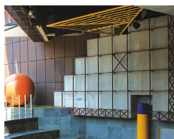
Figura 6.22. Ao alto, elementos acessórios em tubos de aço no teatro de arena da Rainha da Sucata.
