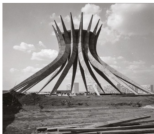
Figura 7.80. Vista geral da Catedral em 1966, seis anos após a primeira interrupção de suas obras. 158
