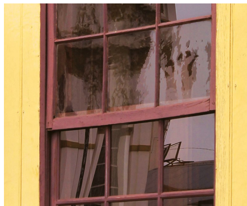
Figura 5.106. Casa da Neni. Variação de textura entre vidros irregulares, mais antigos, e vidros perfeitamente planos, substituídos posteriormente.
