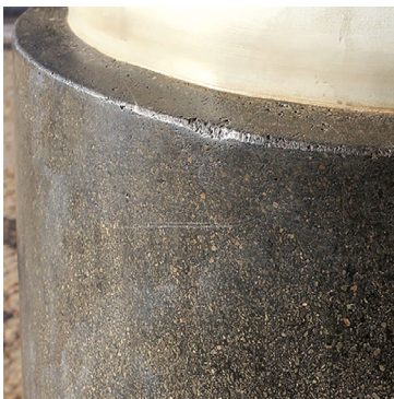
Figura 5.76. Teatro Goiânia. Acesso. Revestimento íntegro, com pequenas lacunas e arranhões.
