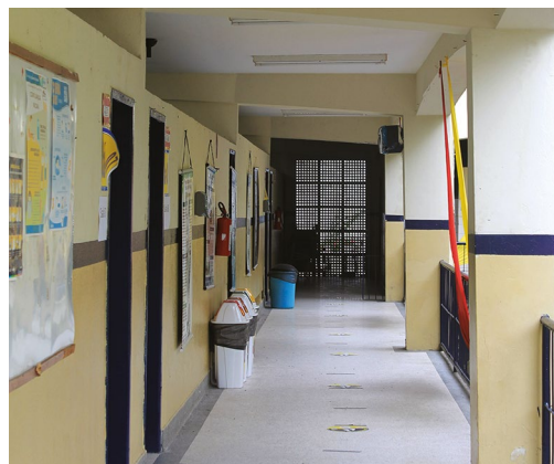
Figura 5.63. Escola Alberto Torres. Observar solução estrutural e de vedações.
