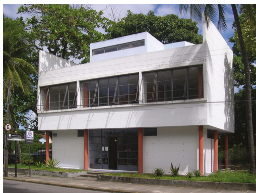
Figura 5.60. Pavilhão Luiz Nunes, em Recife.
