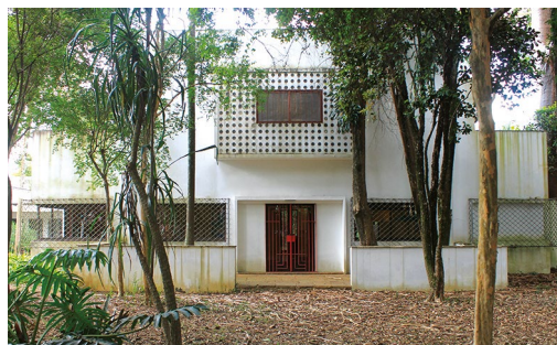
Figura 7.8. Situação atual. Fachada sul. Abertura de grandes dimensões, com esquadria e blocos de vidro, substitui janelas do pavimento superior.
