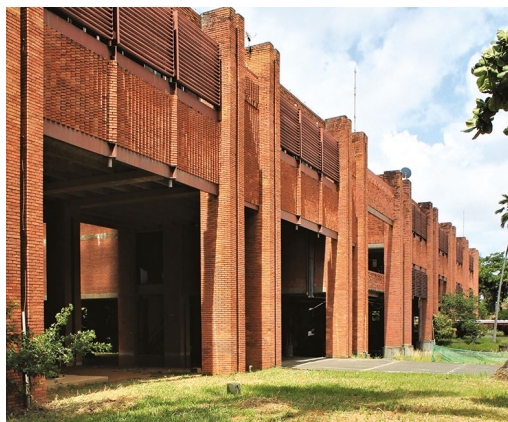
Figura 5.54. Sede da Chesf, vista externa.
