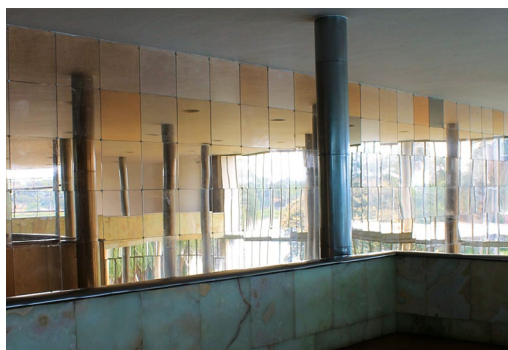
Figura 8.42. Parede de espelhos rosados/bronze. Variações no fornecimento ao longo das ações de manutenção.
