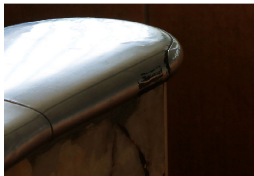
Figura 8.53. Peitoril da escada da tribuna. Encaixes entre as folhas de aço inoxidável.
