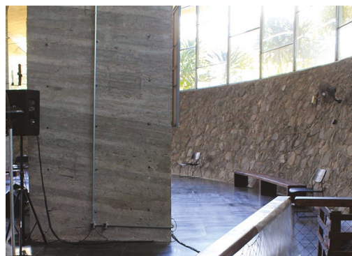
Figura 5.41. Nave. À esquerda, pilar-pétala. À direita, parede e caixilhos perimetrais.
