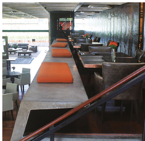
Figura 6.39. Sociedade Harmonia de Tênis. Banco fixo e grelha de cobertura em concreto, divisórias em cobre martelado e mobiliário próprios de uma época.
