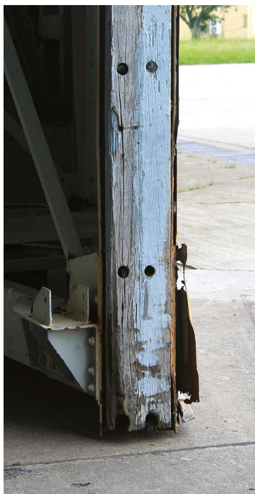
Figura 6.61. Batedor de uma das portas colossais. Perda de pintura, lacunas e abertura de fibras. Peça diretamente associada ao uso dos dirigíveis.
