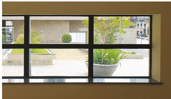
Figura 6.107. Centro Administrativo do TJRJ. Esquadrias laterais, vistas do interior. Perfis comuns de alumínio, com dimensões maiores do que os perfis em aço anteriormente existentes.
