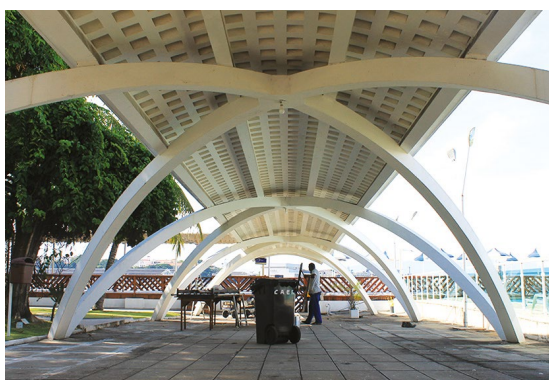
Figura 6.77. Passadiço de embarque, com estrutura em concreto armado.
