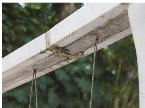
Figura 5.7. Guarda-corpo do terraço, peça partida.
