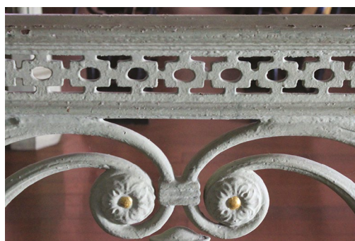
Figura 5.89. Textura adquirida pelo do acúmulo de repinturas nos guarda-corpos.
