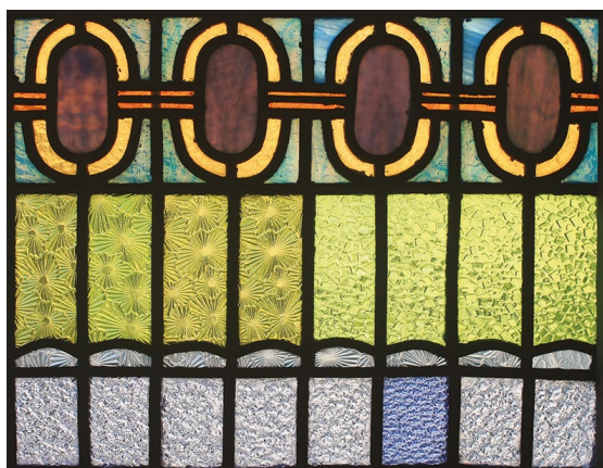
Figura 7.99. Vitrais da sala de visitas. Acúmulo de transformações por meio da manutenção.
