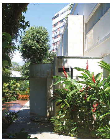
Figura 7.108. Auditório do IMS-RJ, volumes anexados ao pavimento inferior do edifício (1995–1999).
