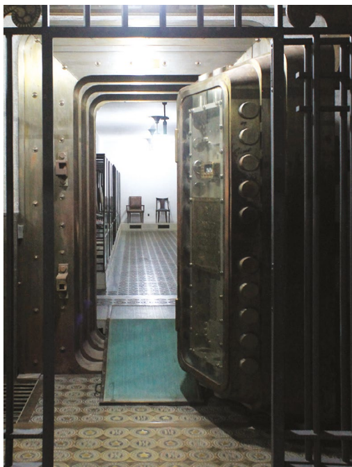
Figura 6.70. Antigo Banco de São Paulo. Reminiscências do uso. Cofre, com portas blindadas e gradis.
