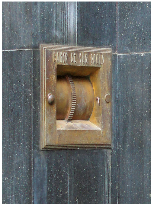
Figura 6.71. Antigo Banco de São Paulo. Reminiscências do uso. Dispositivo para depósitos noturnos, instalado na fachada.
