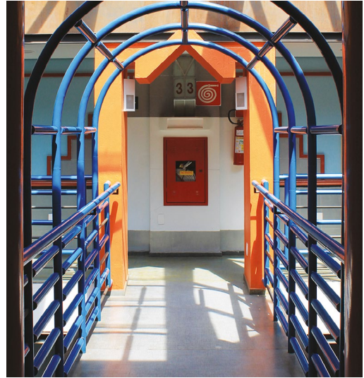
Figura 6.9. Passarela no átrio central. Estrutura decorativa em tubos de aço. Escala incomum para uma abóbada.
