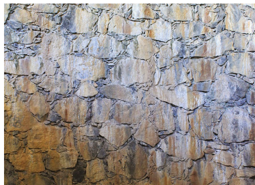
Figura 5.43. Capela do Santíssimo Sacramento. Alvenaria de pedra com manchas em tons de cinza e ocre.
