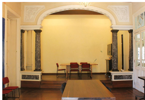
Figura 7.90. Sala de visitas. Desnível, arco em asa de cesto e colunas de mármore, inseridos na reforma de 1928.
