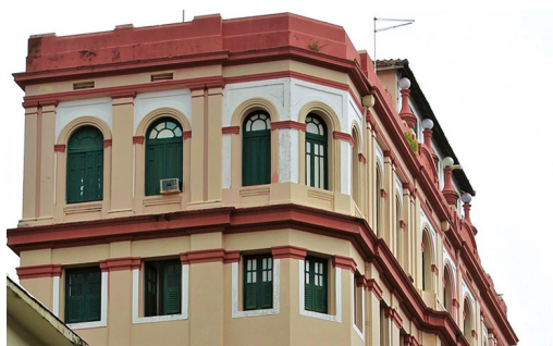
Figura 7.105. Hotel Central (Recife), coroaamento. No alto, à direita, volume adicionado ao terraço da cobertura.
