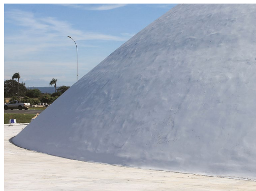
Figura 5.71. Cúpula do plenário do Senado, Palácio do Congresso Nacional. Textura resultante das sucessivas repinturas sobre a estrutura em concreto.
