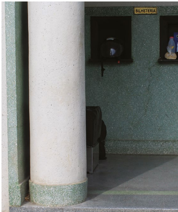
Figura 5.74. Rádio Difusora de Caruaru. Diferentes cores e texturas dos revestimentos em granilite conformam o átrio de acesso. Criação de textura pelas repinturas.
