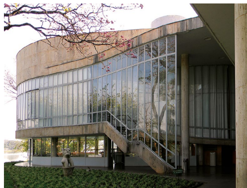
Figura 8.24. Pórtico, com laje e pano de vidro que se fundem ao volume do bar/restaurante.
