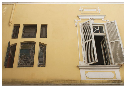
Figura 7.93. Fachada leste. Contraste formal entre aberturas de 1901 (direita) e de 1928 (esquerda).
