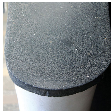
Figura 5.77. Teatro Goiânia. Corrimão interno. Revestimento íntegro, com pequenas lacunas e arranhões, evocando seu uso continuado.
