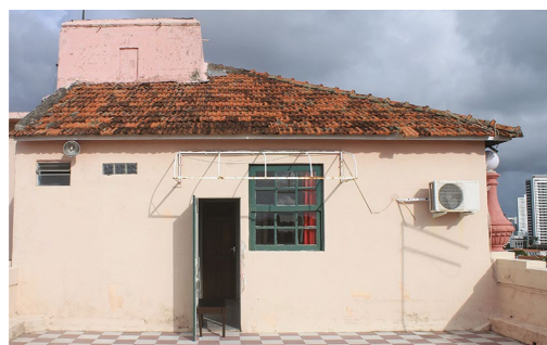
Figura 7.106. Volume adicionado à cobertura do Hotel Central. À direita, observar interferência com elemento decorativo da platibanda.
