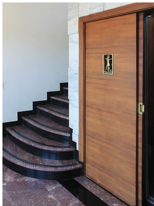
Figura 6.104. Palácio das Esmeraldas. Portas externas do elevador.
