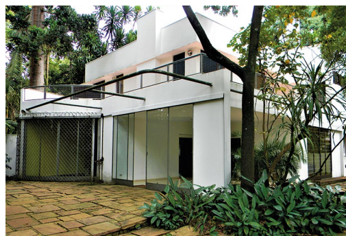
Figura i.12. Casa da Rua Santa Cruz. 1927. São Paulo.
