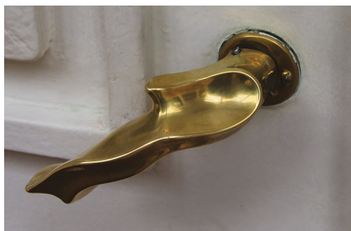
Figura 5.24. Instituto Moreira Salles. Maçaneta em latão. Observar ausência de marcas do tempo.
