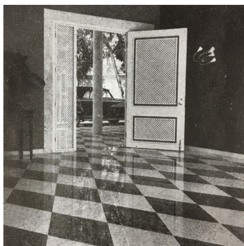
Figura 5.6. Piso do vestíbulo, 1951. Observar polimento. 12
