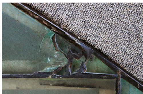
Figura 8.57. Placas de vidro do auditório. Detalhe.
