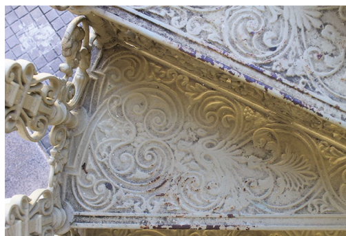
Figura 5.90. Suavização dos relevos, em função do acúmulo de repinturas nas escadas.
