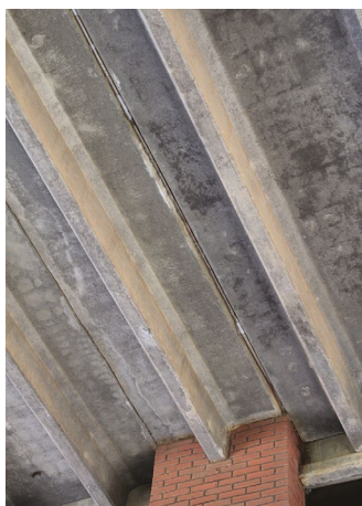
Figura 5.48. Chesf. Concreto íntegro, marcado pelo tempo.
