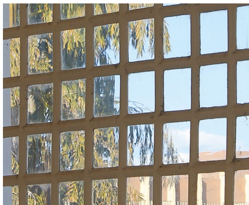
Figura 5.105. Estação Ferroviária de Goiânia. Variações de textura entre vidros irregulares e vidros perfeitamente planos, correspondentes a diferentes momentos de fornecimento.
