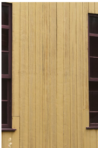
Figura 5.113. Casa da Neni. Textura da madeira da fachada, visível apesar das repinturas.
