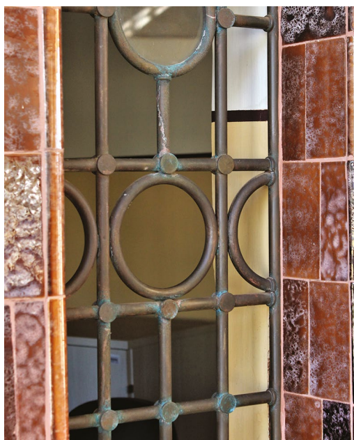
Figura 5.34. Estação Ferroviária de Goiânia. Gradil da bilheteria, em latão e vidro, com sua pátina característica.
