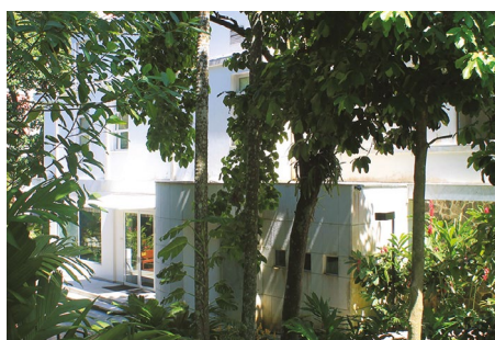
Figura 7.107. Vista da fachada nordeste, com o acréscimo do auditório no pavimento inferior (1995–1999).
